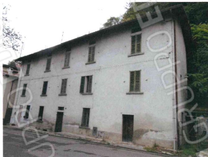
Foto 02 - Prospetti Ovest e Sud edificio.JPG
