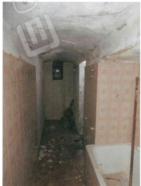
Foto 10 - Bagno porzione sud.JPG
