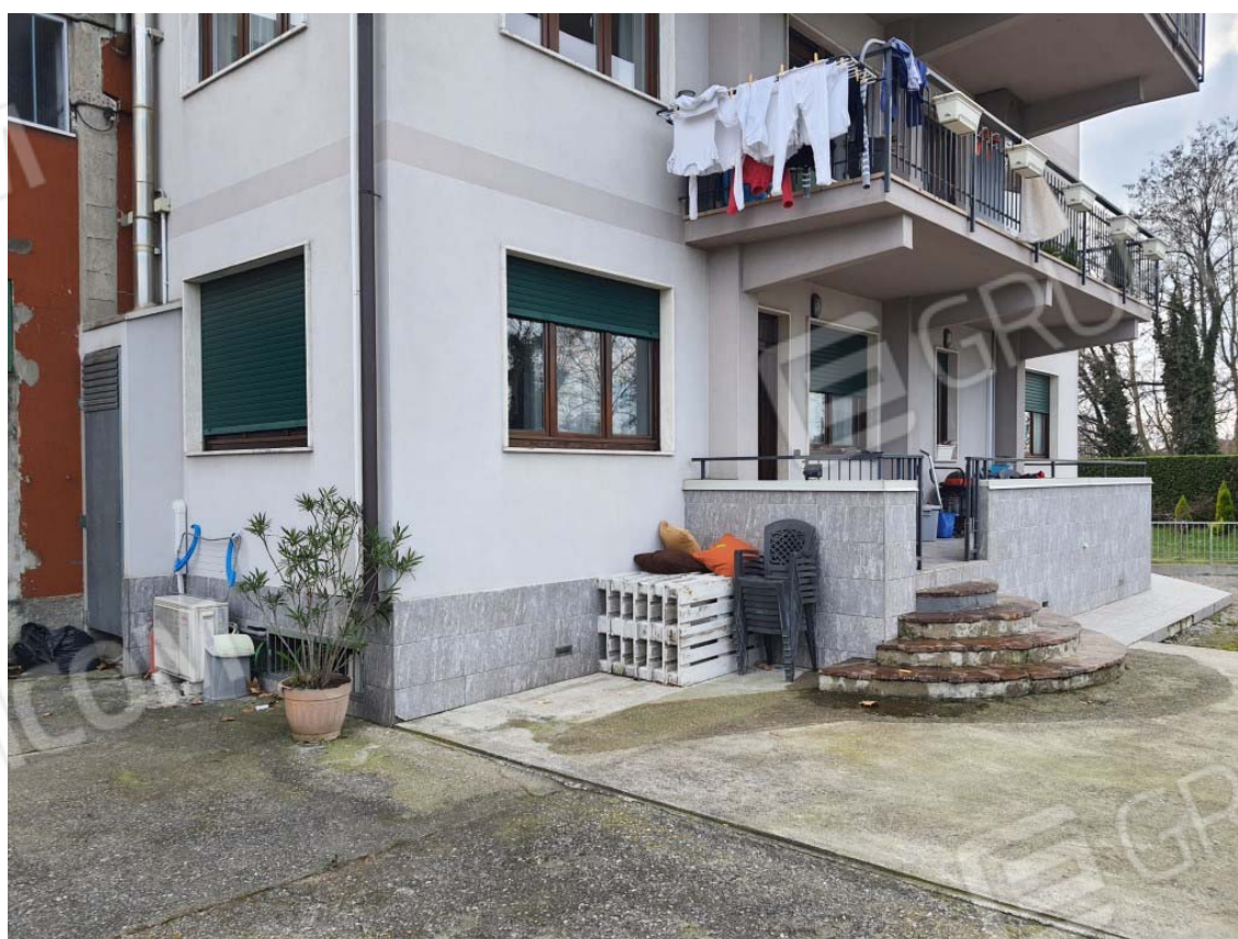
RILIEVO ESTERNO – Foto 3 e 4. Ripresa esterna del fabbricato. Identificazione della posizione degli immobili oggetto di esecuzione (Subb. 703 e 702).
