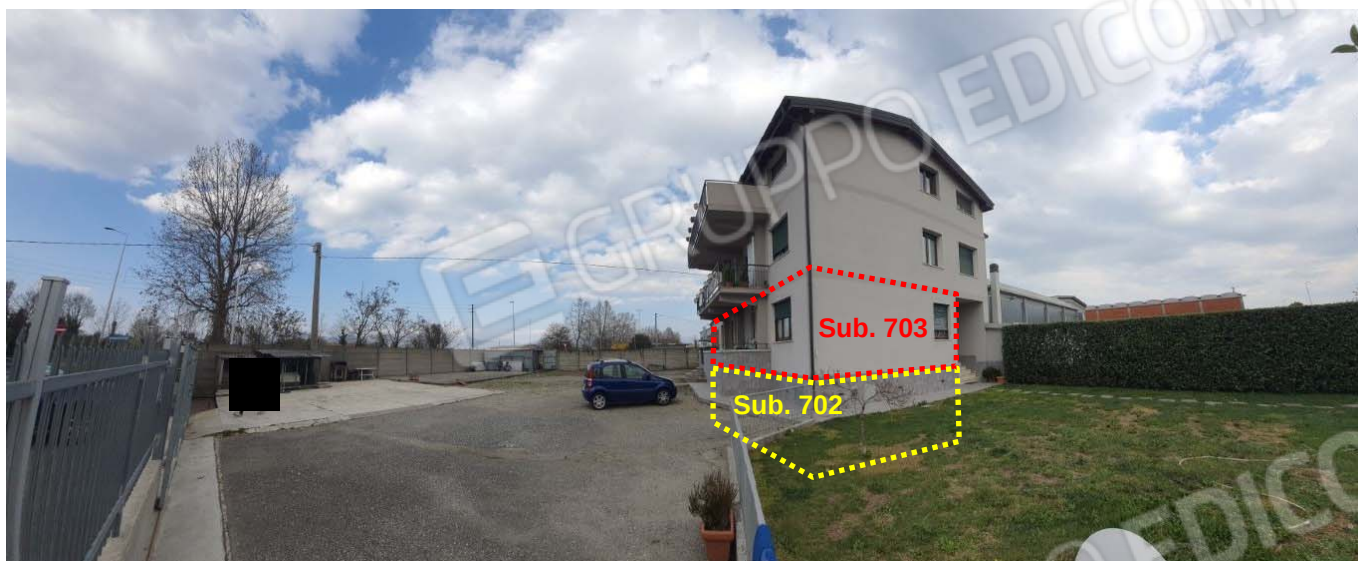
RILIEVO ESTERNO – Foto 5.
