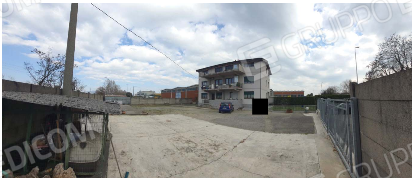
RILIEVO ESTERNO – Foto 2.
