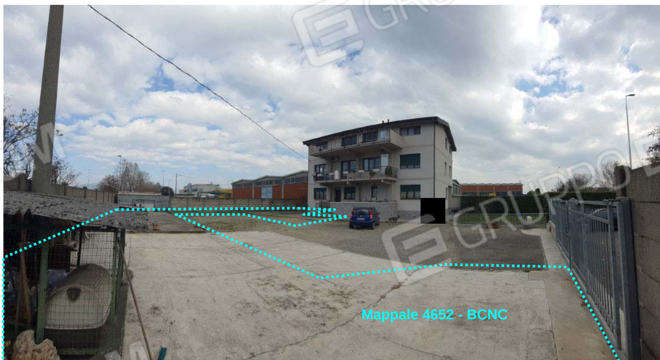
RILIEVO ESTERNO – Foto 6.
