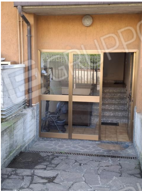
PORTA D'INGRESSO E SCALE CONDOMINIALI
