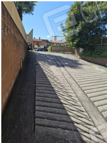
RAMPA D'ACCESSO CONDOMINIALE
