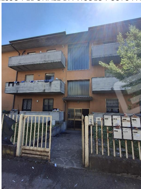
INGRESSO PEDONALE DA VICOLO POSTO A NORD
