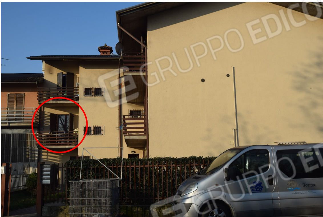
1 – FRONTE EST EDIFICIO (su via Cascina Spina)
