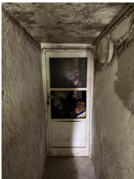
ripostiglio piano terra
