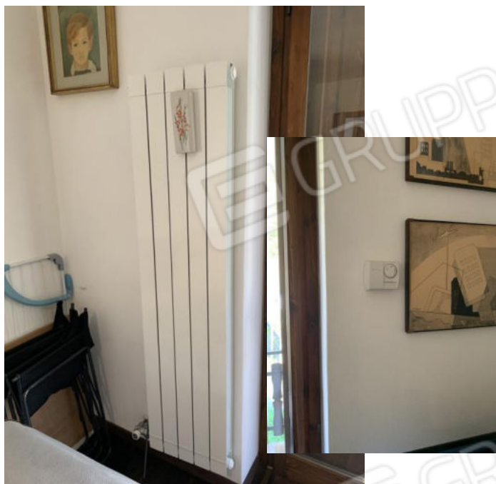
Impianto di riscaldamento autonomo con elementi radianti in alluminio
