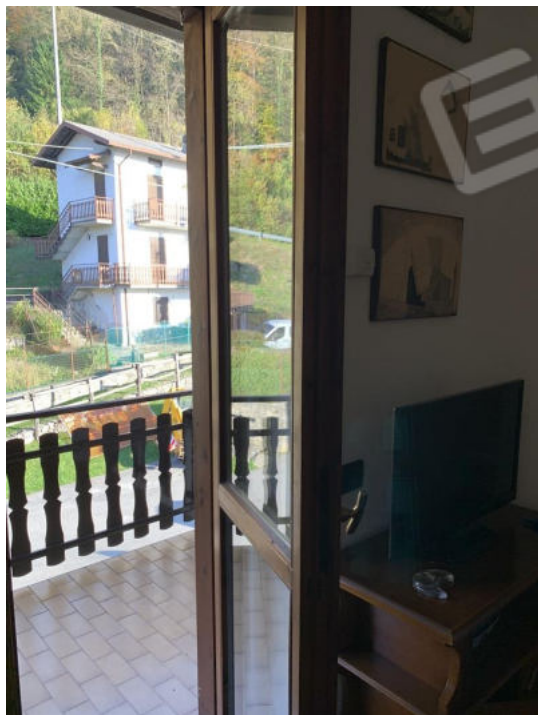
Serramenti perimetrali in legno con doppio vetro e scuri di protezione sempre in legno
