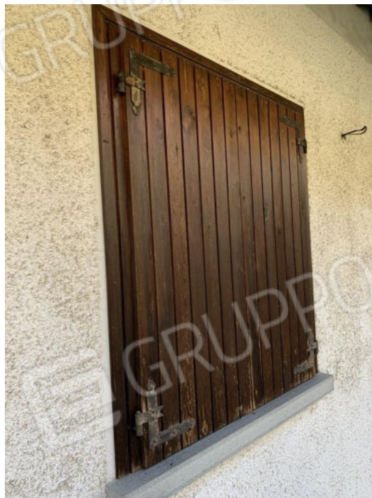
Serramenti perimetrali in legno con doppio vetro e scuri di protezione sempre in legno
