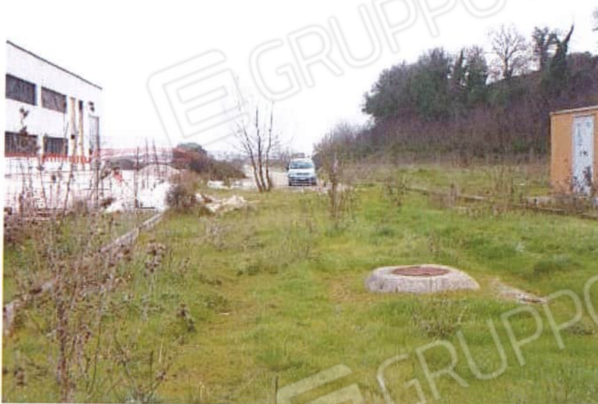
Foto n. 19 - tratto della Via S. Pertini non ultimato
