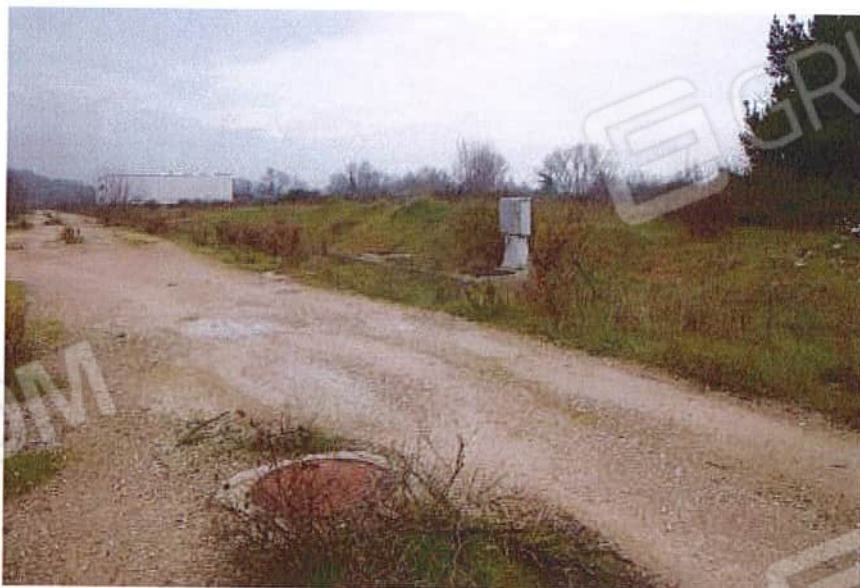
Foto n. 16 - tratto della Via S. Pertini non ultimato
