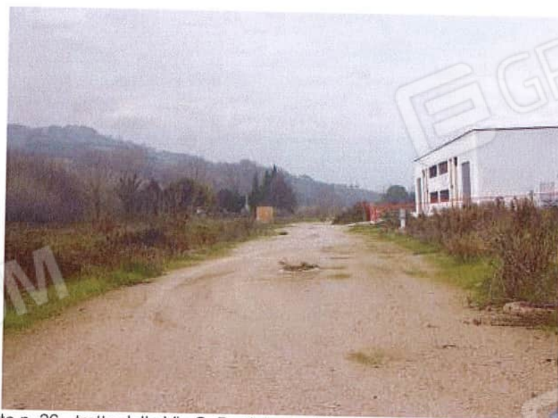
Foto n. 26 - tratto della Via S. Pertini non ultimato
