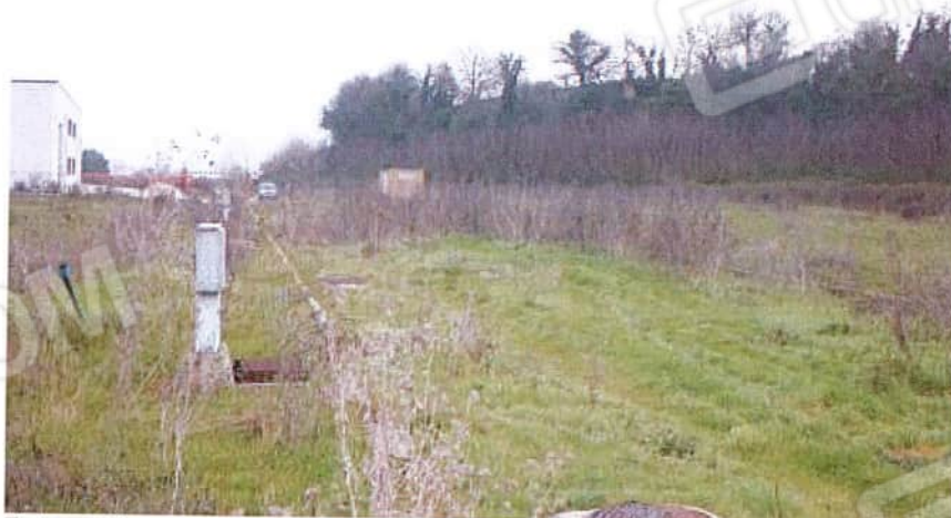
Foto n. 24 - tratto della Via S. Pertini non ultimato
