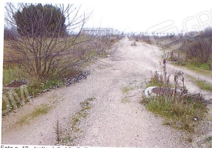
Foto n. 18 - tratto della Via S. Pertini non ultimato
