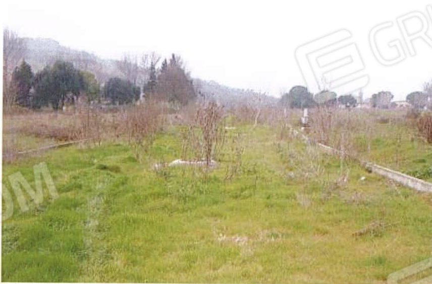
Foto n. 20 - tratto della Via S. Pertini non ultimato
