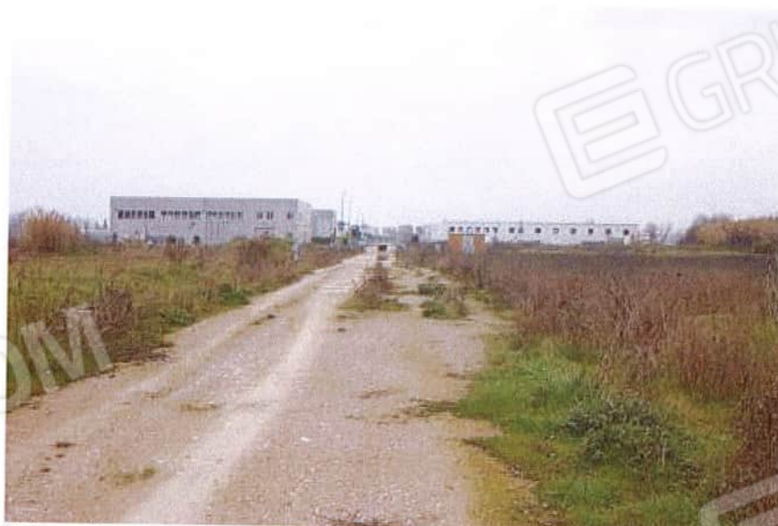
Foto n. 14 - tratto della Via S. Pertini non ultimato
