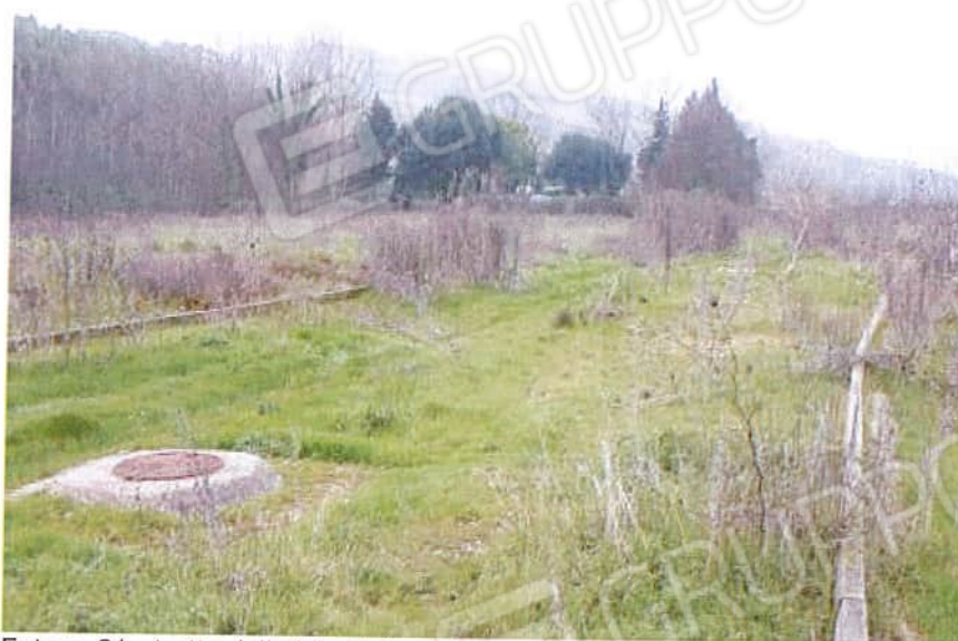
Foto n. 21 - tratto della Via S. Pertini non ultimato
