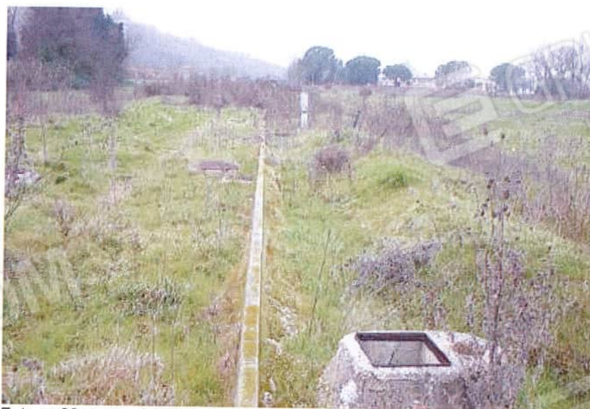
Foto n. 22- tratto della Via S. Pertini non ultimato
