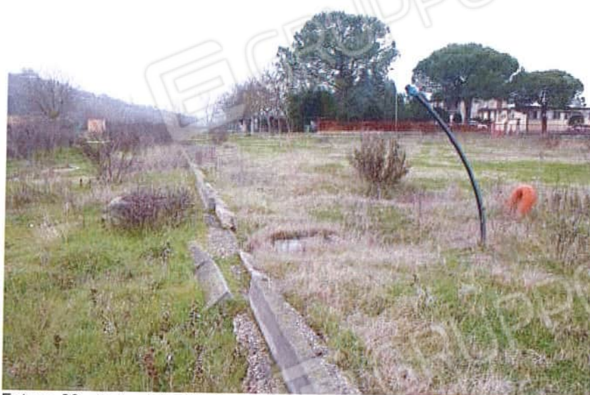
Foto n. 23 - tratto della Via S. Pertini non ultimato
