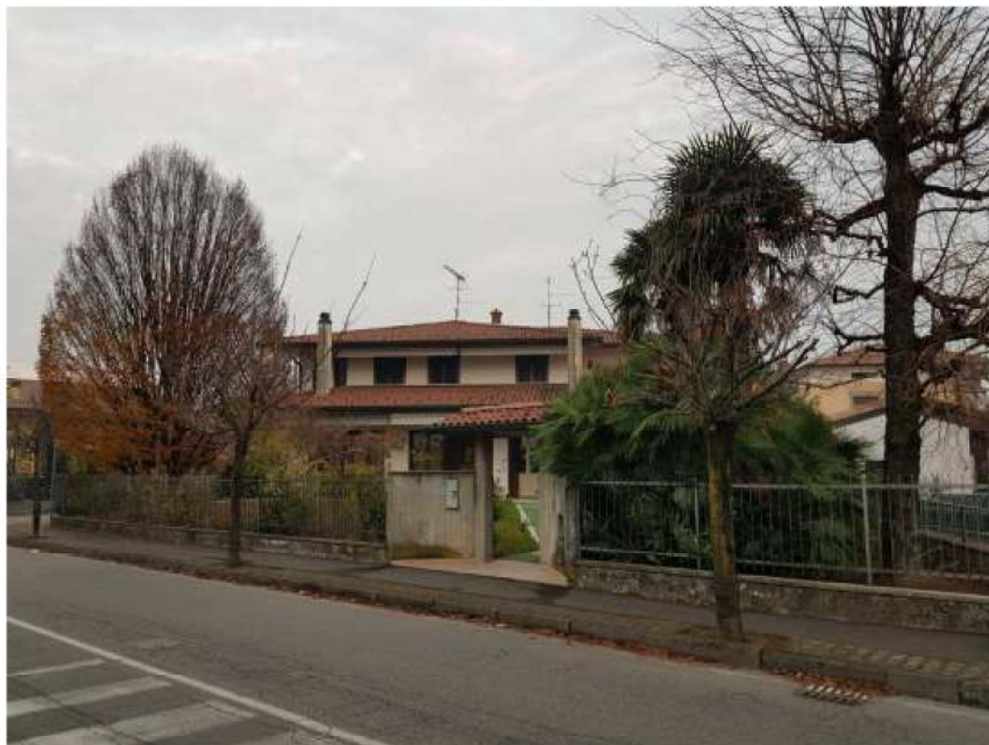
Vista edificio da via Kennedy con ingresso pedonale
