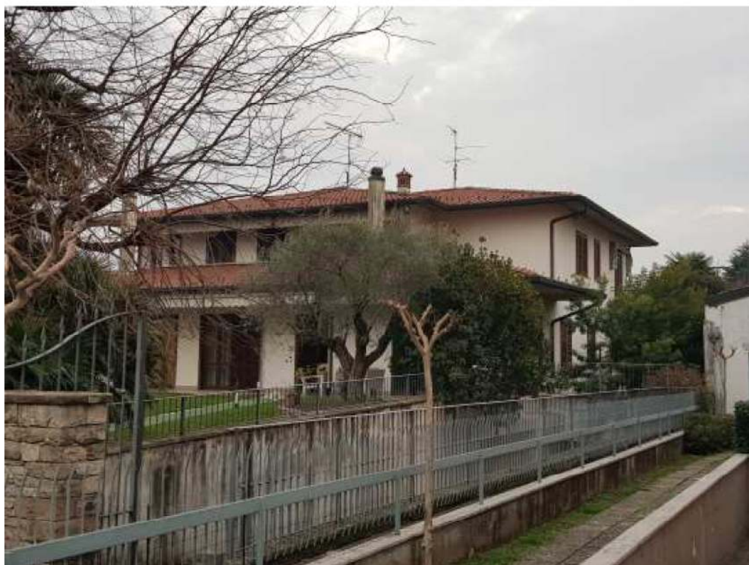
Vista edificio da via Kennedy con scivolo accesso al piano interrato
