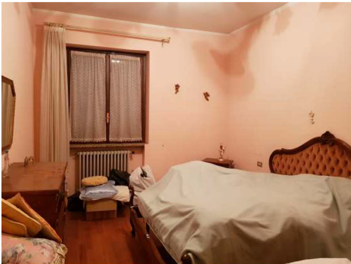
Vista camera 01 ALLOGGIO al piano PRIMO
