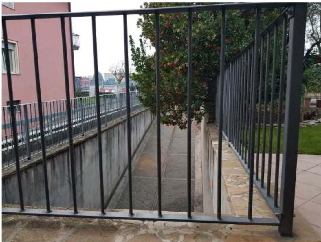
Vista scivolo accesso al piano interrato
