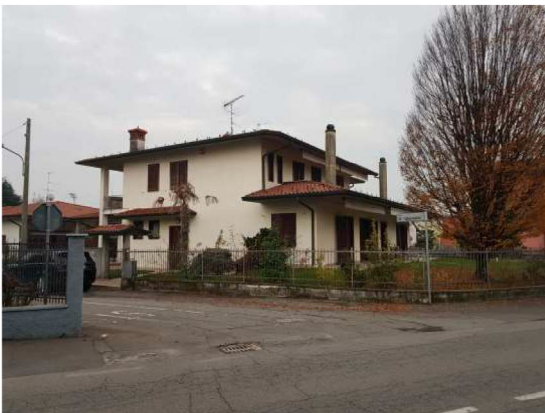
Vista edificio dall'incrocio di via Kennedy con via X Giornate
