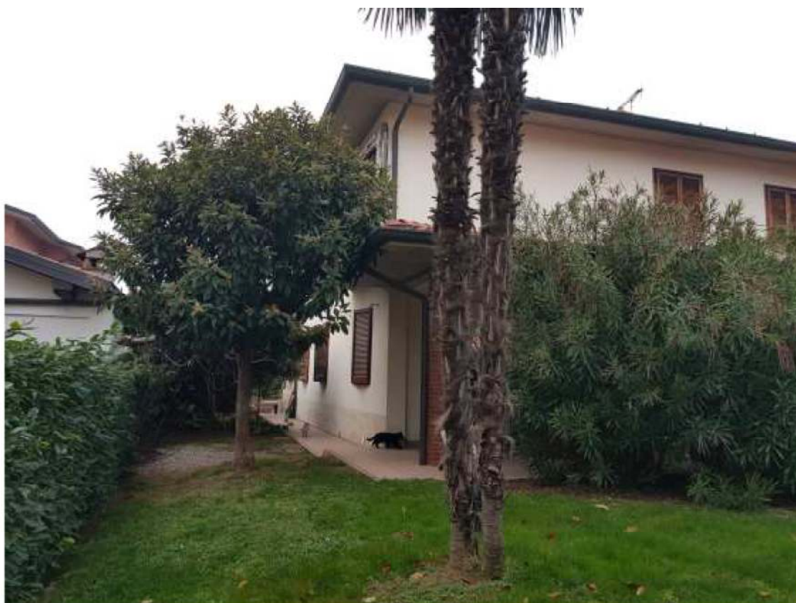
Vista prospetto SUD-EST edificio
