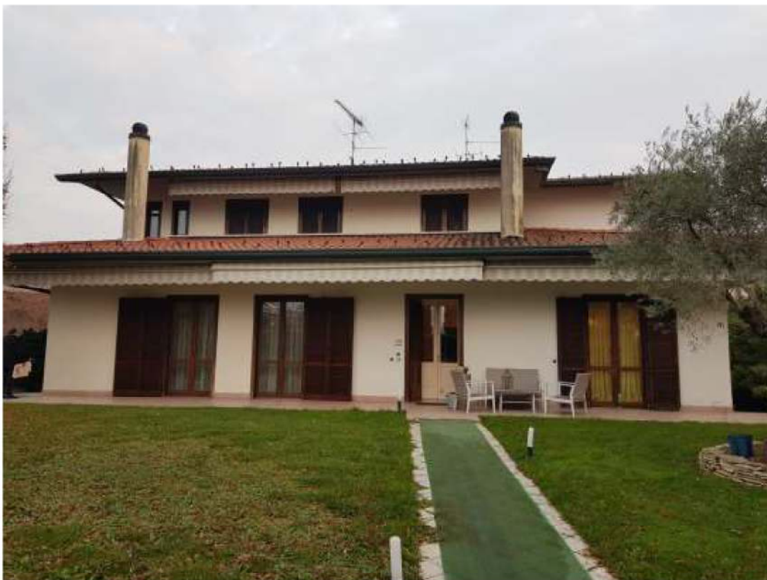
Vista edificio prospetto principale verso OVEST
