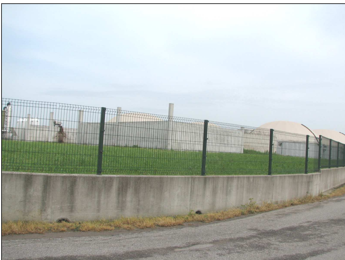
7 - manufatto di essiccazione e digestori
