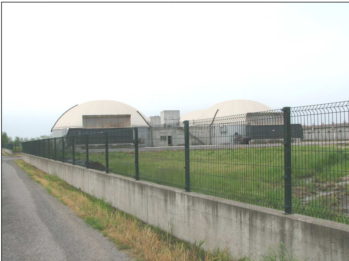
9 - veduta 2 caricatori lato nord e digestori
