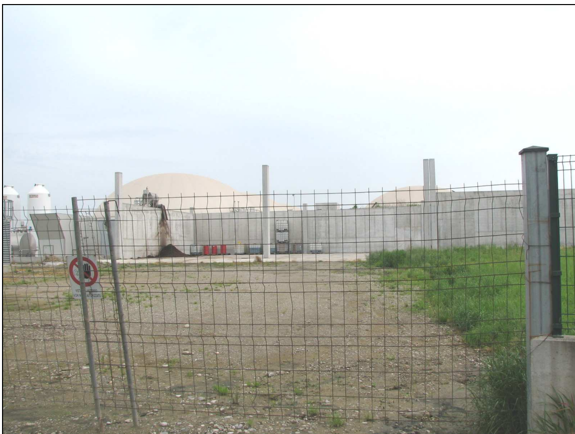
5 - manufatto di essiccazione e separazione (non denunciato in Catasto)
