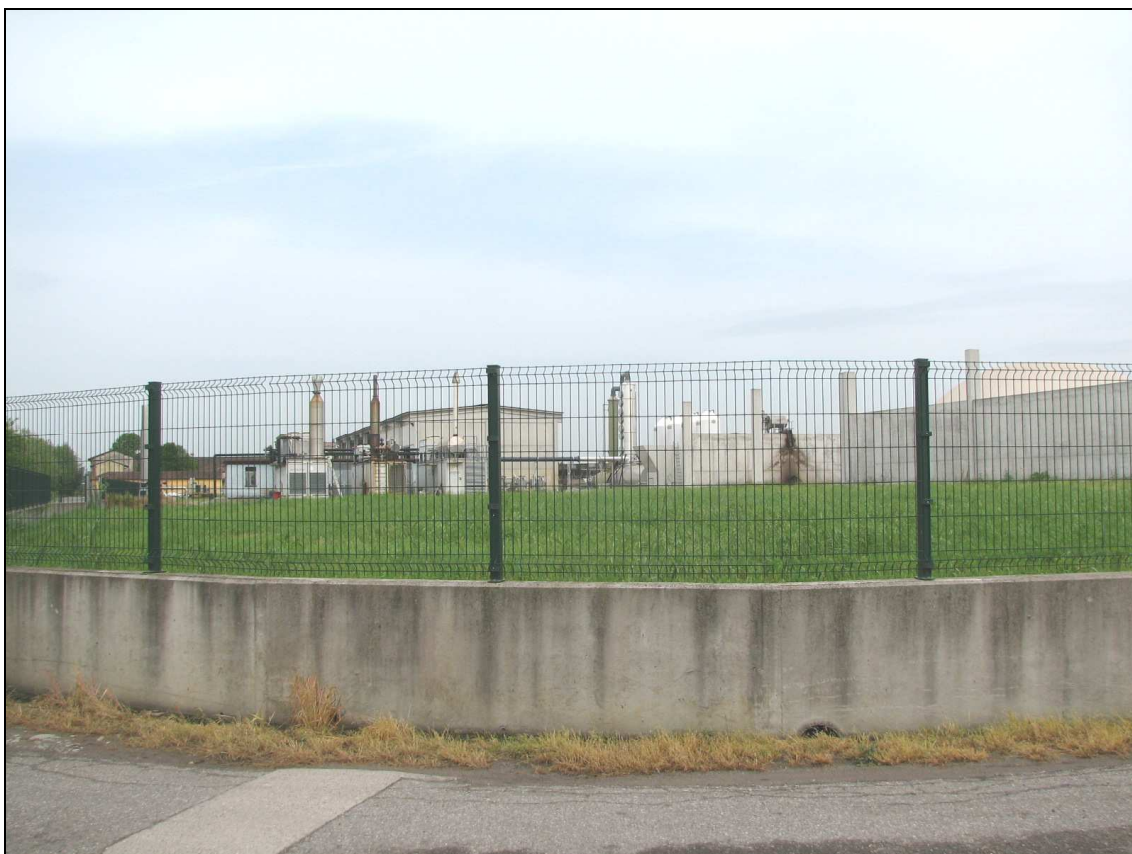
6 - veduta motori e manufatto di essiccazione
