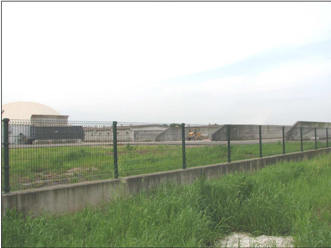
10 - caricatore lato nord e trincee
