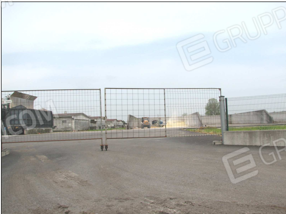
11 - trincee di stoccaggio precarico
