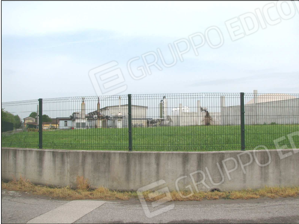
6 - veduta motori e manufatto di essiccazione
