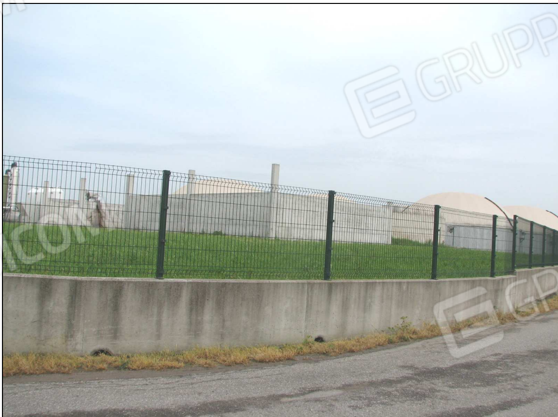
7 - manufatto di essiccazione e digestori
