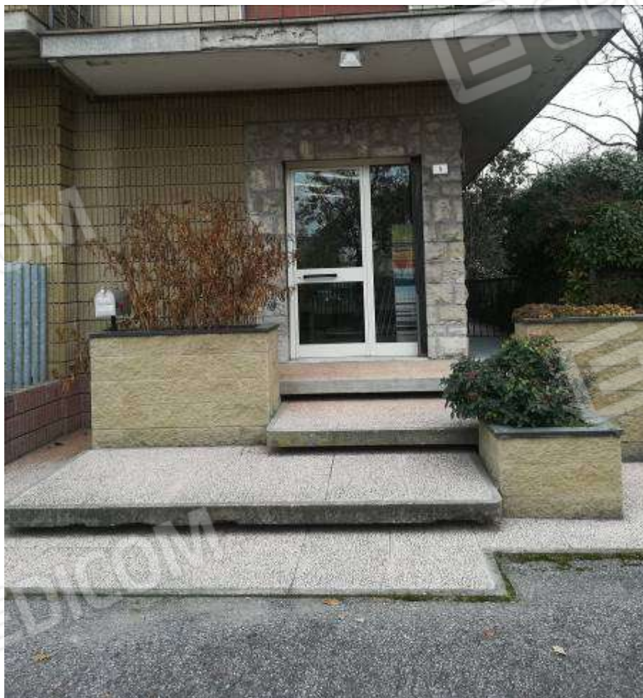
All. 5 – Corpo A – entrata esposizione da Via Firenze
