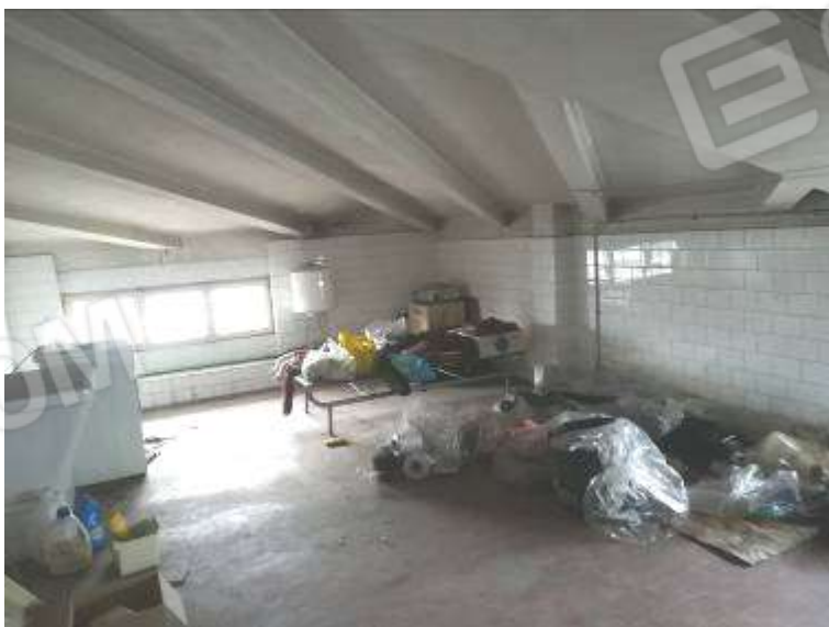
All. 56 – Sottotetto sub. 8 lato Sud-Ovest
