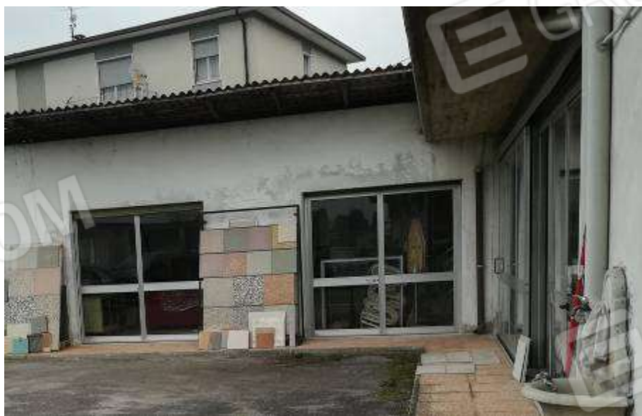
All. 7 – Corpo A – esposizione – lato SUD
