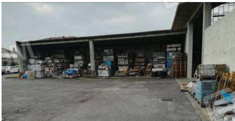
All. 17 – Corpo C – deposito – lato SUD
