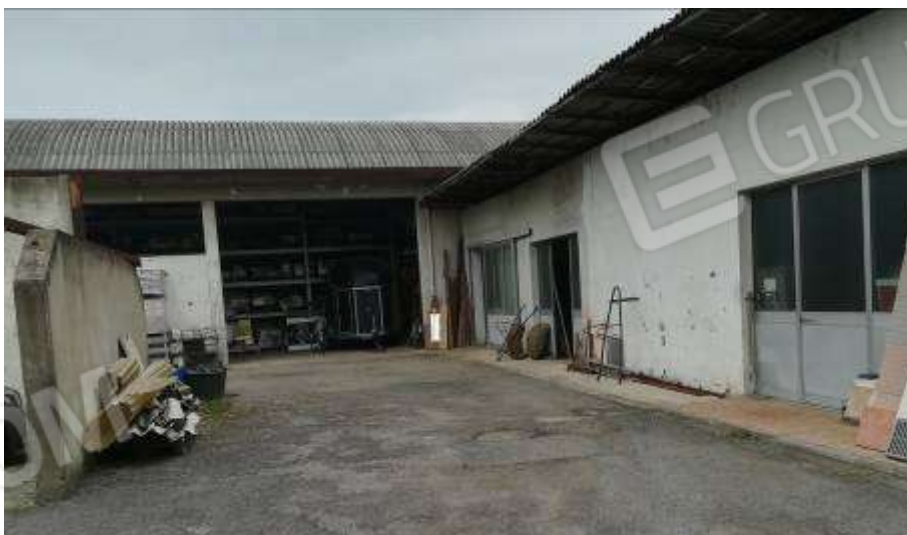
All. 10 – Corpo B – deposito – lato NORD - OVEST
