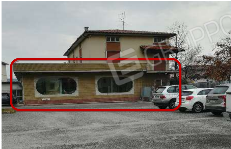
All. 6 – Corpo A – esposizione – lato SUD
