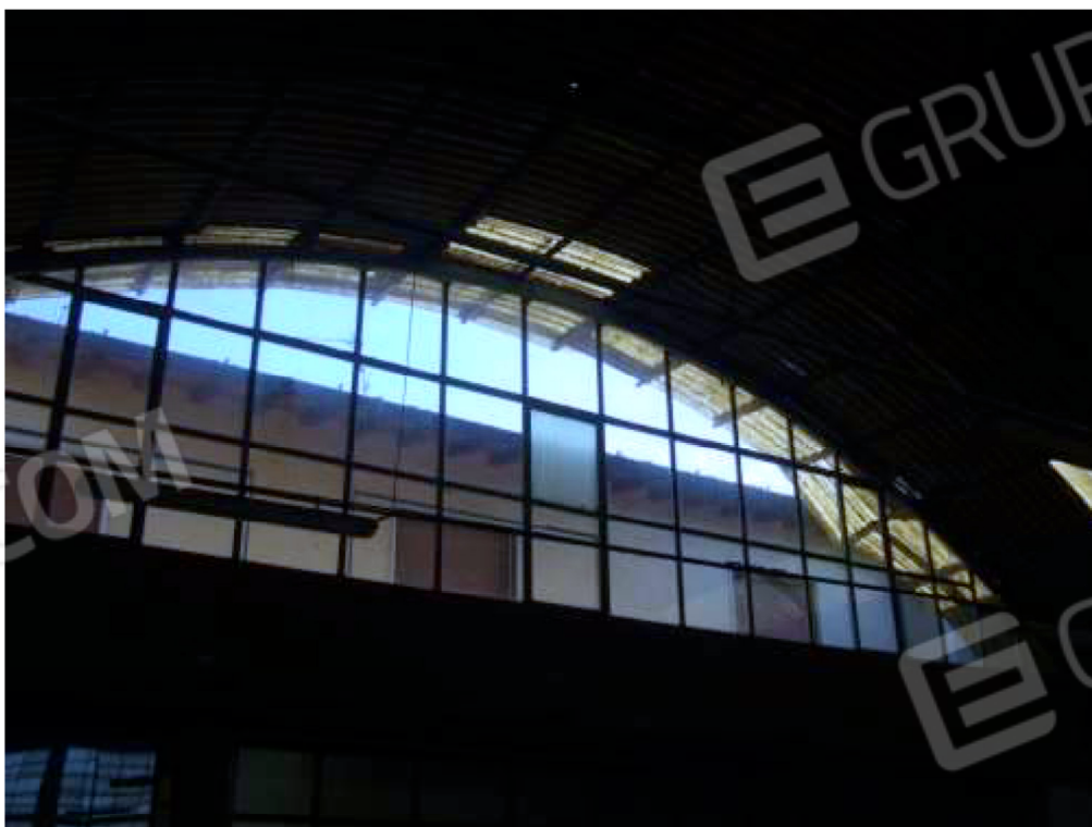
Fotografia n. 28 - Particolare della vetrata del capannone sul lato nord in aderenza con la terrazza dei subalterni 3 e 4
