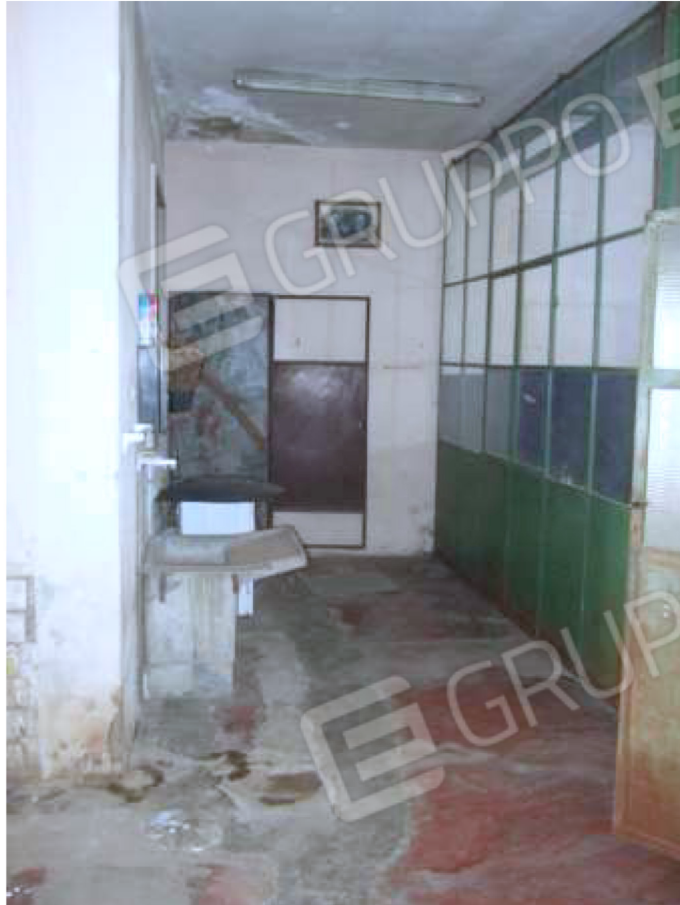
Fotografia n. 25 - Accesso al locale caldaia di pertinenza del subalterno 4
