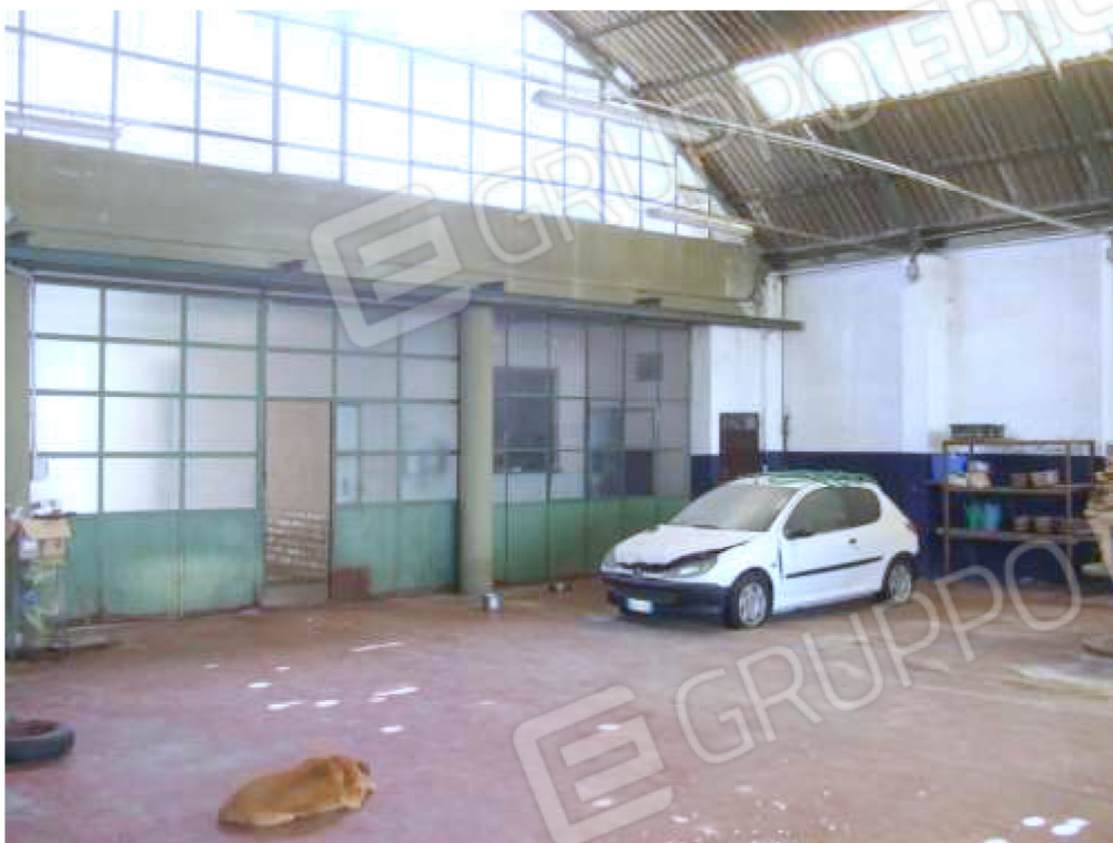
Fotografia n. 27 - Fronte nord del capannone destinato a magazzino
