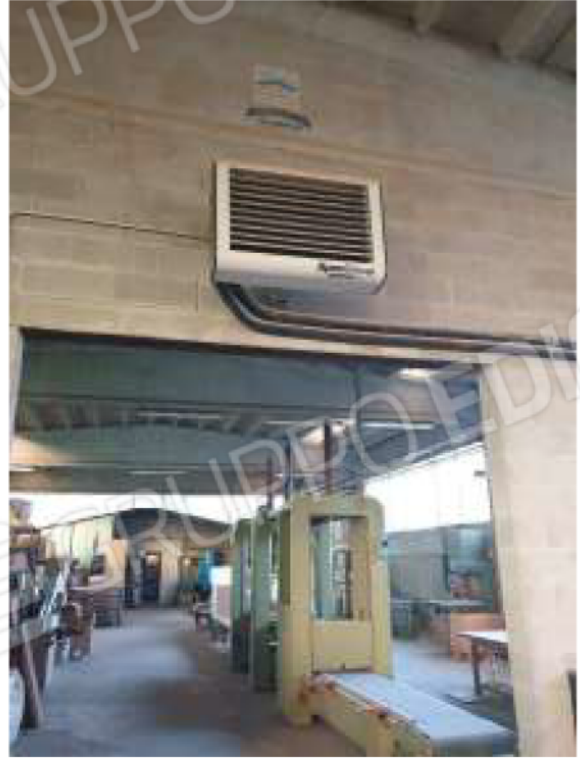
Interno laboratorio nord
