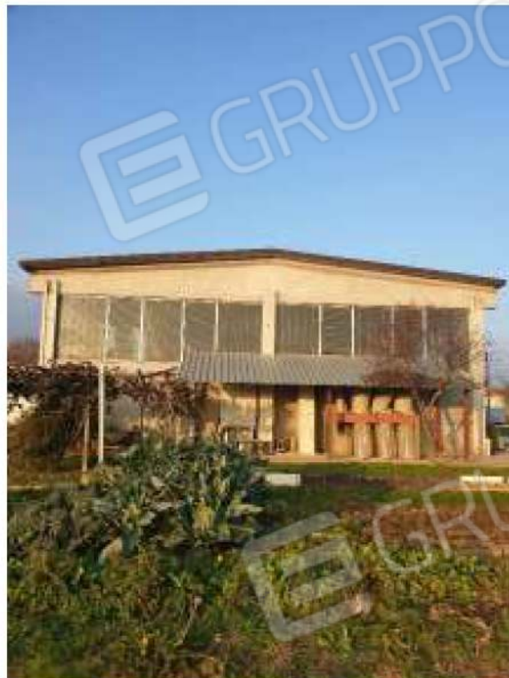
Facciata sud capannone
