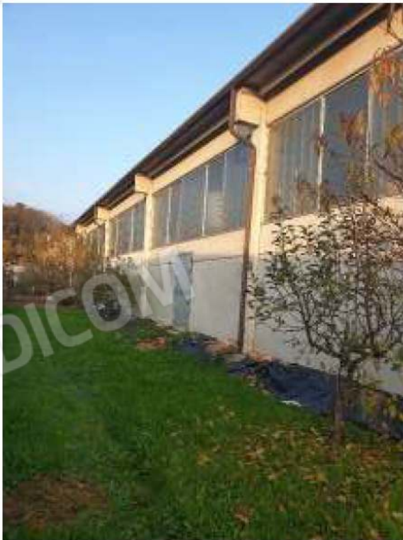
Facciata ovest capannone
