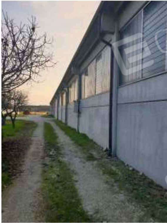
Facciata est capannone
