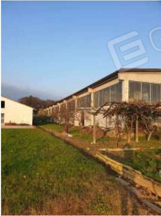
Facciata ovest capannone
