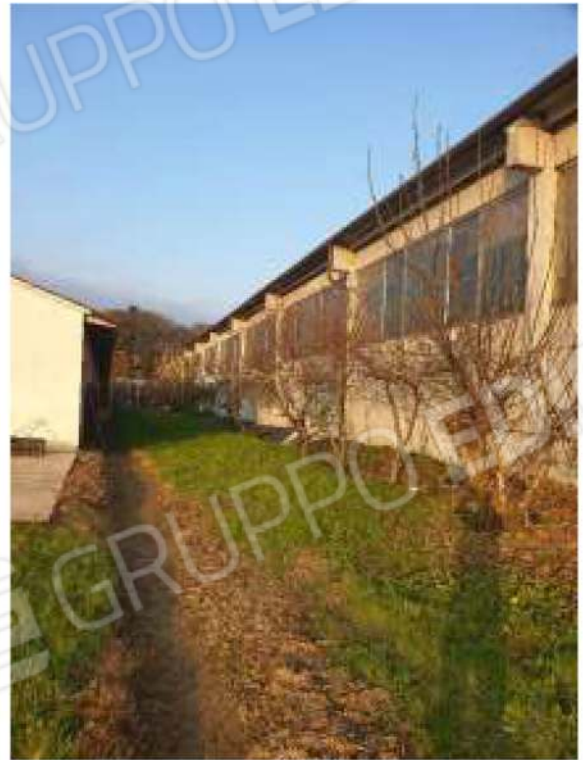
Facciata ovest capannone
