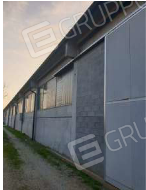
Facciata est capannone
