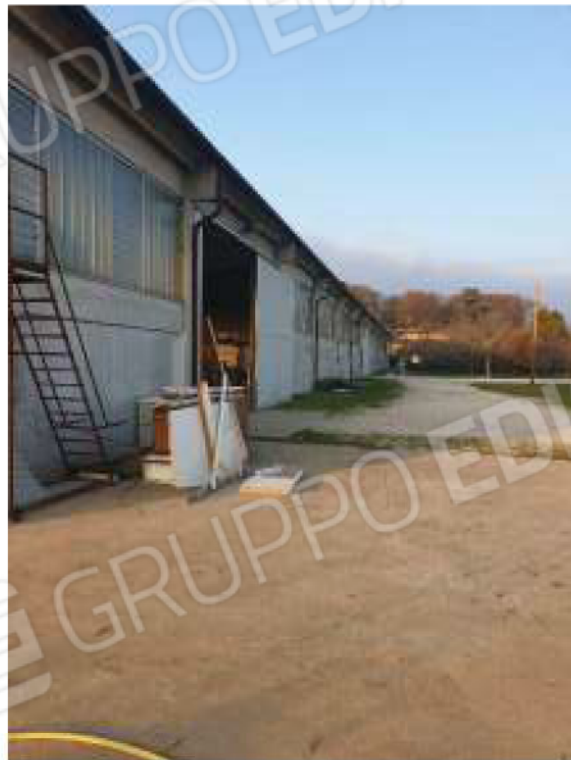
Facciata est capannone
