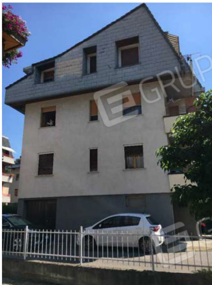
Facciata Ovest non interessata dall'esecuzione
