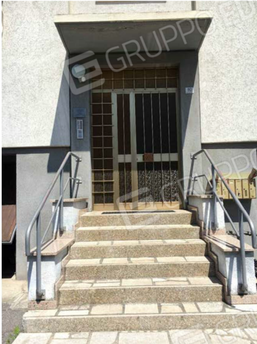
PARTICOLARE INGRESSO CONDOMINIO SU SCALA COMUNE
