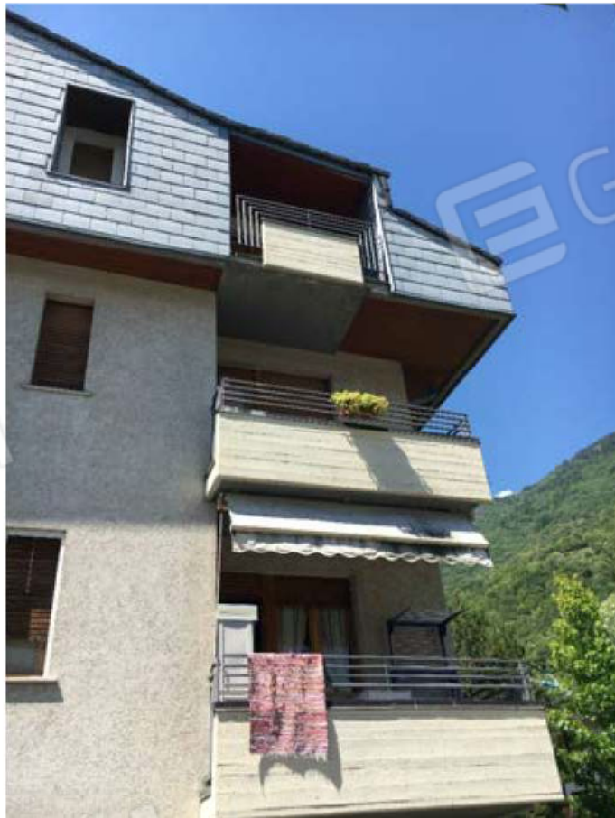
Particolare balconi facciata Est
