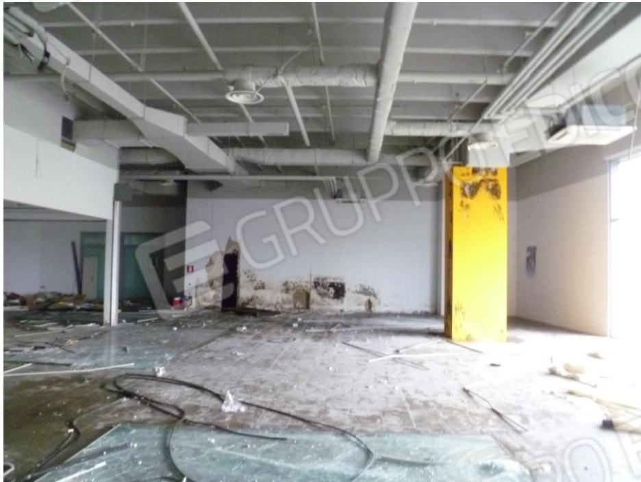
21) Fotografia riprendente il bene CORPO E catastalmente identificato nel Comune di Orzinuovi, fg. 11 mappale 580 (piano terra)
