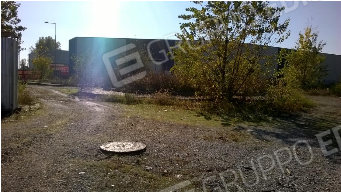
5) Rotonda e strada non completate
