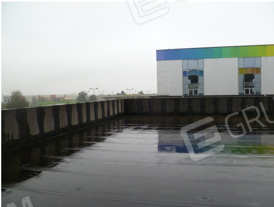
16) Fotografia riprendente il bene CORPO C catastalmente identificato nel Comune di Orzinuovi, fg. 11 mappale 580 sub. 53 (terrazza piano primo)
