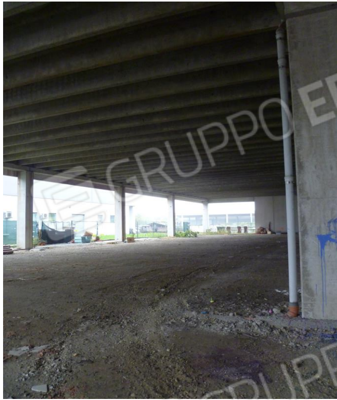
13) Fotografia riprendente il bene CORPO C catastalmente identificato nel Comune di Orzinuovi, fg. 11 mappale 580 sub. 54 (piano terra).
