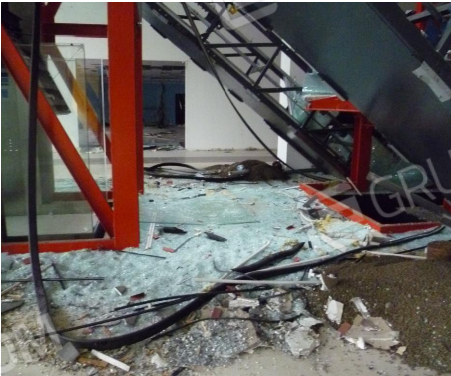
26) Fotografia riprendente le scale mobili ed il vano scala del bene catastalmente identificato nel Comune di Orzinuovi, fg. 11 mappale 580
