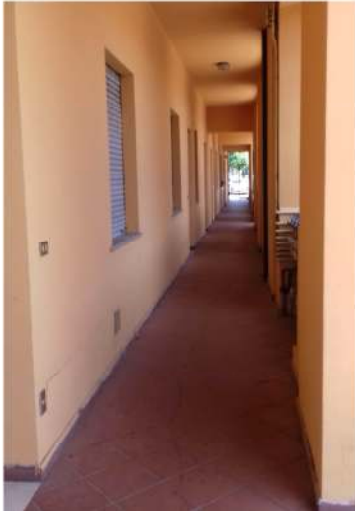
FOTO 2: CORRIDOIO PEDONALE DI ACCESSO AGLI APPARTAMENTI
