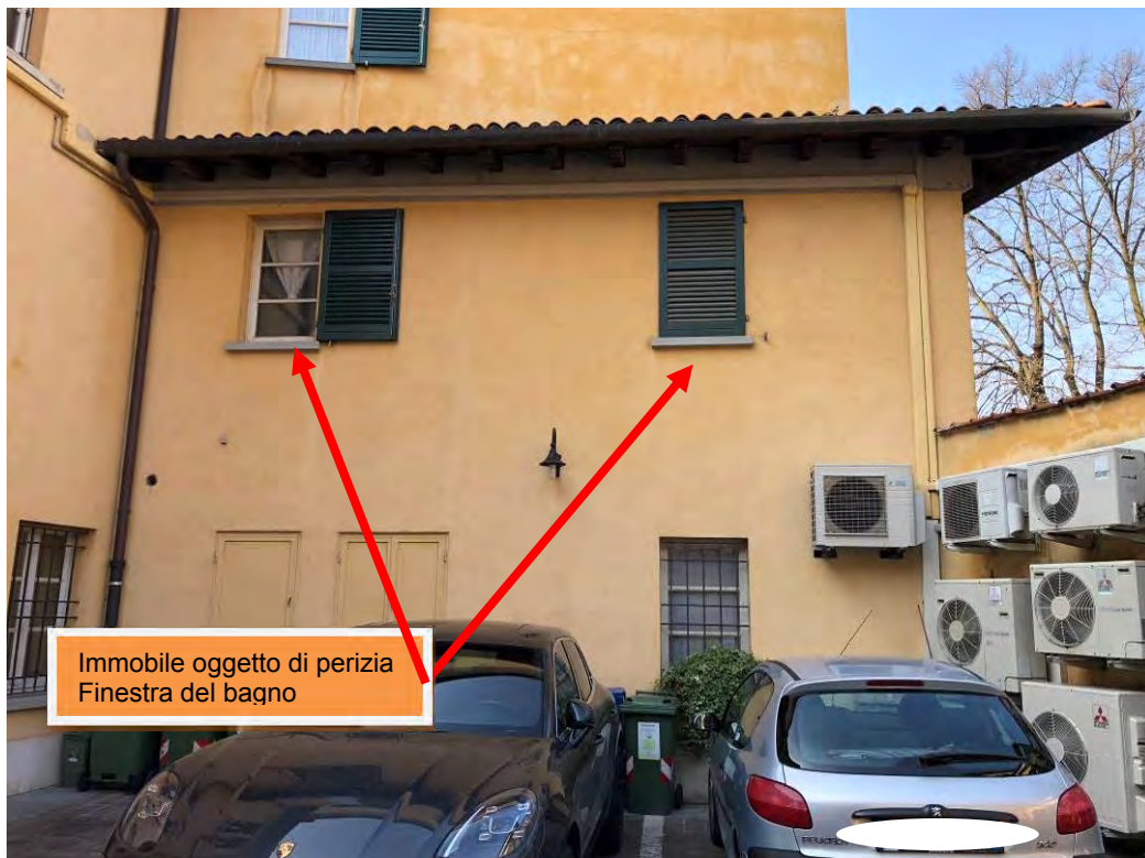
Vista dalla corte interna
