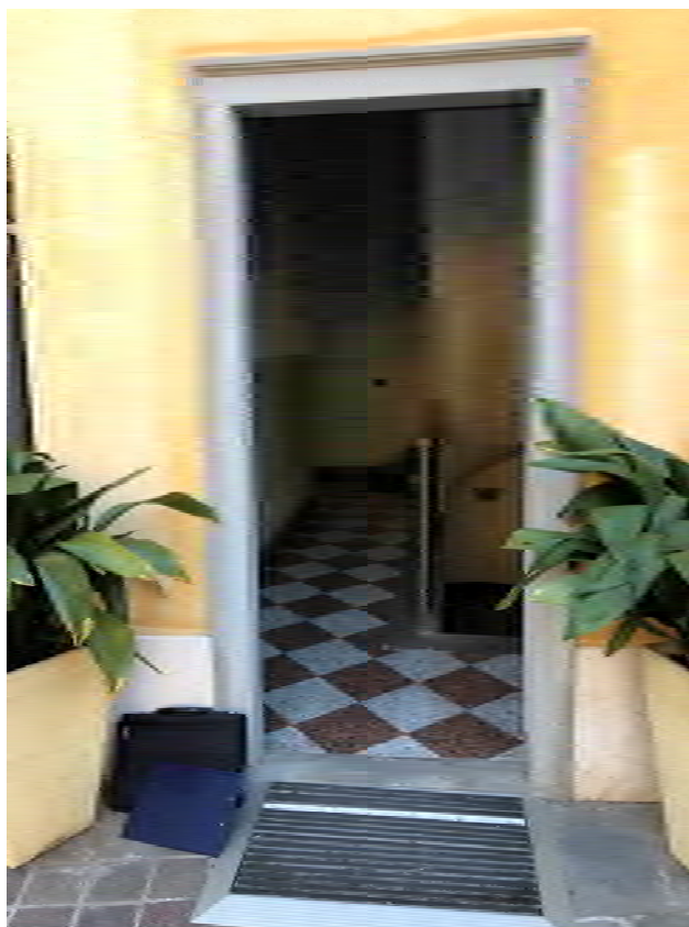
Ingresso al pianerottolo comune al piano terra dal cortile interno
