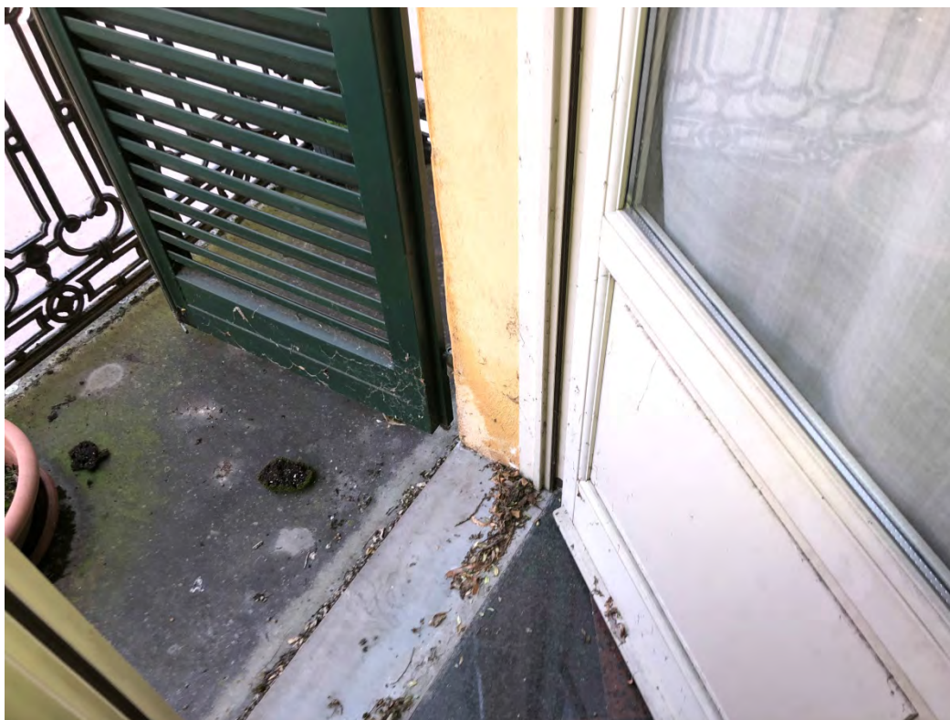
Particolare sugli infissi in legno con doppio vetro e griglie esterne sul balcone
