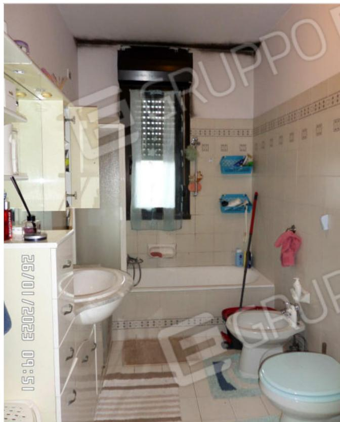
FOTO 16: Bagno finestrato (N.B. presenza di muffa)
