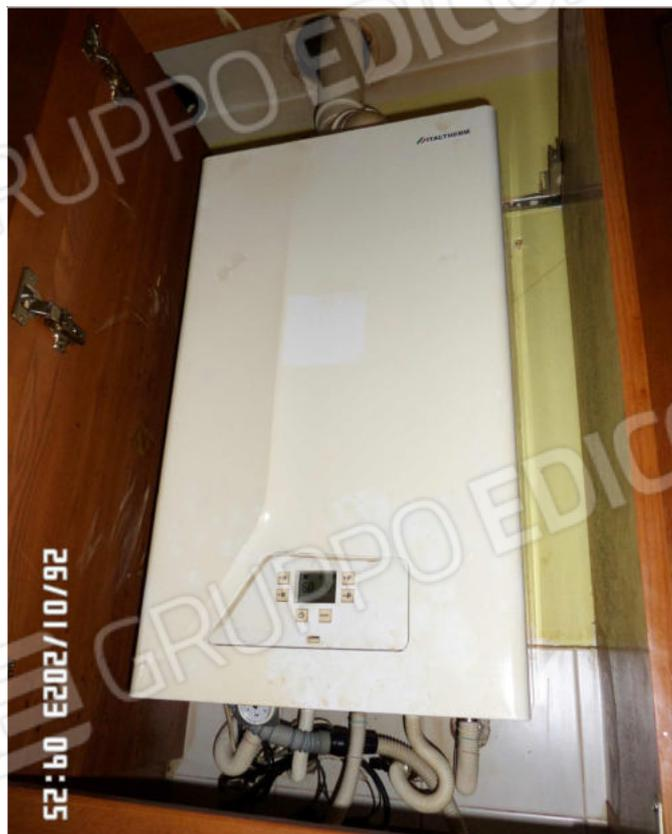
FOTO 14: Caldaia alloggiata in un pensile della cucina
