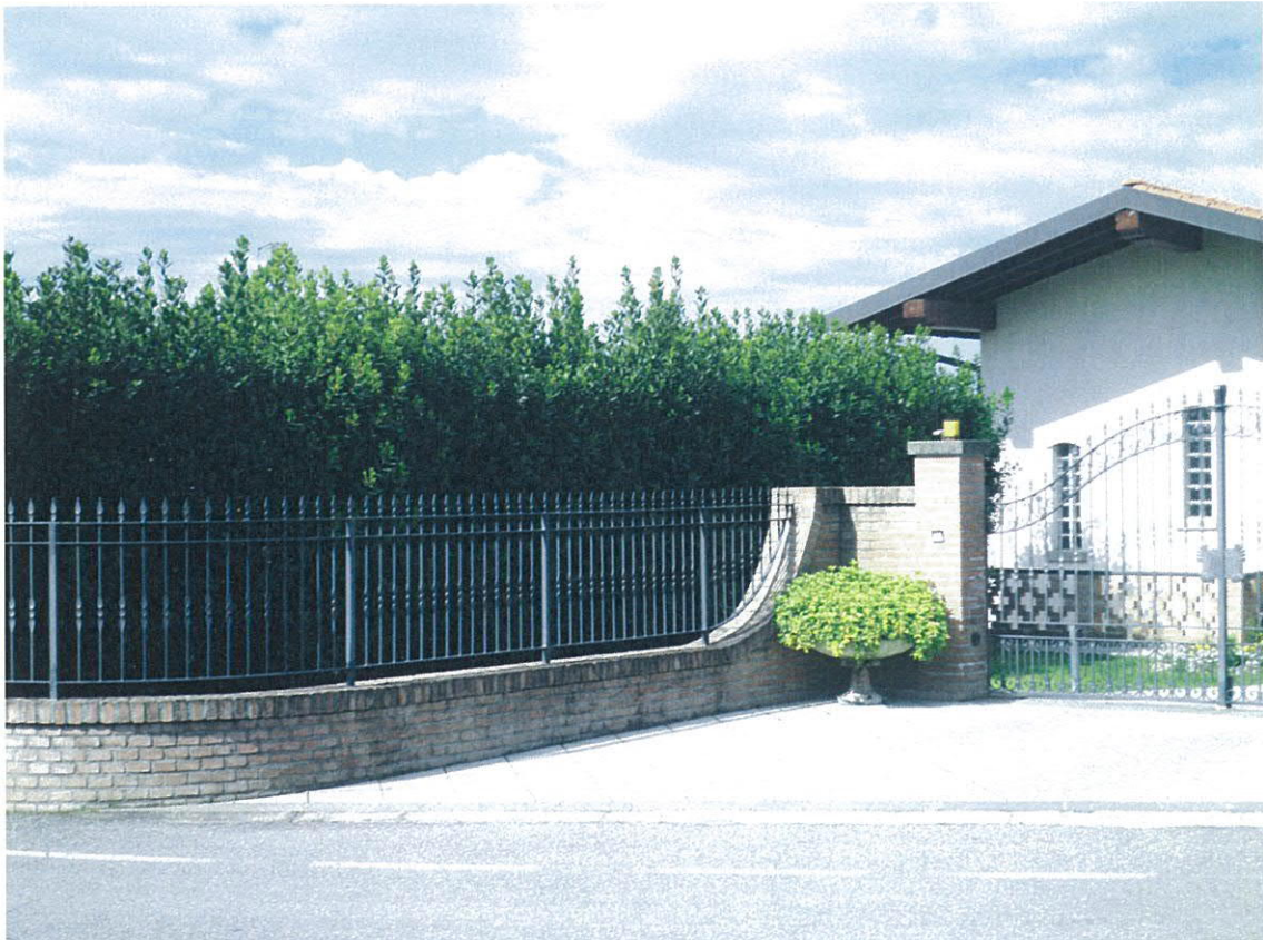
Lato ovest - dettaglio residenza 04 ingresso piano interrato
