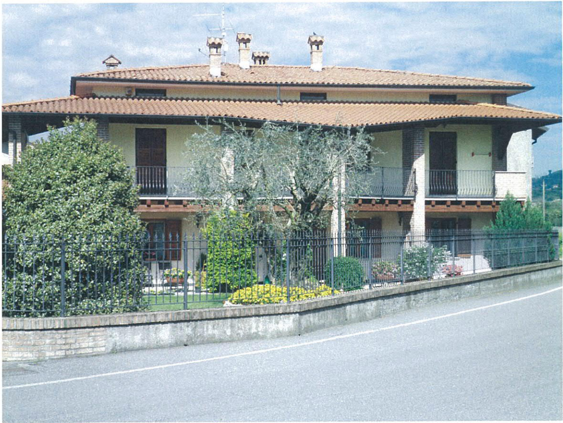
Lato ovest - dettaglio residenza 01
