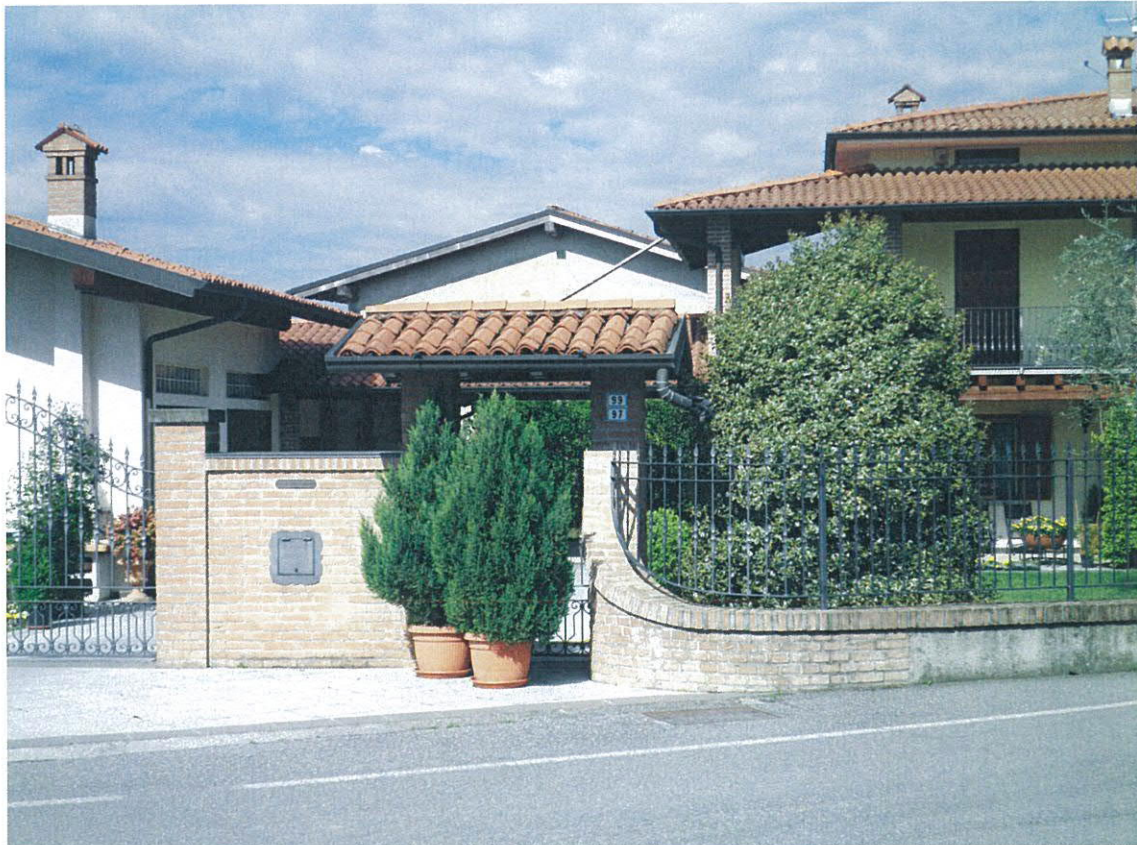
Lato ovest - dettaglio residenza 02
