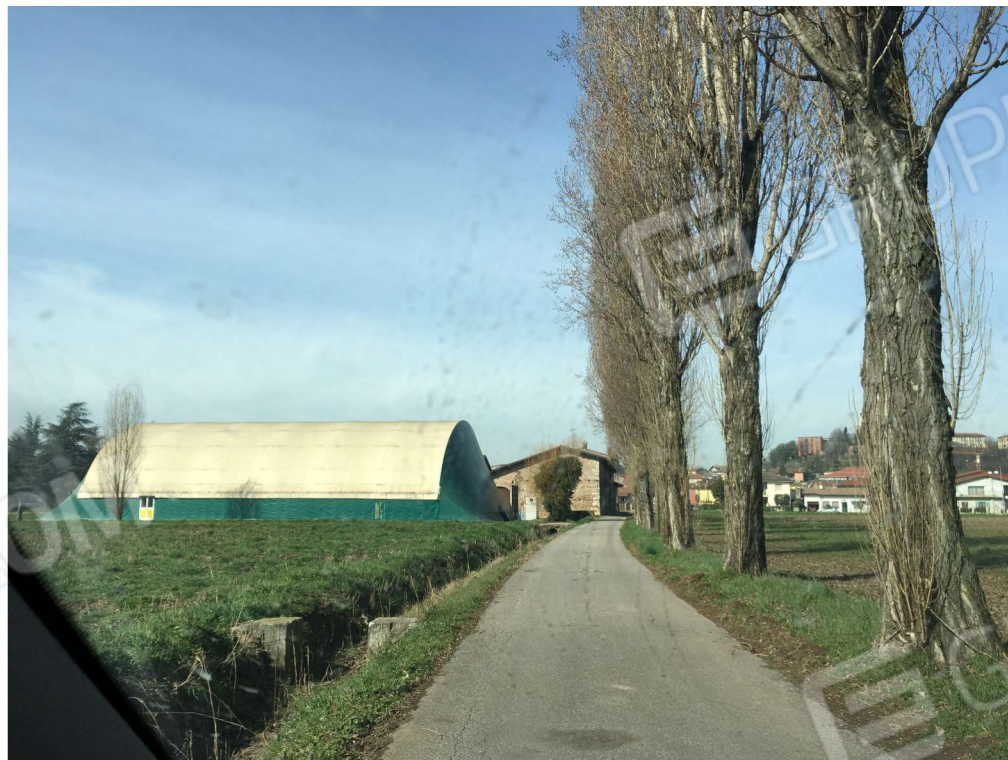
Fotografia 5 – Vista del lato sud dell’immobile da Via Prati
