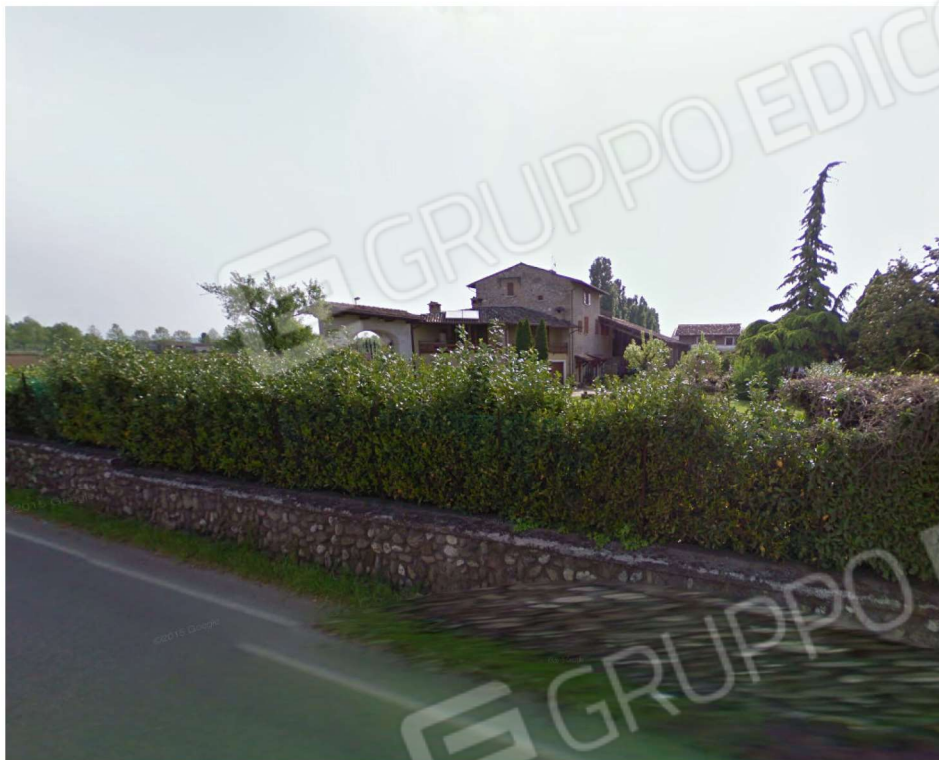
Fotografia 6 – Vista dell'immobile da Via Marsala
