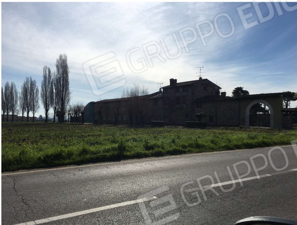
Fotografia 4 – Vista del fronte nord dell’immobile da Via Marsala
