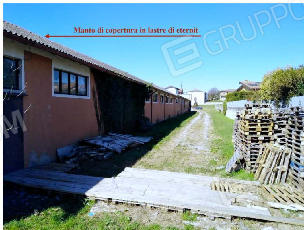
Le aree pertinenziali e il Fronte Est di entrambe le porzioni del BENE 4
