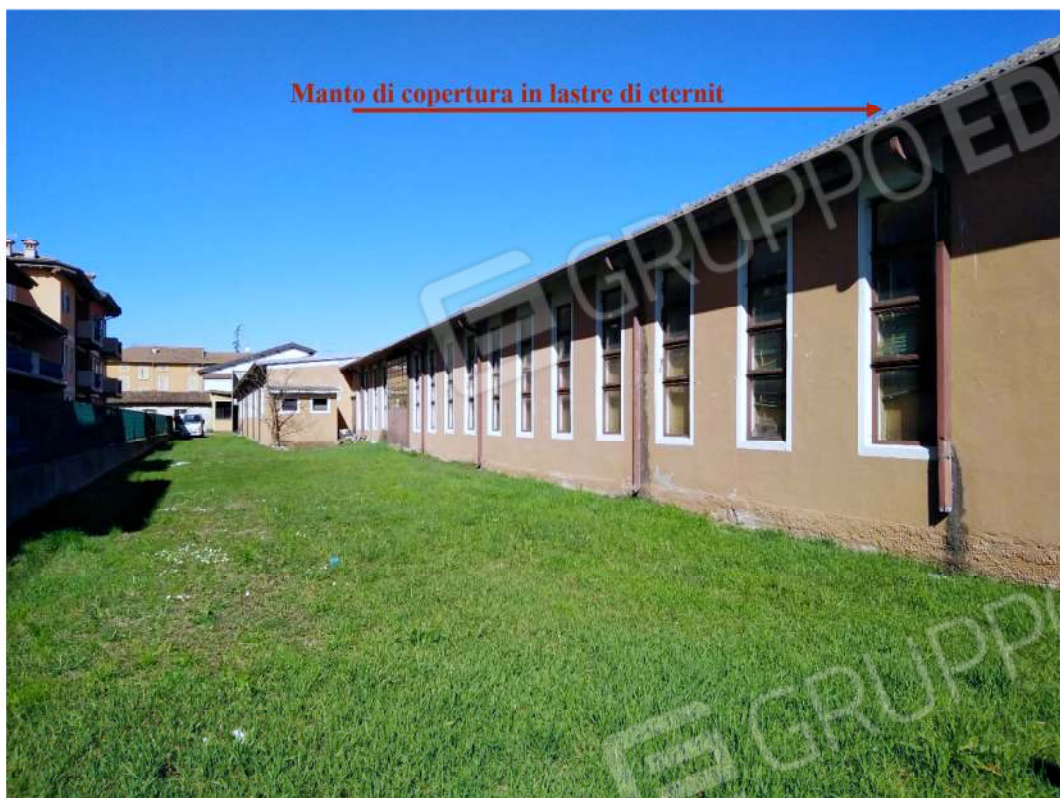
Le aree pertinenziali e il Fronte Ovest della porzione più recente del BENE 4
