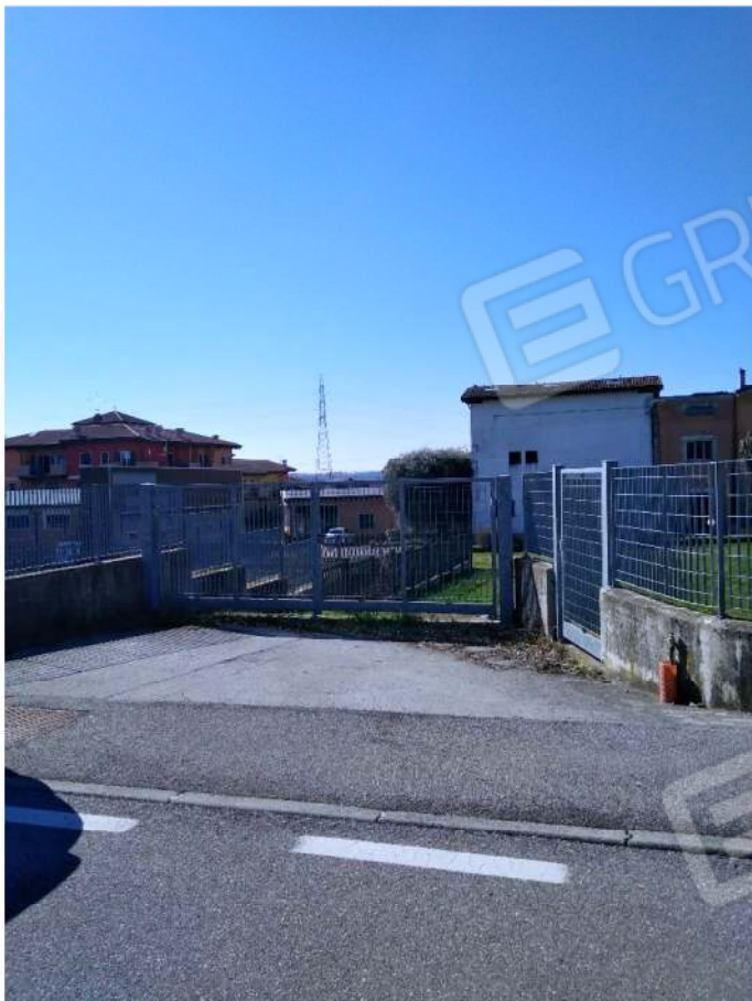
L'accesso al BENE 4 da Via Cavriana snc
