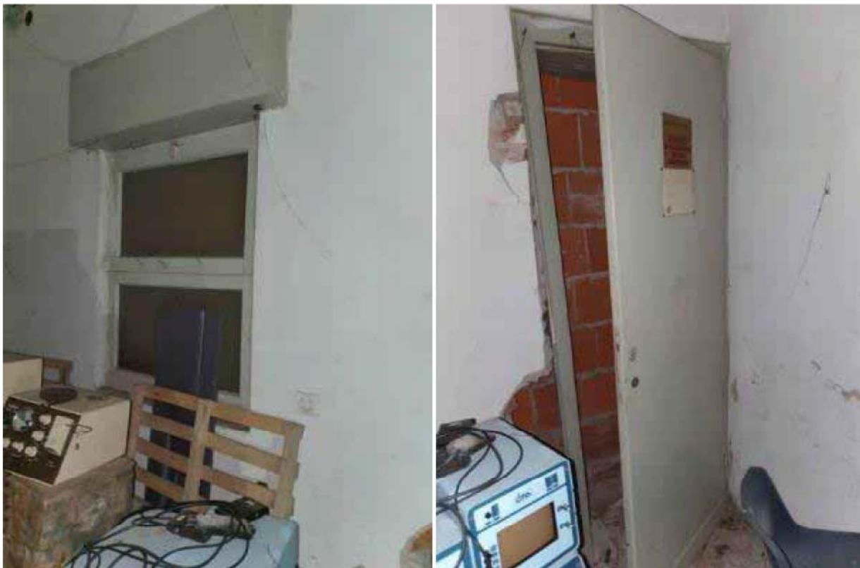
Immagine 20 - Piano Terra, porzione di corpo di fabbrica posta a Sud-Est. Finestra e porta murate lungo la parete di separazione con il corpo di fabbrica posto a Sud-Ovest.
