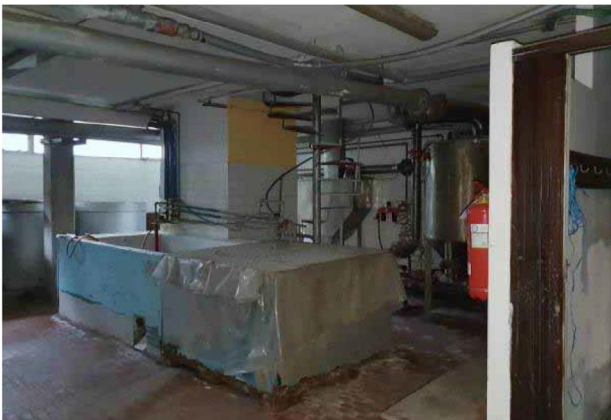
Immagine 8 - Piano Terra, porzione di corpo di fabbrica posta a Nord. Locale preparazione fango con vasche in muratura, montacarichi e scala a chiocciola.
