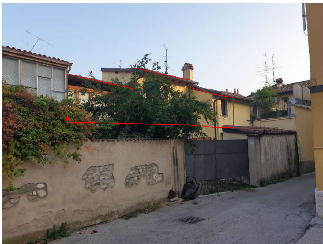
Fotografia 2 – prospetto su cortile interno di altra proprietà
