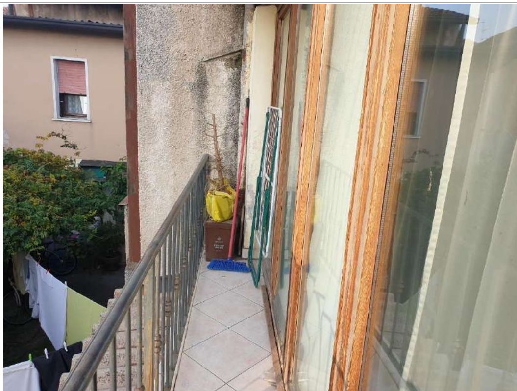
Fotografia 9 serramenti esterni tamponamento loggia
