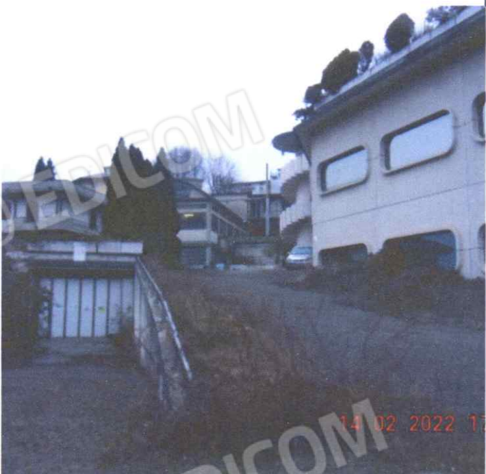
Percorso per accesso alla discoteca non realizzato
