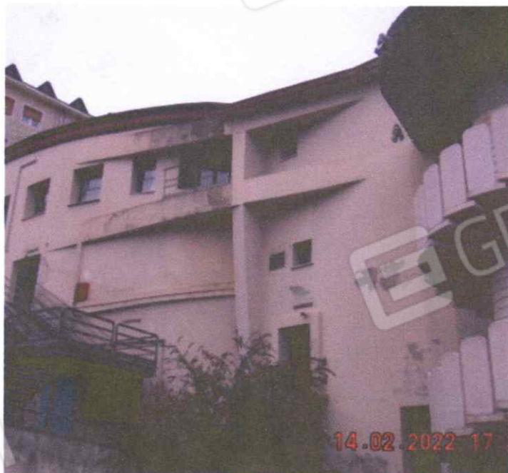
Vista esterno fabbricato da Via Massimo D'Azeglio
