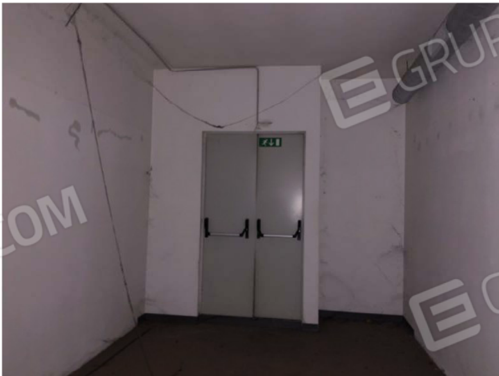
Fotografia E.10 - PARTICOLARI INTERNI PALESTRA
