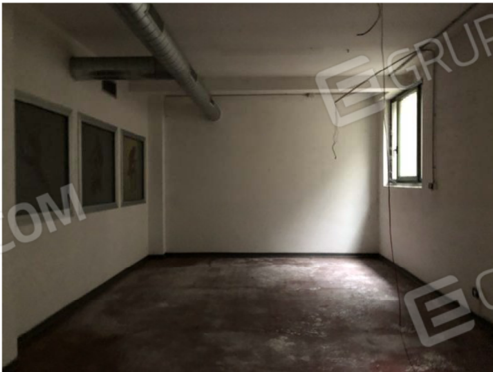
Fotografia E.8 - PARTICOLARI INTERNI PALESTRA
