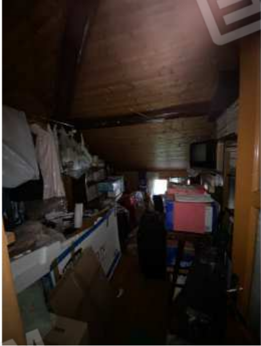
N. 39 Vista 4 del sottotetto - Sub. 1
