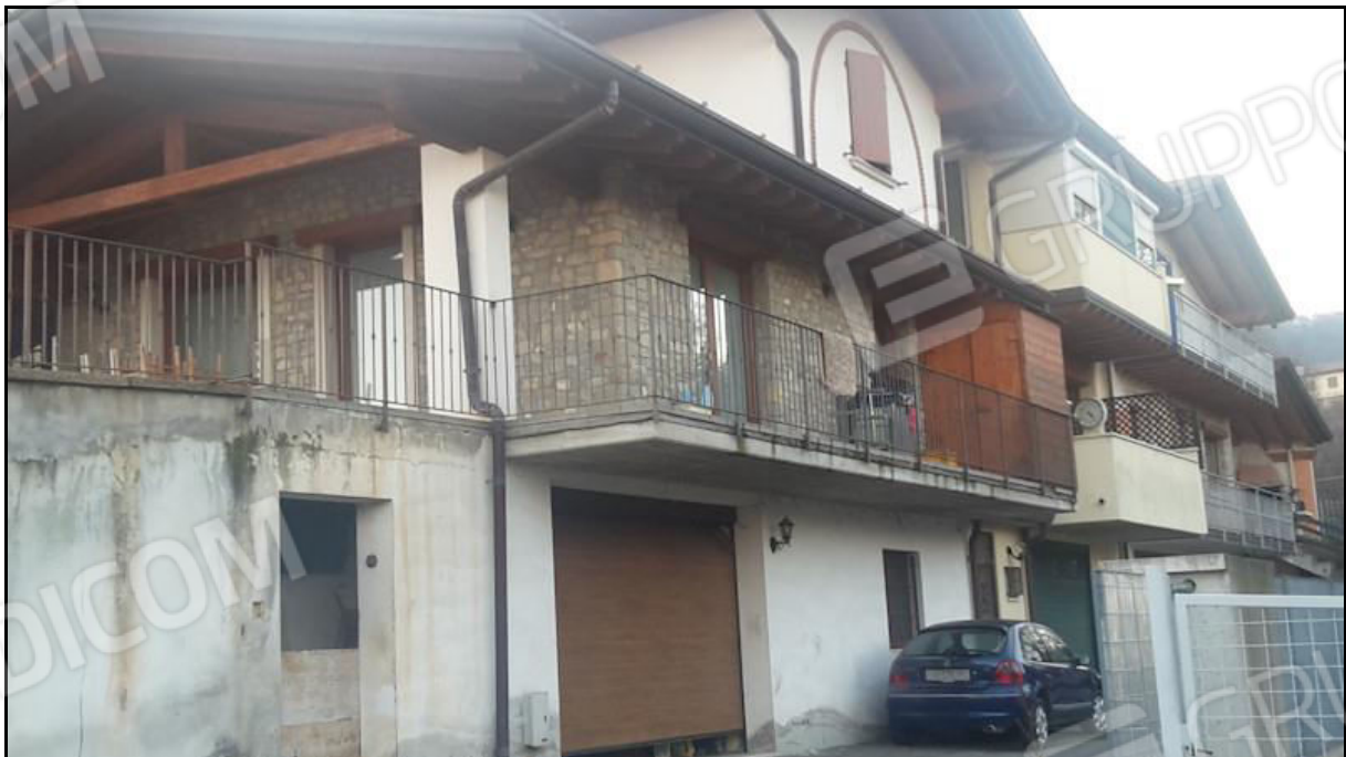
Villetta (lato nord-est)
