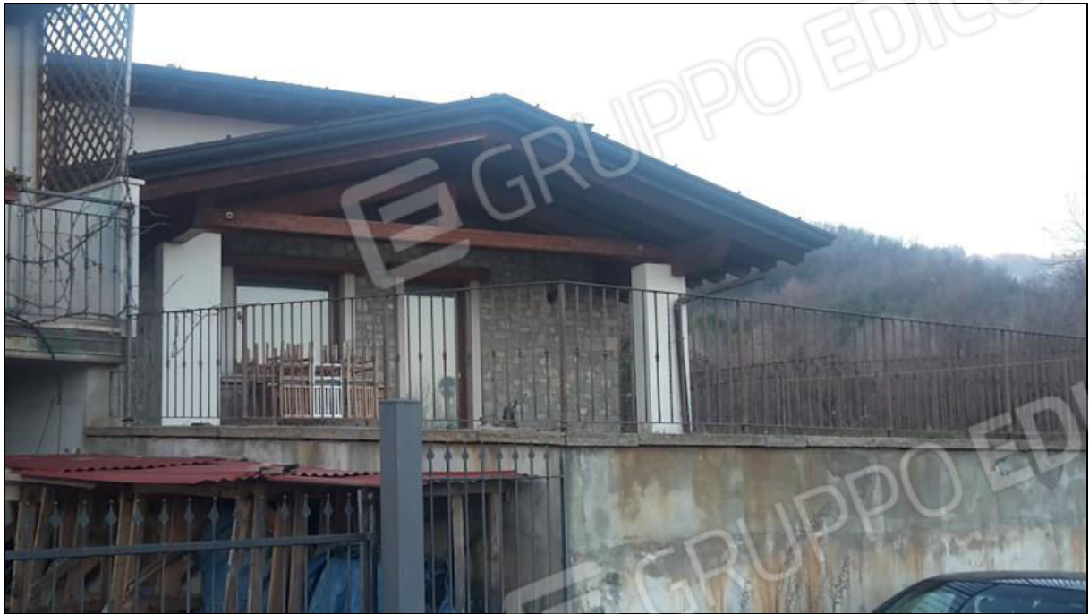
Villetta (lato sud-est)
