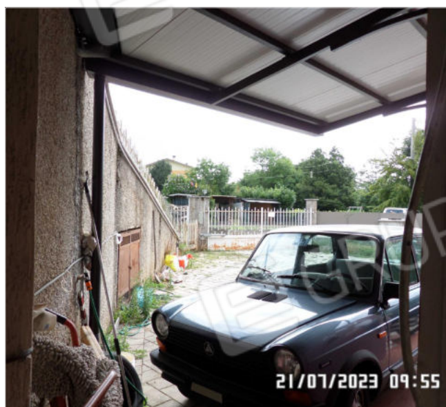
FOTO 16: Vista della tettoia e della corte lato Nord
