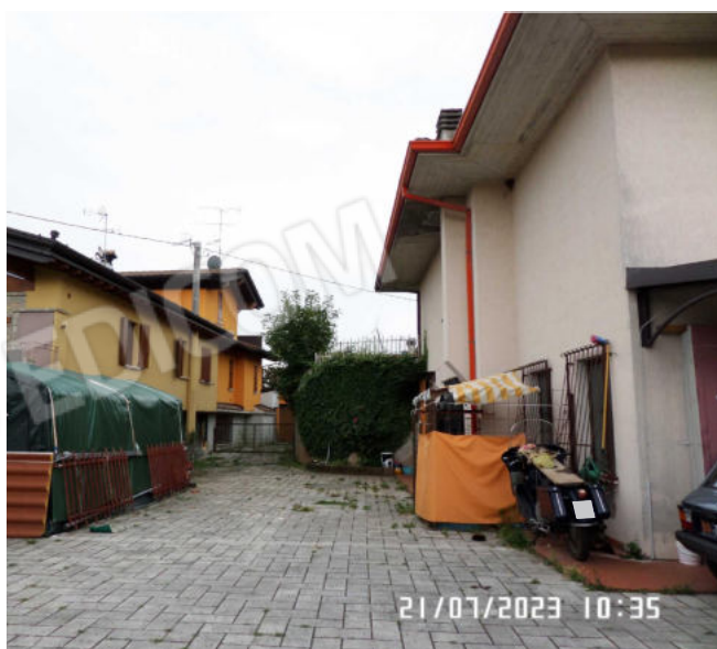
FOTO 15: Corte carrabile esclusiva ad Est della villa
