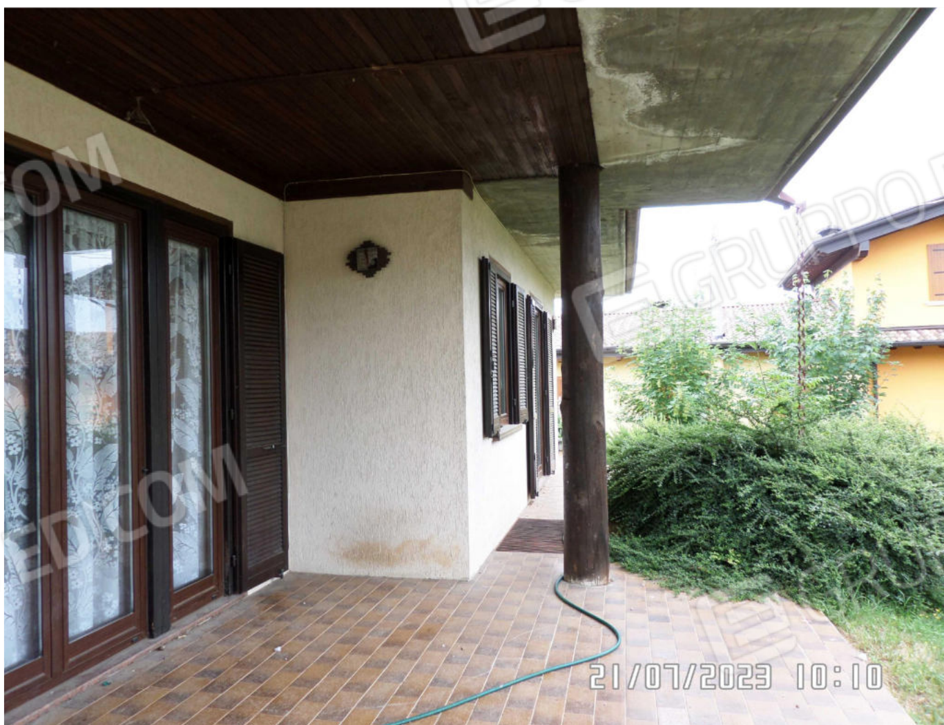
FOTO 10: Portico lato Sud e portafinestra del soggiorno
