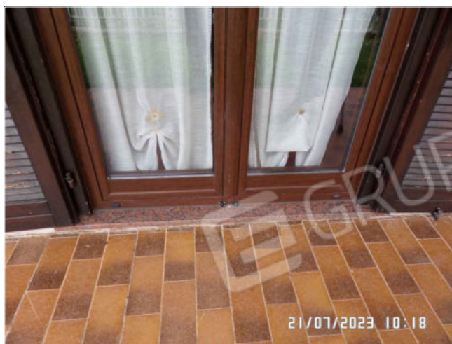
FOTO 45: Particolare ext. portafinestra cucina al p.1°
