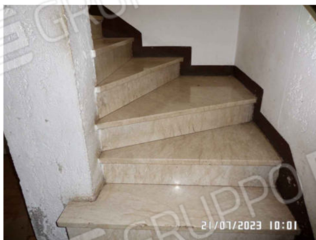
FOTO 31: Particolare dei gradini in marmo Botticino
