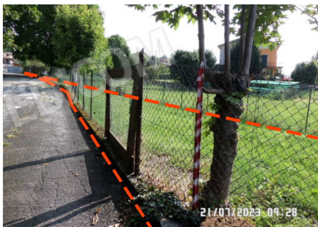
FOTO 6: Particolare della recinzione
