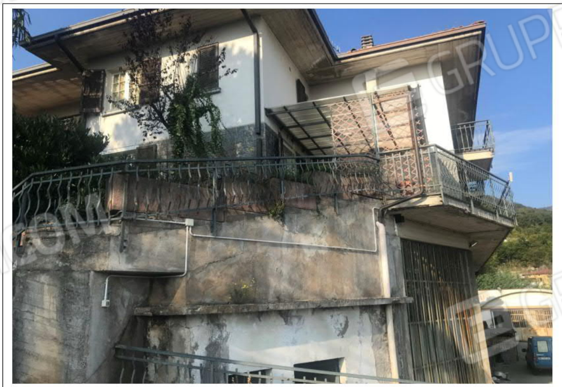
1) Fotografia che inquadra la facciata laterale del LOTTO 3, con la tettoia abusiva.
