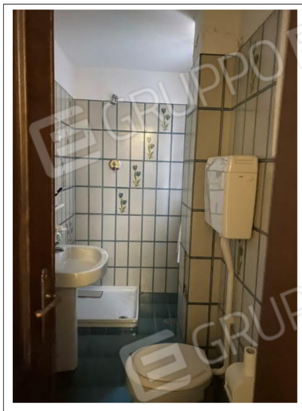
6) Fotografia del bagno situato al piano terra del LOTTO 2
