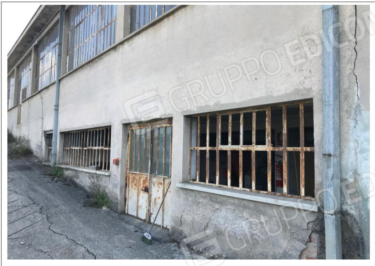
6) Fotografia che riprende dall'esterno i locali per piano interrato del fabbricato A.
