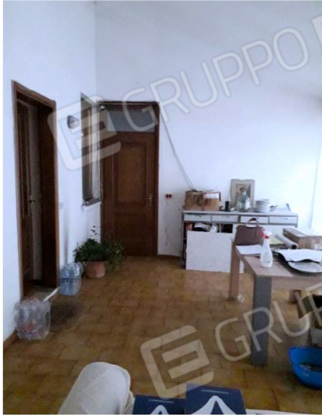
Loggia e accessi alle unità immobiliari residenziali
