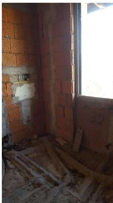
Vista bagno piano primo
