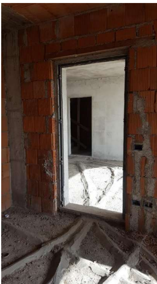
Vista ingresso ( sub 13) dal tunnel comune con il sub 14
