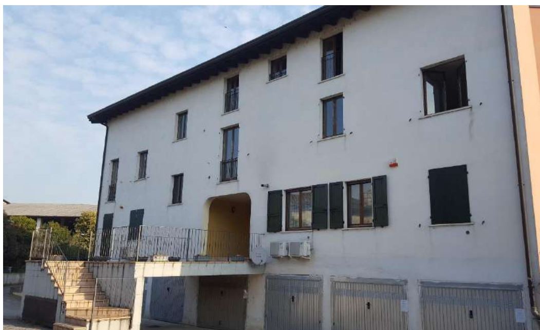
Facciata sul retro. Vista sub 15 – 17 al piano 1° e sub 23 – 24 al piano 2°
