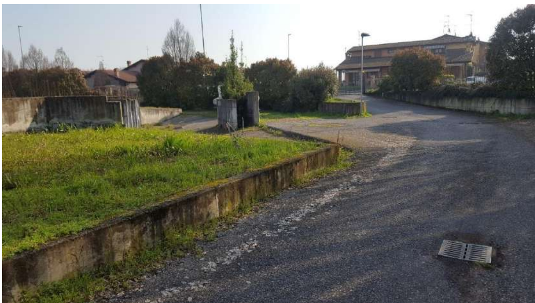
Ingresso carraio e strada ( sub 71) compresi tra sub 59 e sub 60
