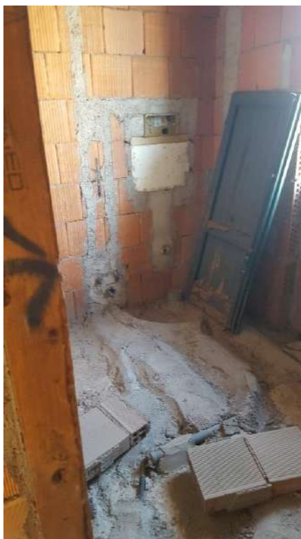
Bagno al piano primo
