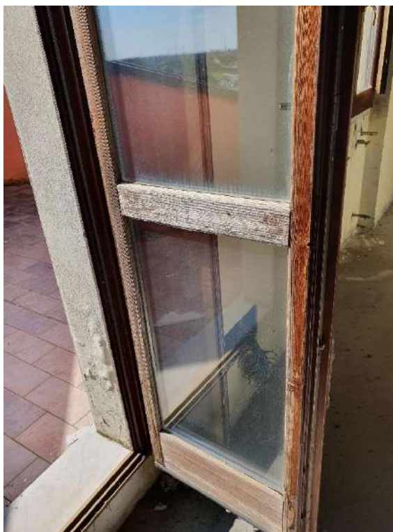
Infissi deteriorati
