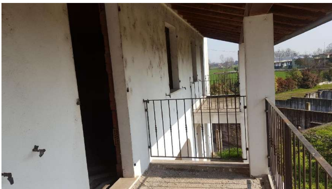
Terrazza coperta: vista nord est
