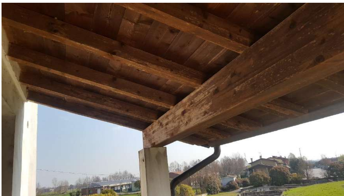
Struttura copertura terrazza coperta
