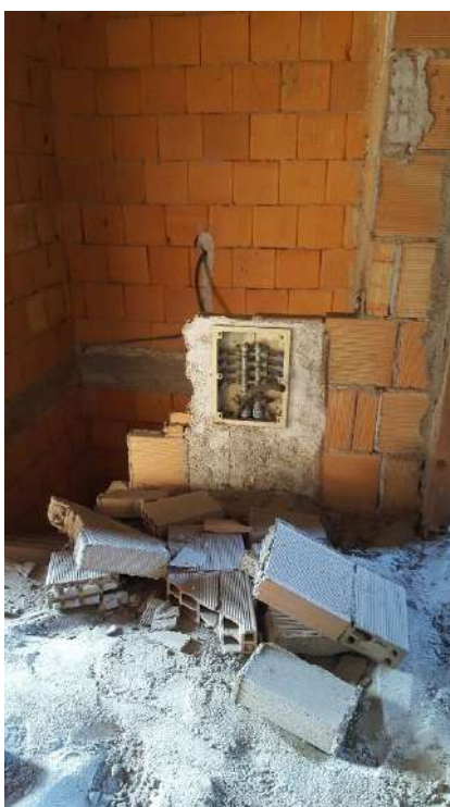
Pianerottolo scala al piano primo
