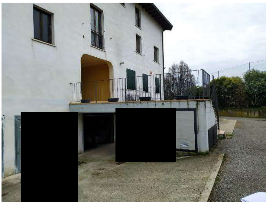
Vista autorimesse piano interrato e sub. 68/71
