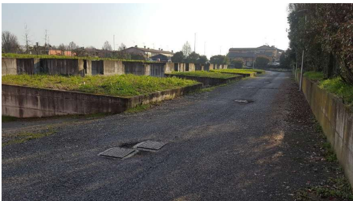
Vista scivoli, aree di pertinenza sub 60 e strada (sub 71) con muro di recinzione e collettore acque
