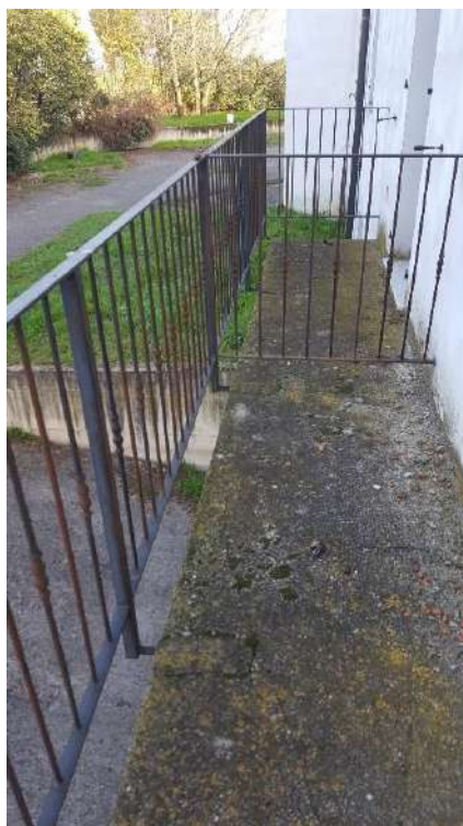
Vista balcone cucina
