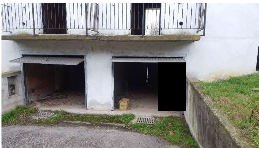
Vista autorimesse a piano interrato
