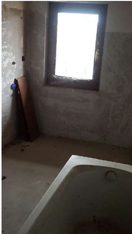
Bagno con vasca ed attacchi per sanitari
