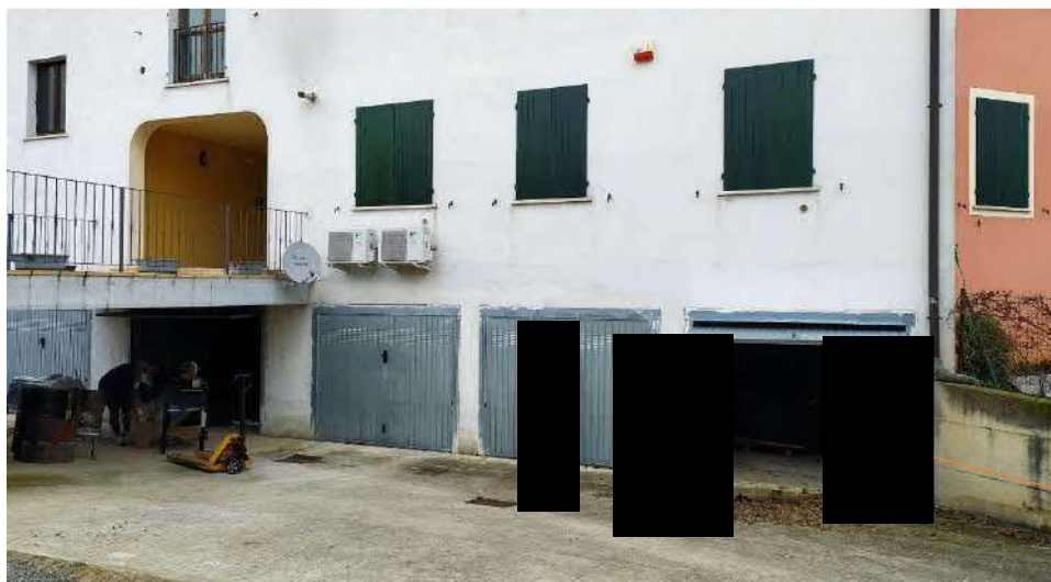
Vista autorimesse piano interrato e sub. 68/71
