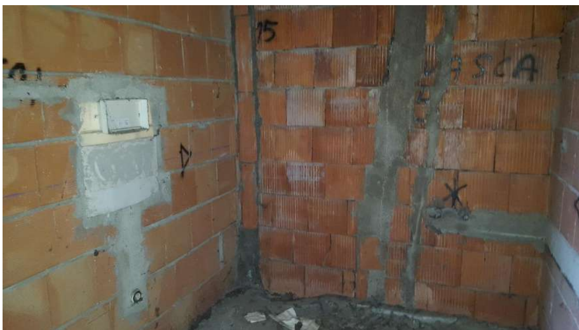
Scarichi ed attacchi bagno cieco
