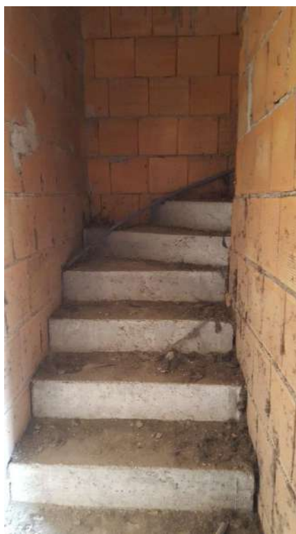
Scale di collegamento piano terra-primo
