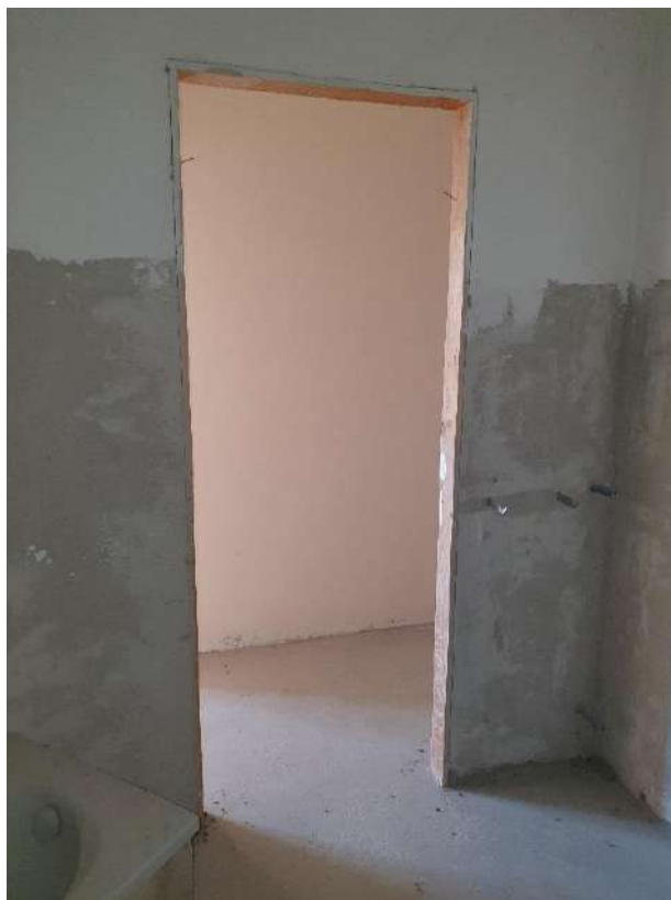
Bagno senza finestre- Apertura per porta d'accesso.
