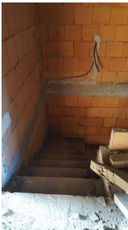
Vista vano scala che collega il piano interrato, il piano terra ed il piano primo.
