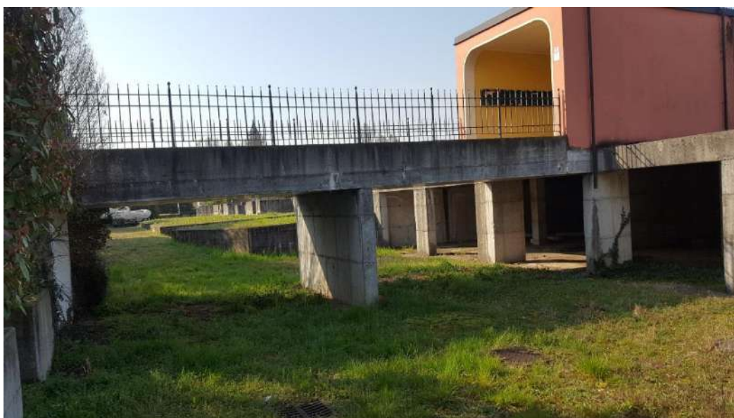
Strutture al piano interrato con solaio di copertura – Tipologia B – in corrispondenza del soprastante viale d'accesso.
