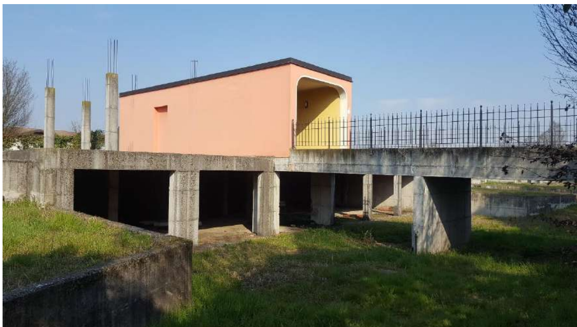
Vista strutture corpo ingresso sub 71 al piano T e strutture corpo C tra sub 59 e sub 58
