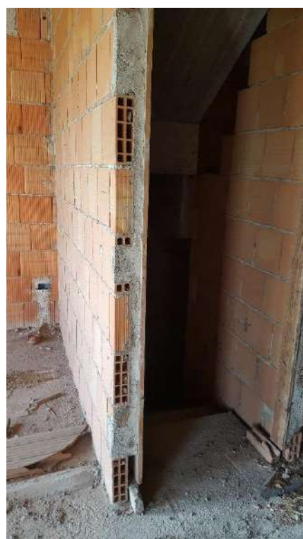
Vista scale di collegamento piano terra-interrato
