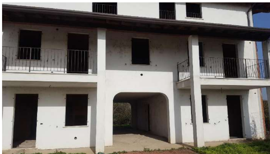
Vista esterna tunnel comune
