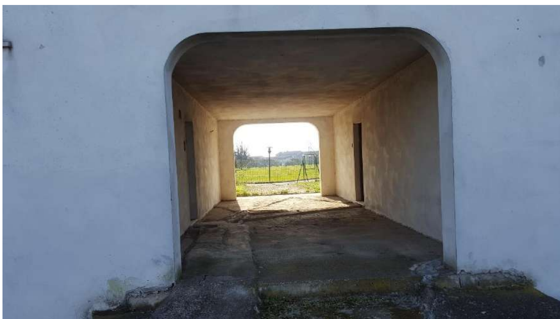
Vista del tunnel comune dal retro del fabbricato. Accessi al sub 13 e 14
