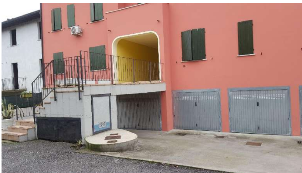
Vista autorimesse piano interrato sub. 69/71
