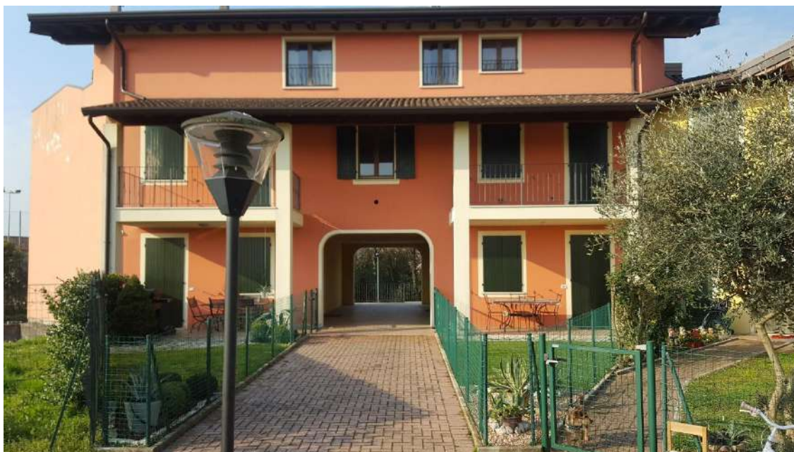
Facciata sud ovest. Vista sub 16 – 17 al piano 1° e sub 23 – 24 al piano 2°
