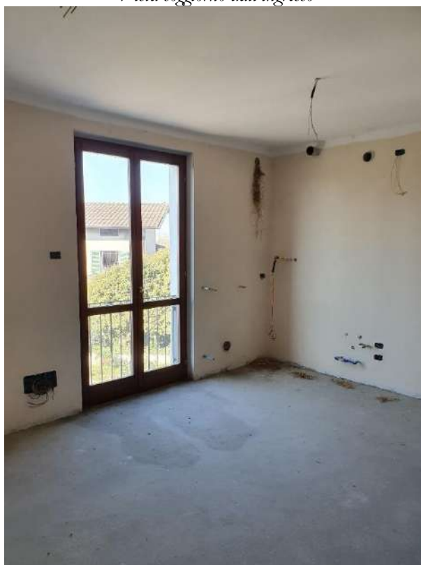
Vista zona cucina del locale soggiorno
