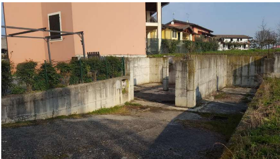
Vista strutture del primo e secondo modulo sub 60
