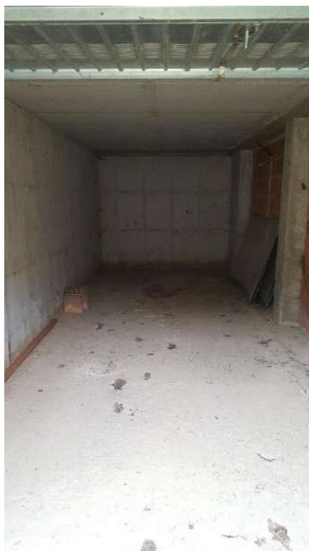
Vista autorimessa piano interrato
