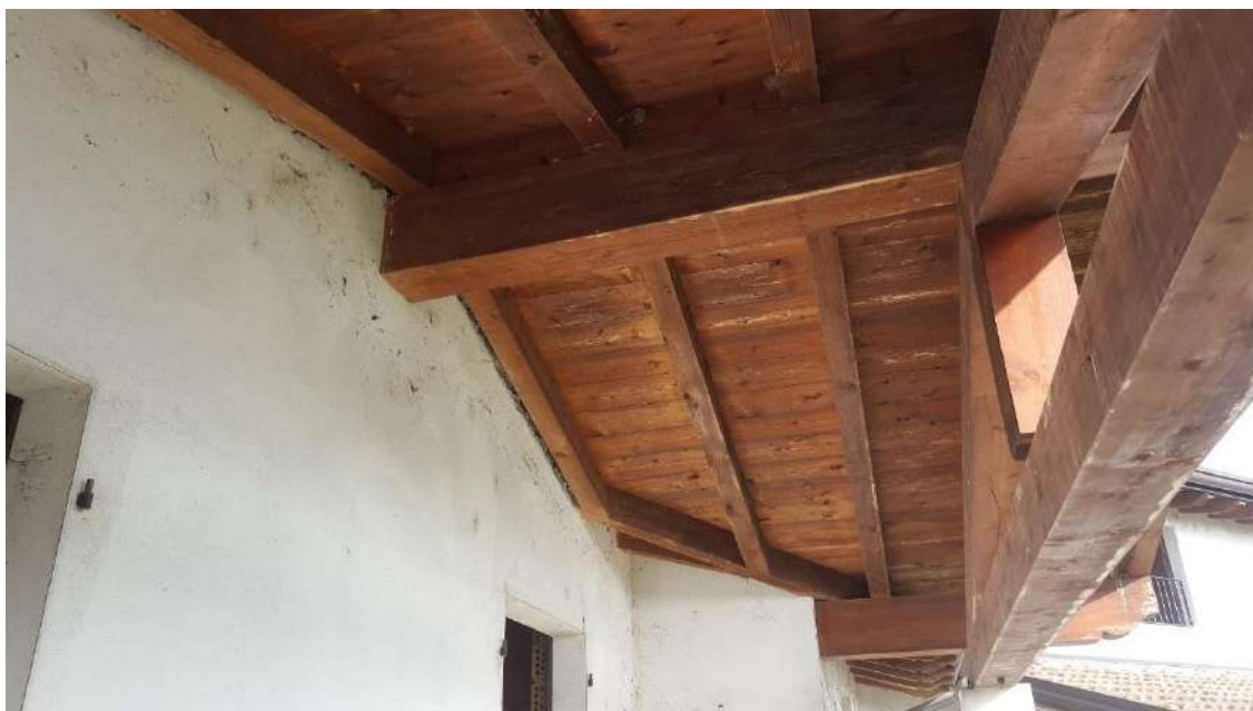
Vista copertura balcone piano primo
