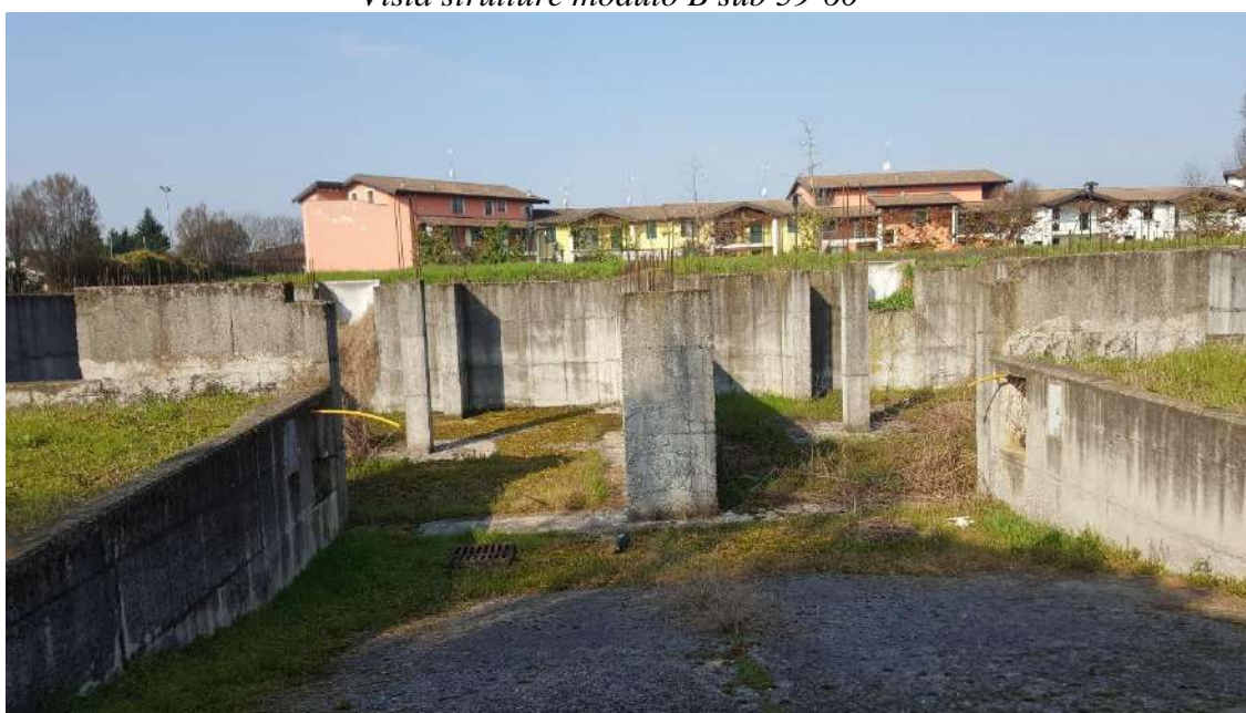
Vista strutture modulo A sub 59
