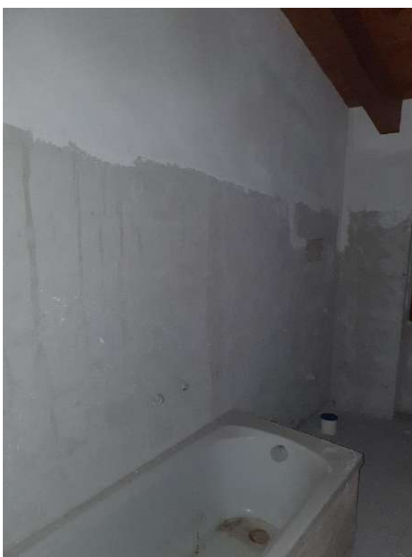
Bagno con vasca ed attacchi predisposti per sanitari.
