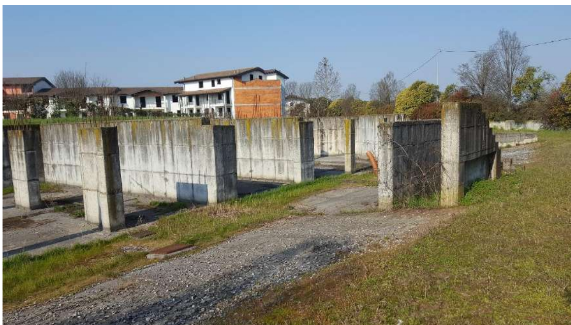
Strutture del fabbricato tipo C tra il sub 58 ed il sub 57
