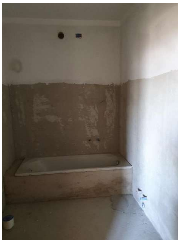
Bagno privo di finestra - Vasca bagno ed attacchi per sanitari
