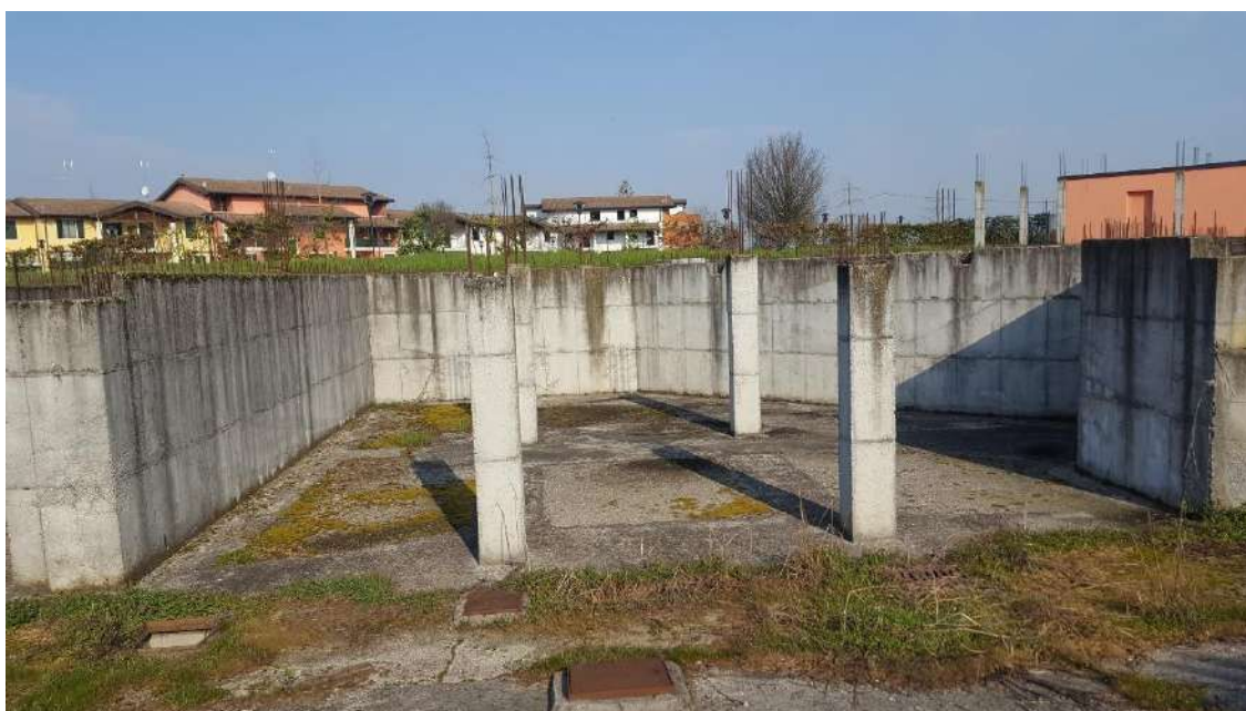
Vista strutture modulo B sub 59-60
