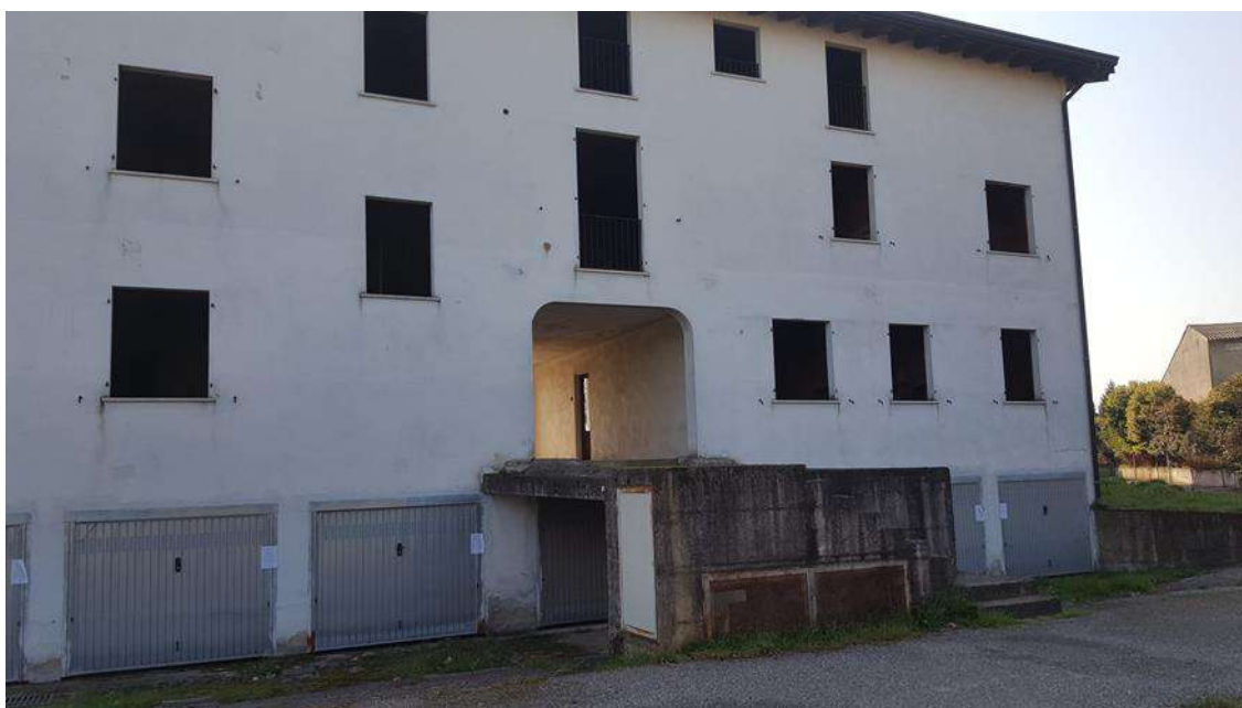
Vista esterna autorimesse sub. da 50 a 56
