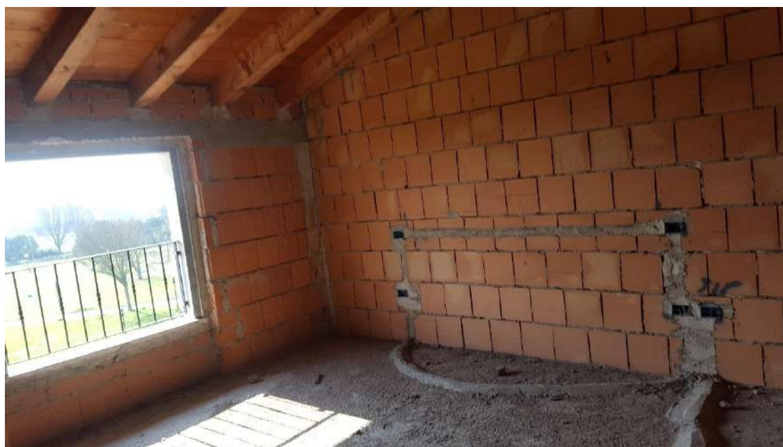
Camera da letto – tracce impianto elettrico
