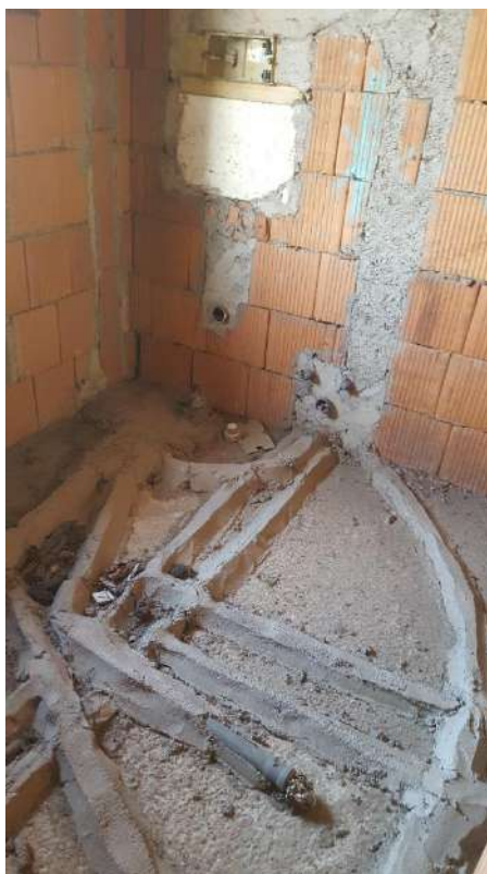
Vista bagno piano primo
