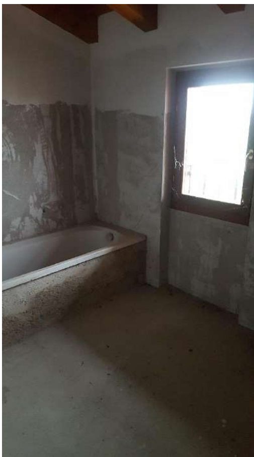
Bagno con vasca ed attacchi per sanitari
