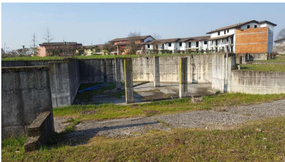
Strutture tipologia A del sub 57
