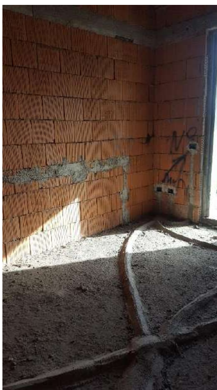
Vista camera e tracciato tubazioni
