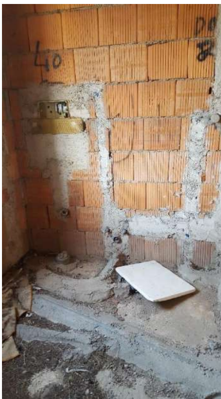
Bagno al piano terra: muara la cassetta per wc ed attacchi per sanitari
