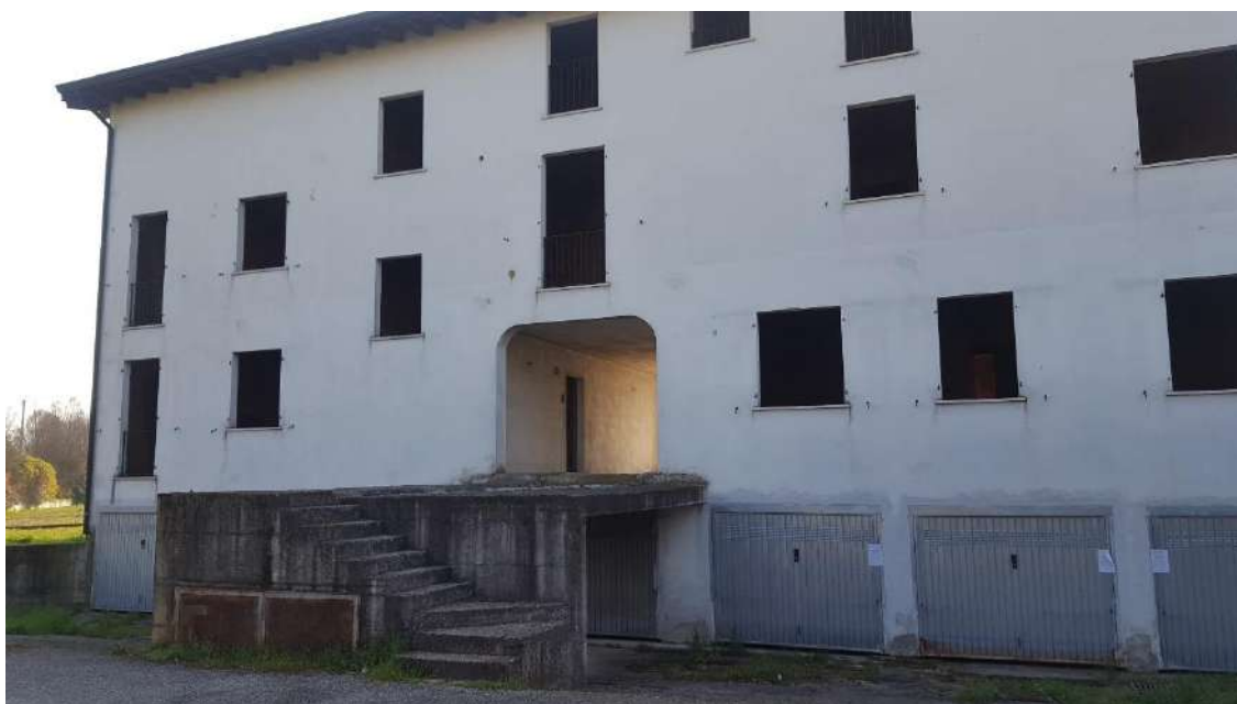
Vista facciata sul retro. Piano interrato: autorimesse sub 50-51-52-53-54-55-56 Piano terra: sub 13 e sub 14; Piano primo: sub 20- 21- 22; Piano secondo: sub 27- 28
