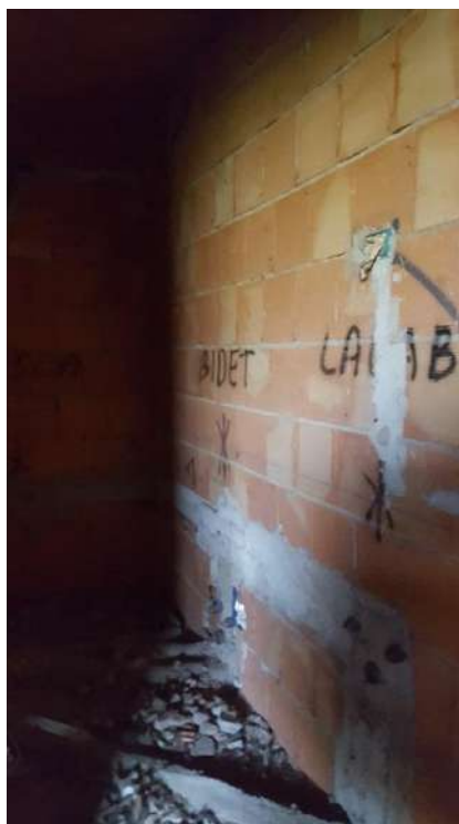
Attacchi e scarichi bagno cieco
