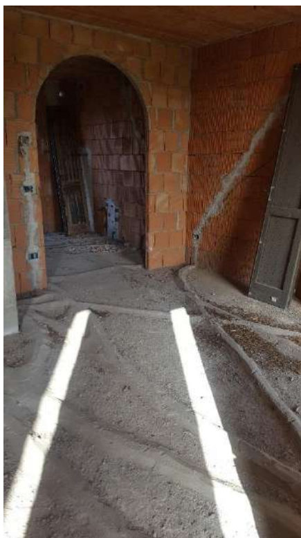
Vista soggiorno e zona cucina
