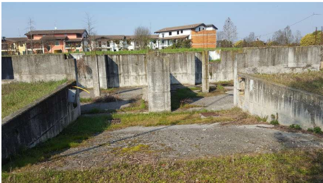
Strutture di tipologia A del sub 58
