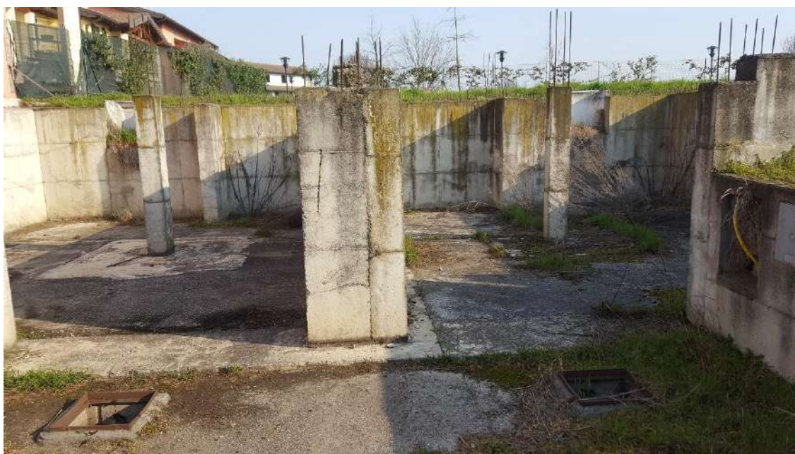
Vista del 3° e 4° modulo sub 60
