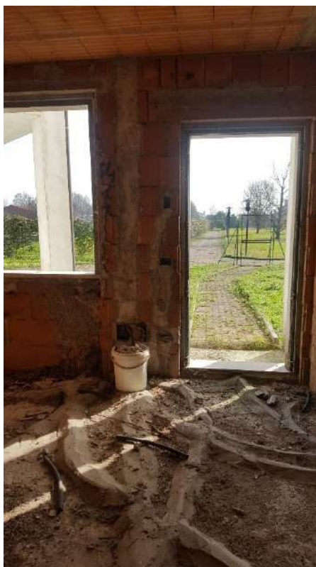
Vista ingresso dall'area di pertinenza
