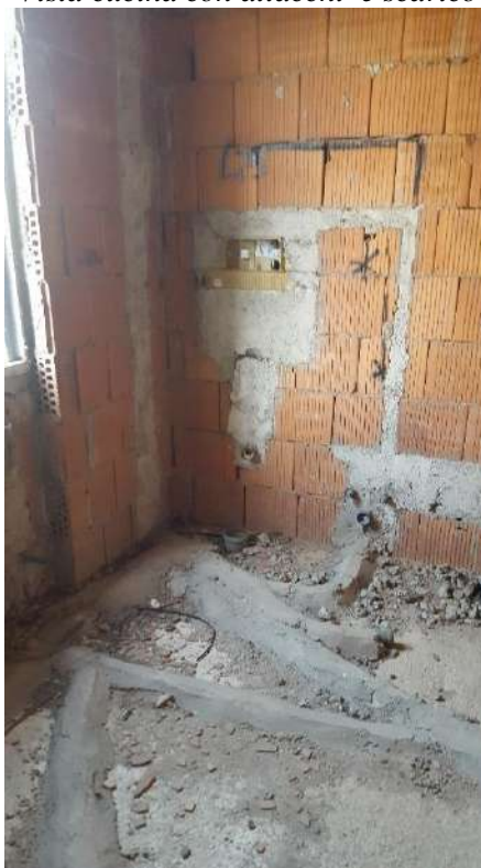
Vista bagno piano terra: cassetta wc ed attacchi sanitari
