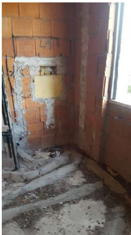
Vista bagno piano terra
