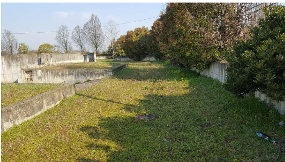
Sub 58: aree di pertinenza, strutture piano interrato e viale antistante ( sub 71 bene comune)
