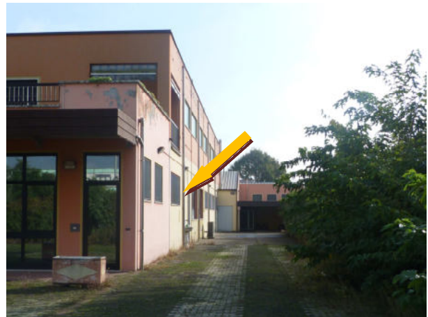
Fig.6 - Fronte SUD ingresso scale per abitazione al P.1°
