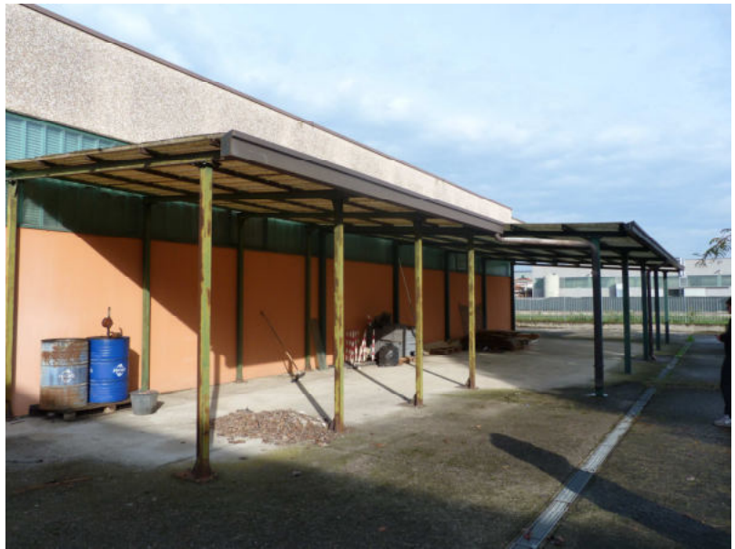
Fronte EST con porticato
