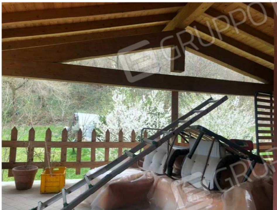
Foto n. 31 Loggia al primo piano
