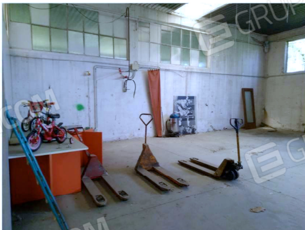
foto 12 – Vista laboratorio II 4/7
