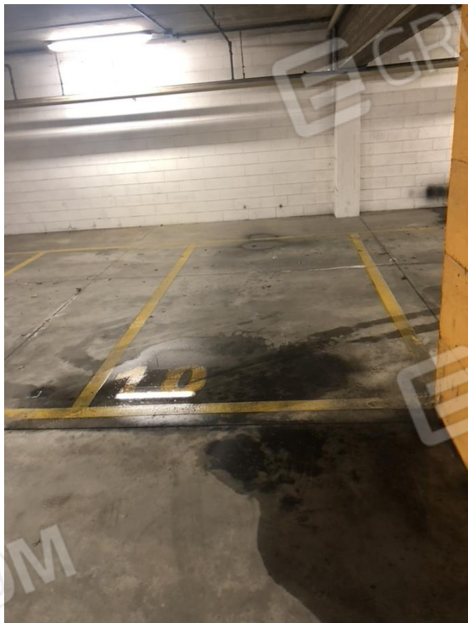
Figura 9_posto auto interrato
