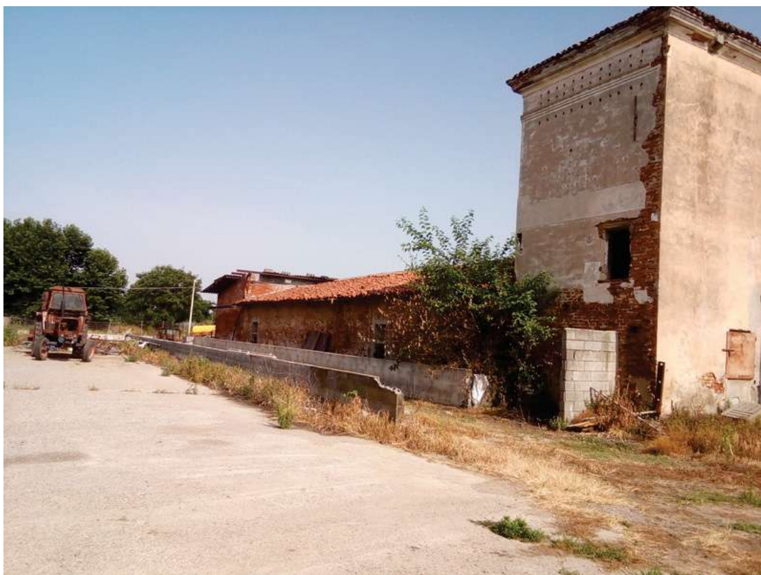
Foto 16 vista del fronte sud
