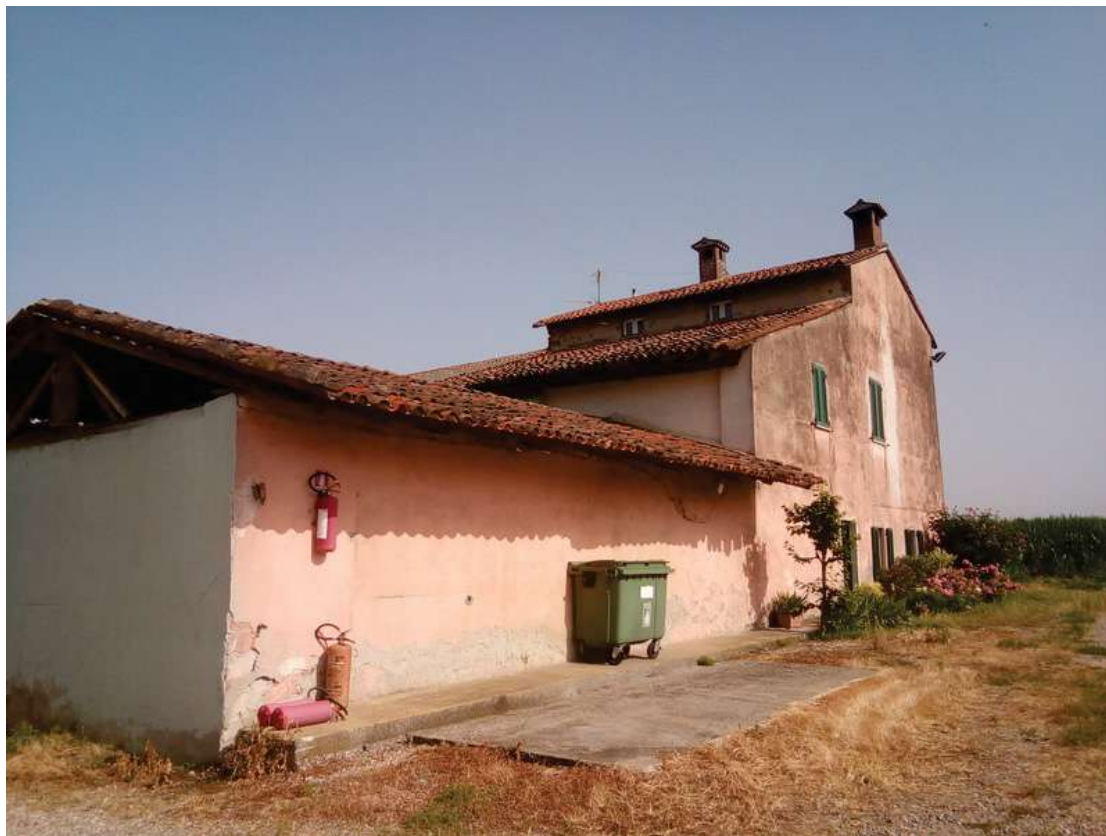
Foto 15 vista del fronte est
