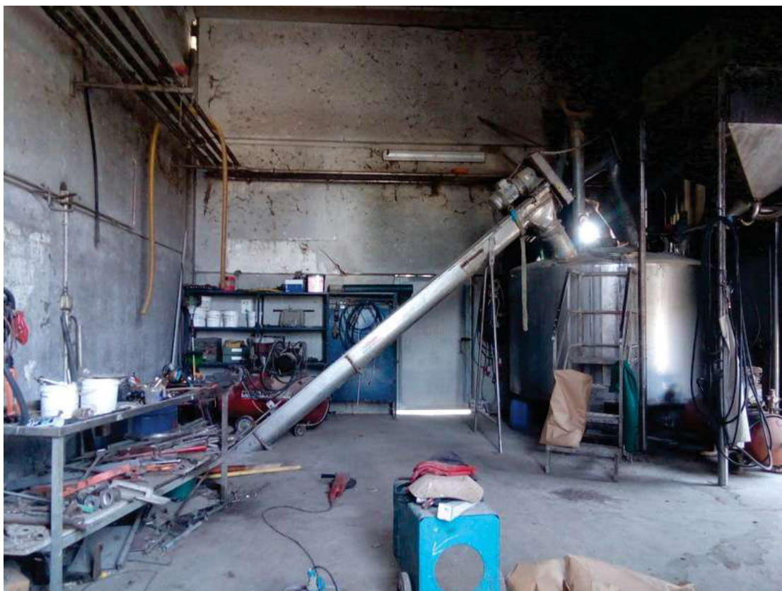
Foto 47 vista interna del corpo C
