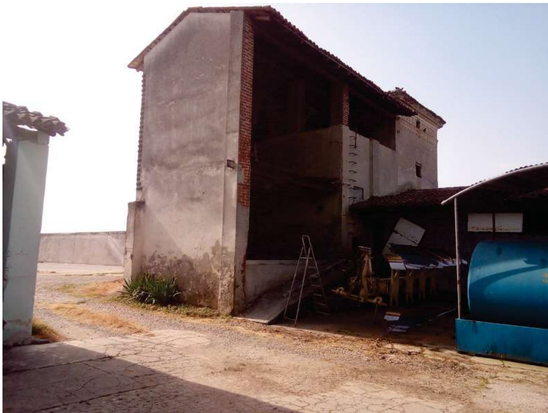
Foto 21 vista dal cortile interno
