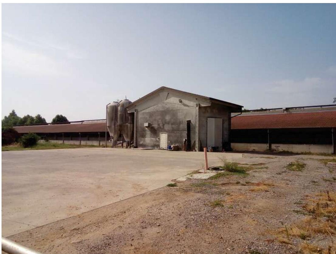
Foto 46 vista del corpo C in primo piano il corpo B in secondo
