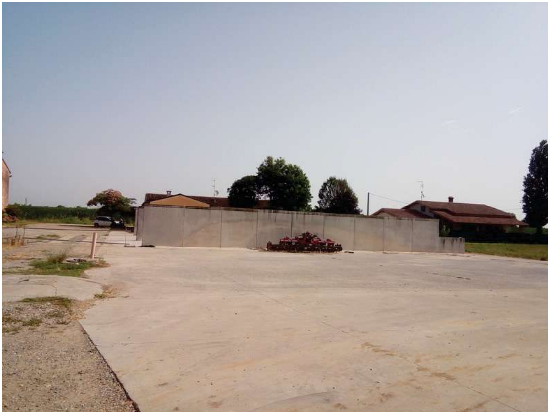
Foto 51 vista del silo orizzontale e del piazzale pavimentato
