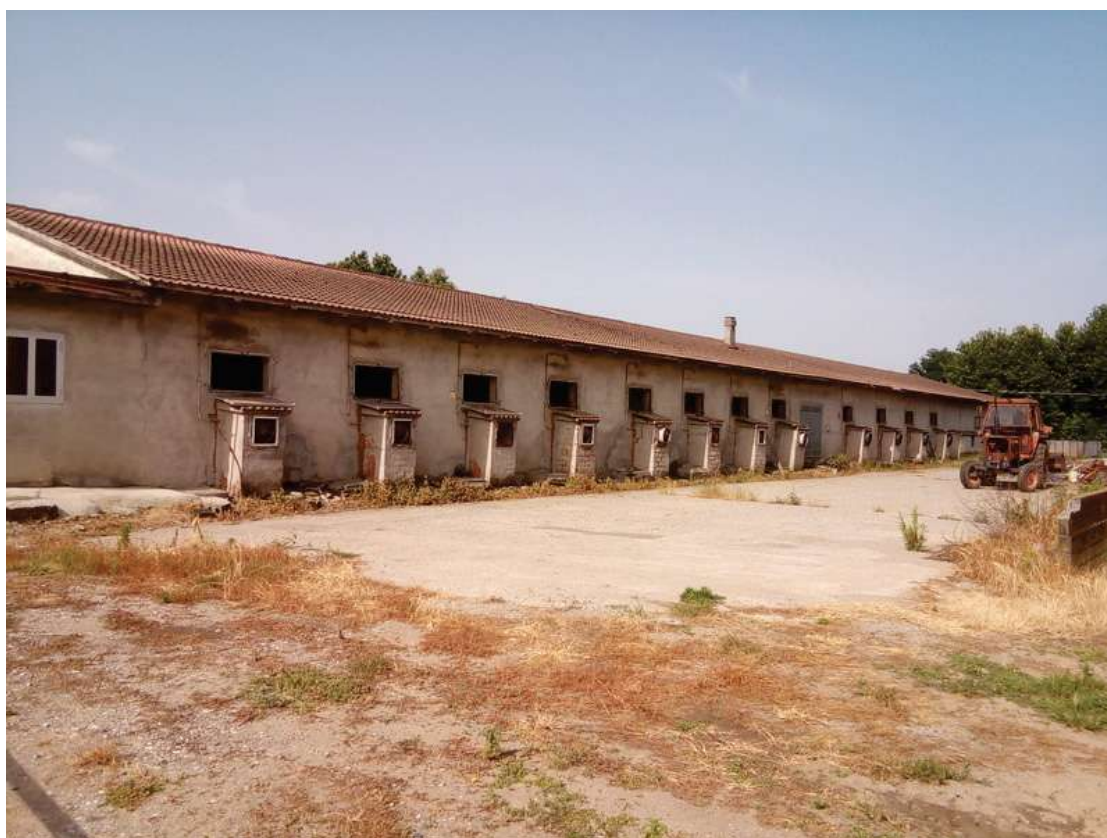
Foto 39 vista del corpo A
