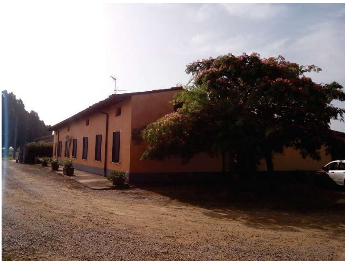
Foto 4 vista del complesso
