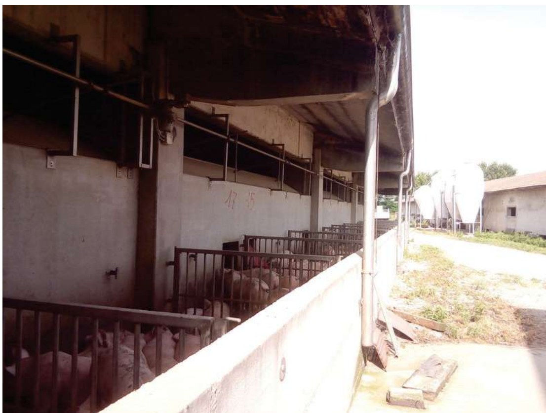
Foto 48 vista del corpo B
