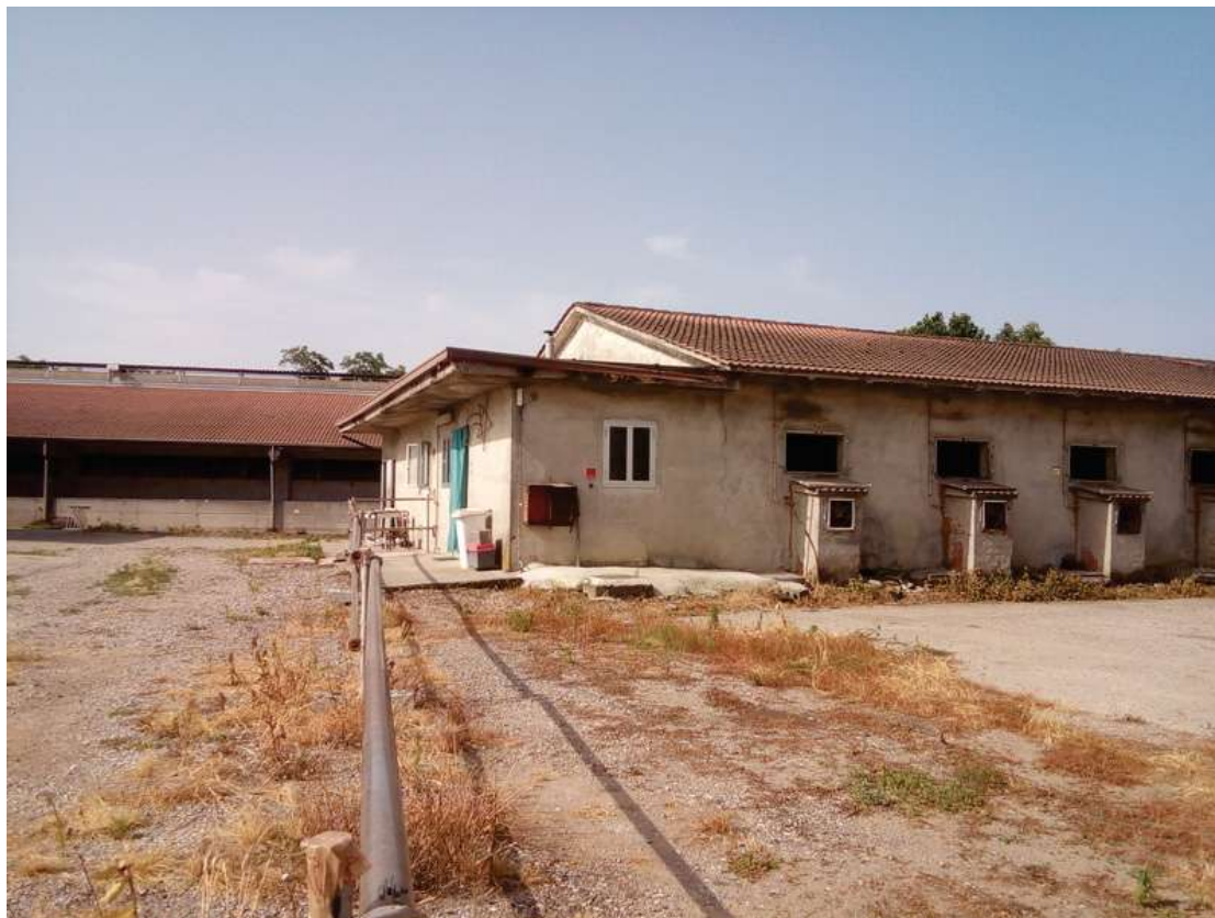
Foto 38 vista del corpo A
