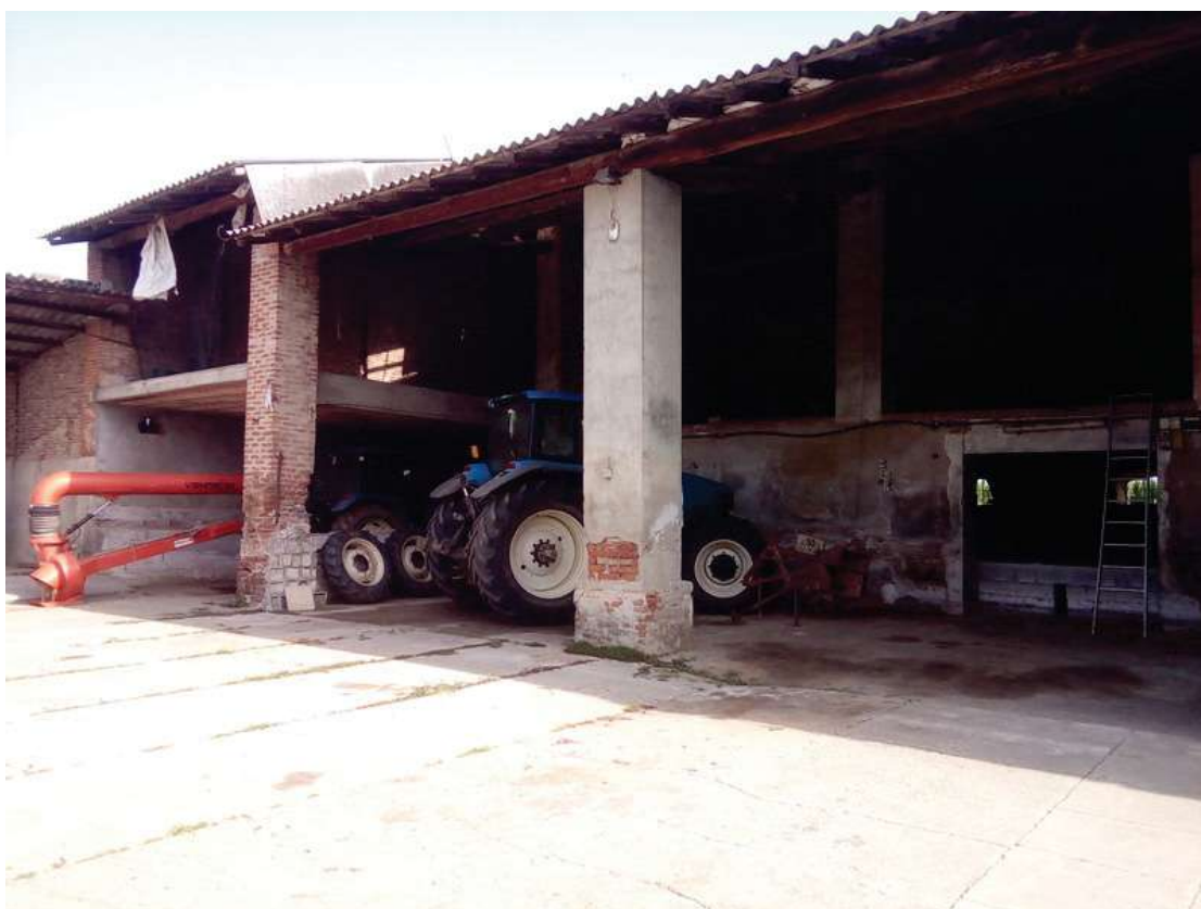
Foto 18 vista dal cortile interno
