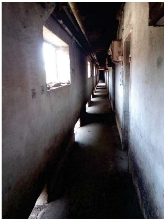
Foto 41 corpo A il corridoio di distribuzione
