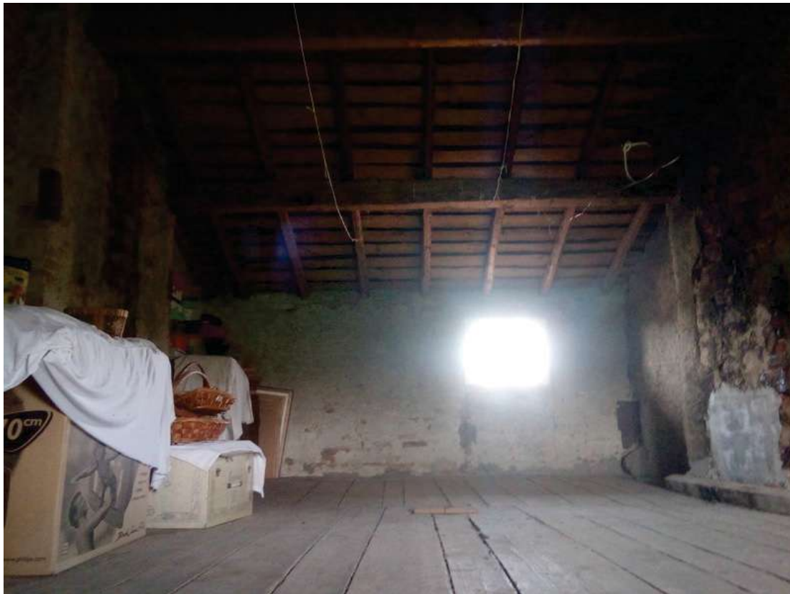
Foto 33 vista del sottotetto
