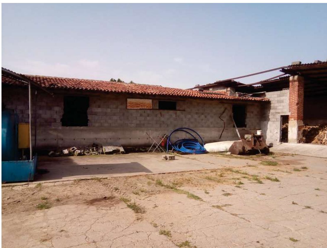
Foto 20 vista dal cortile interno
