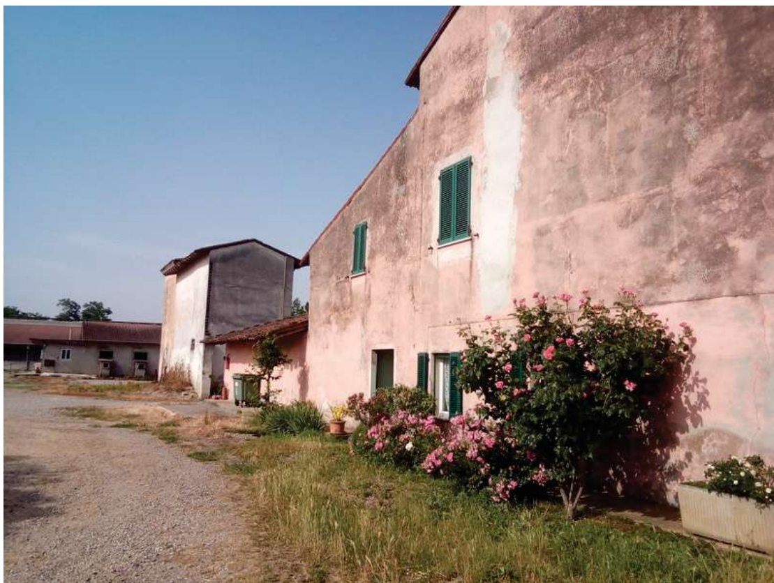
Foto 6 vista del complesso
