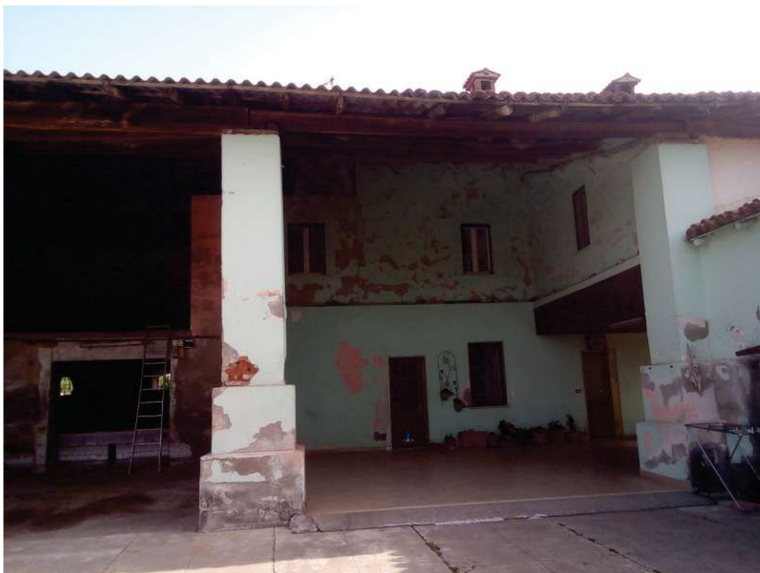
Foto 17 vista dal cortile interno
