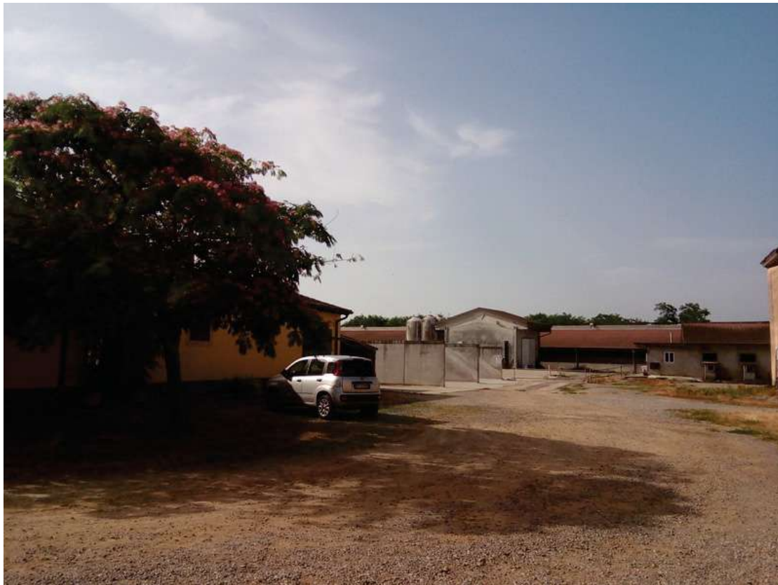
Foto 5 vista del complesso
