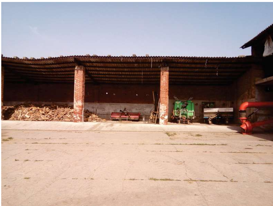
Foto 19 vista dal cortile interno
