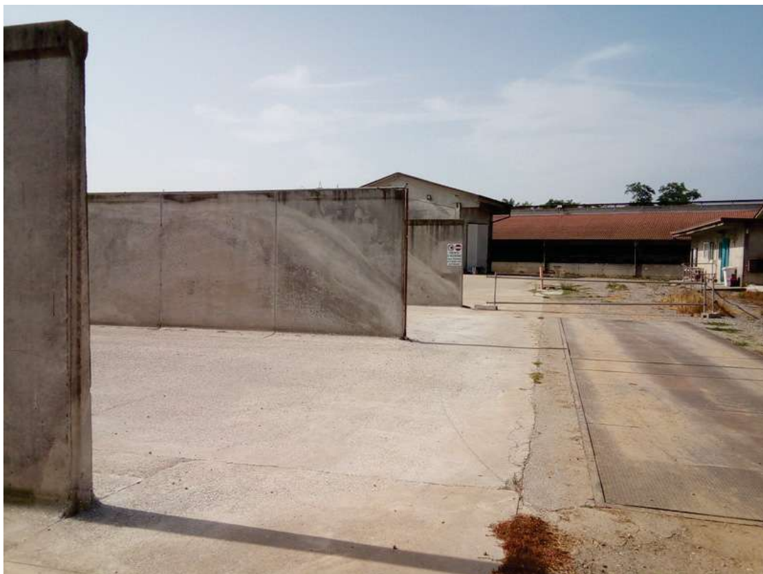
Foto 52 vista del silo orizzontale e della pesa
