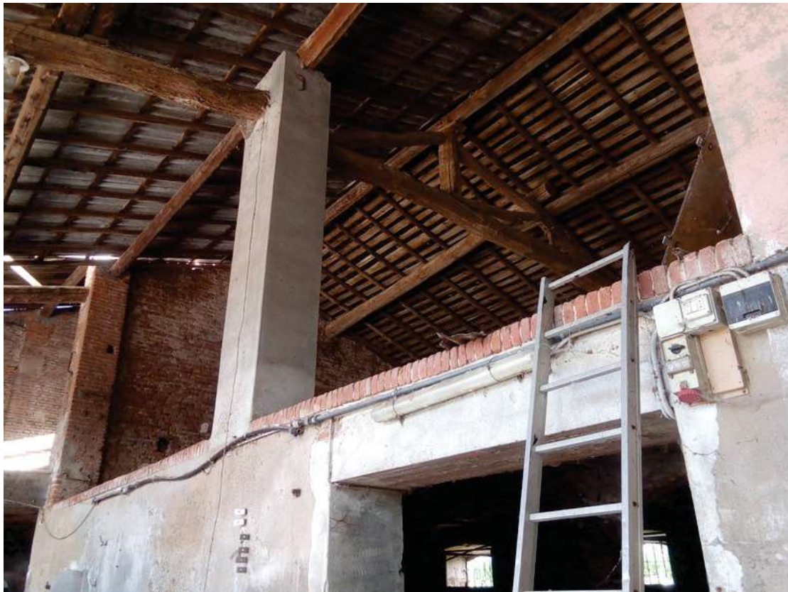
Foto 35 vista del fienile
