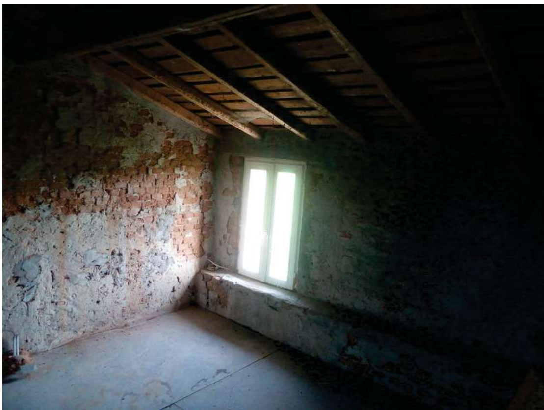
Foto 34 vista del sottotetto
