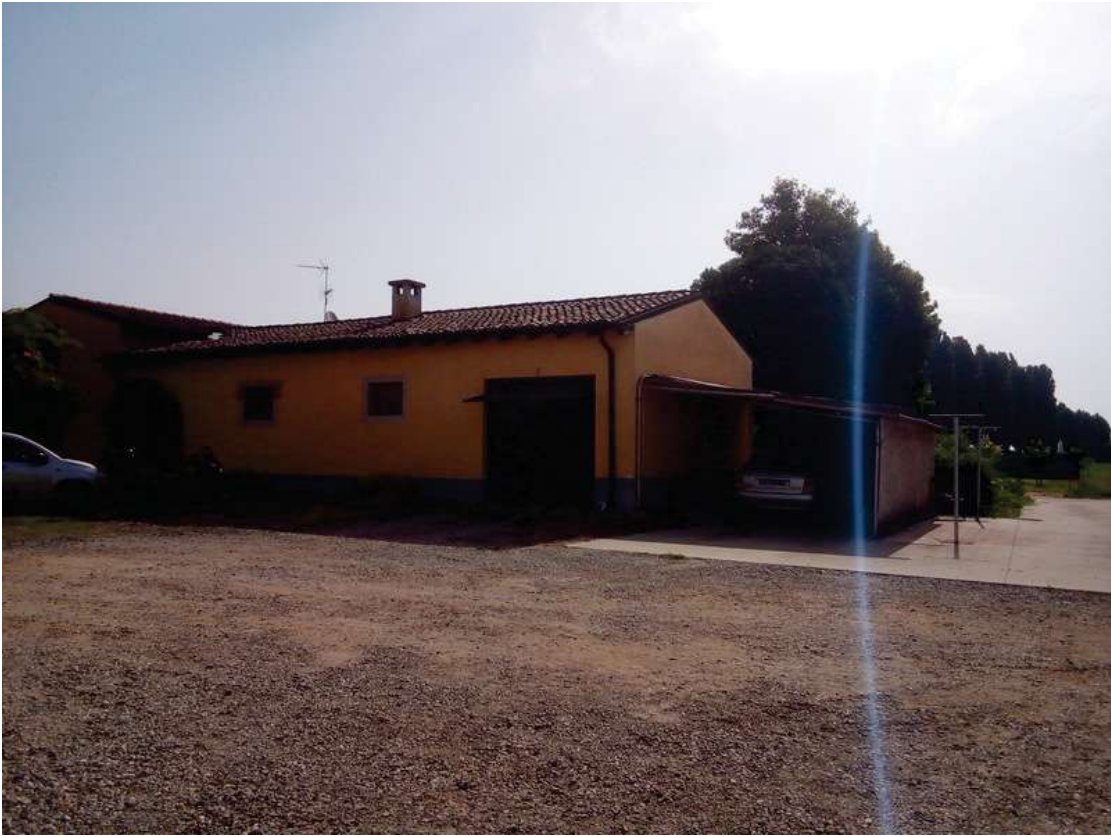
Foto 9 vista da sud
