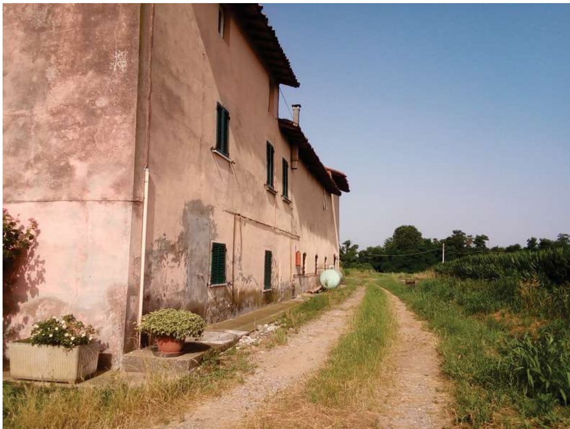
Foto 7 vista del complesso
