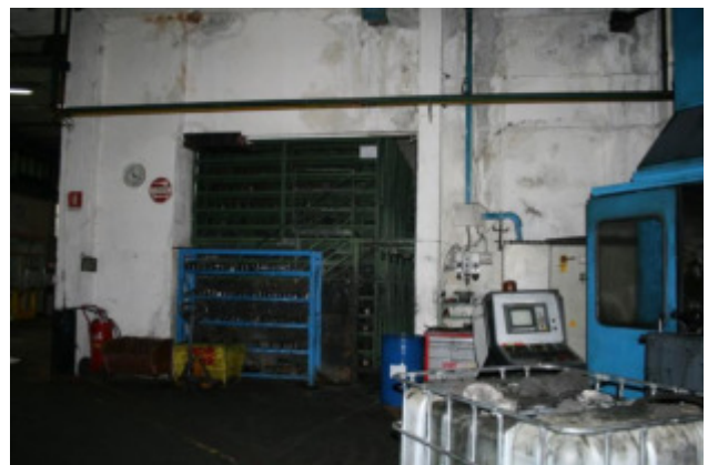
Piano primo seminterrato - lavorazione vista verso nord
