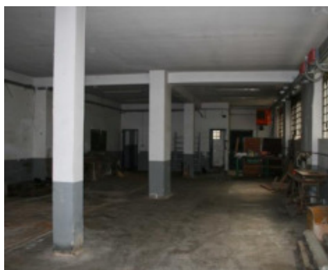
Piano secondo seminterrato - vista verso nord est
