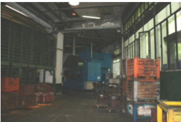
Piano primo seminterrato - lavorazione vista verso est
