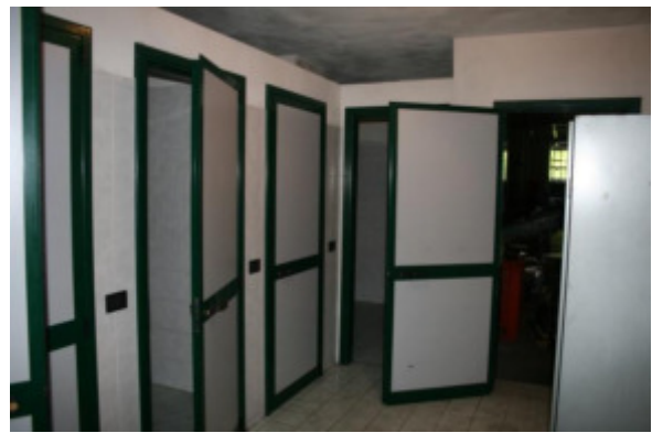
Laboratorio secondo seminterrato - blocco wc e spogliatoi (interno)
