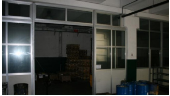
Laboratorio secondo seminterrato - vista verso nord - partizioni in alluminio vetro
