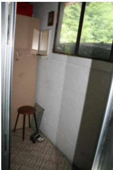
Interno uffici piano terra: ripostiglio
