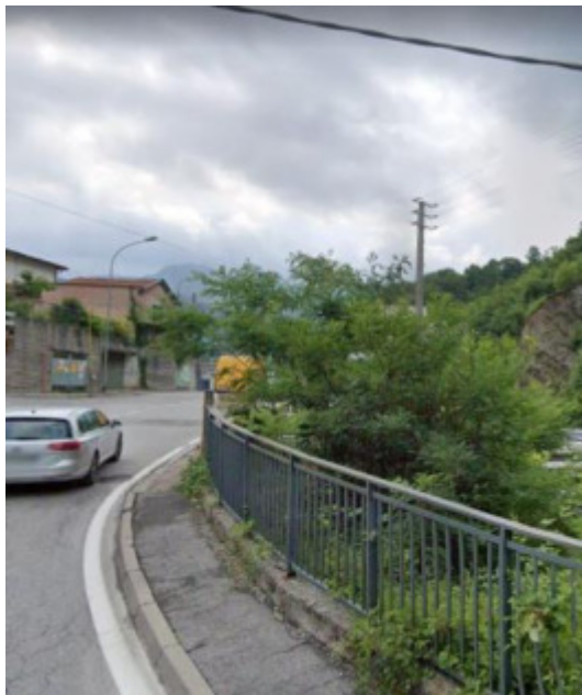
vista da Via Mainone verso nord - strada marciapiede
