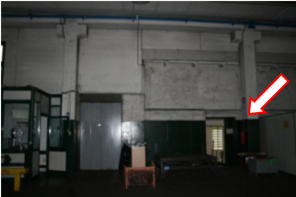
Accesso deposito da piano primo seminterrato (da LABORATORIO)
