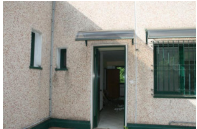
Esterni: ingresso appartamento
