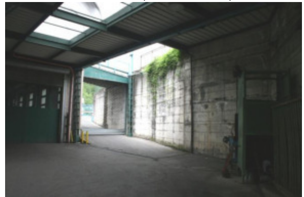
PORTICO COMUNE (piano primo seminterrato) Accesso da civico 50 - rampa carrabile
