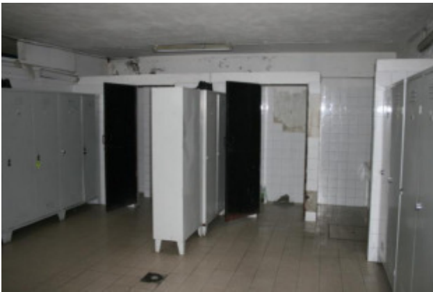
Piano ammezzato - spogliatoio vista verso nord ovest (con accesso da corte esterna)
