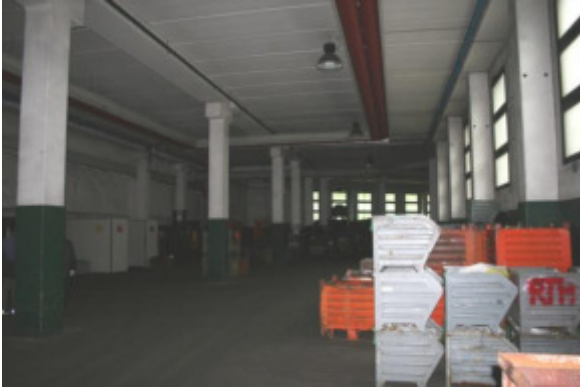
Laboratorio primo seminterrato vista verso sud ovest da ingresso portico
