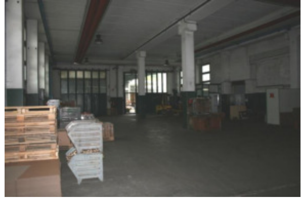
Laboratorio primo seminterrato vista verso nord est - uscita verso portico
