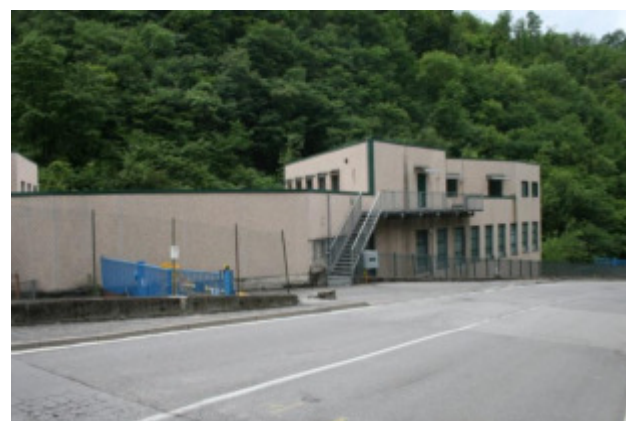
vista da Via Mainone - scala accesso per civ. 48
