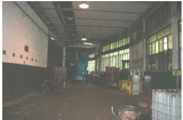
Piano primo seminterrato - laboratorio vista verso est (zona LAVORAZIONE - porzione di edificio ante 1967)
