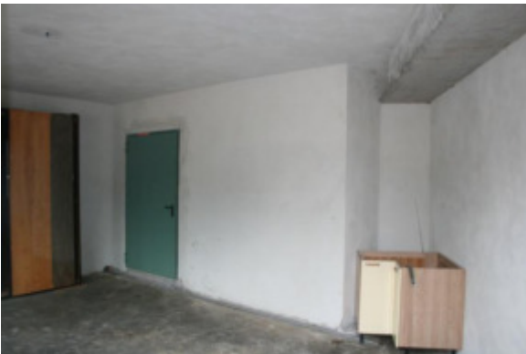
Interno uffici - porta verso vano scala (collegamento ai piani seminterrati dei laboratori)
