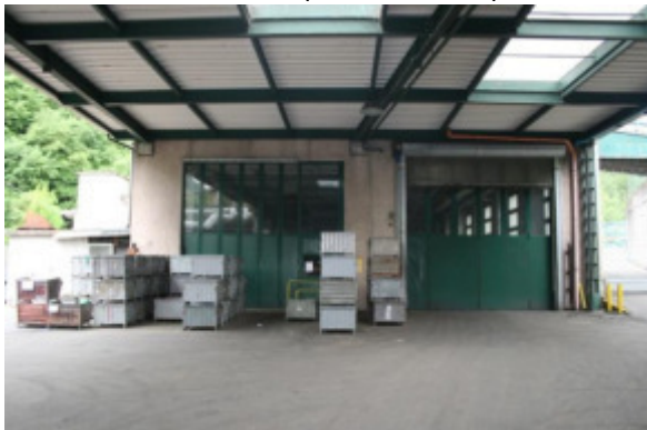
PORTICO COMUNE (piano primo seminterrato)
