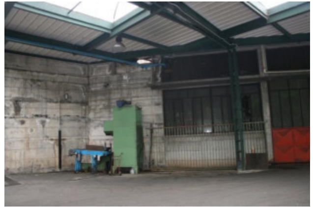
Esterni Piano primo seminterrato - portico comune con accesso da civ. 50 di via Mainone
