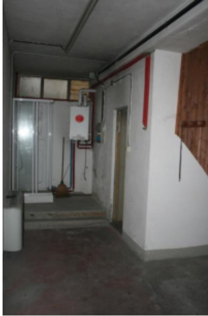
Piano interrato: ripostiglio
