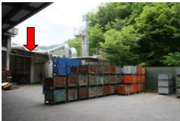
Piano primo seminterrato - TETTOIA vista dall'ingresso del portico comune
