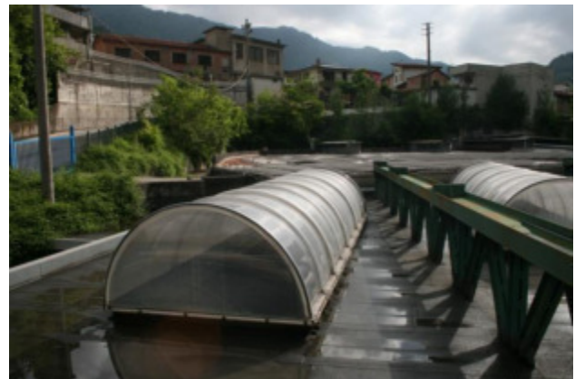
Esterni - pensilina comune
