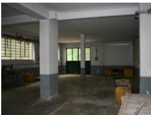
Piano secondo seminterrato - vista verso sud ovest
