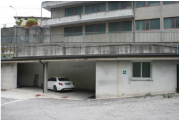
Esterni deposito: vista verso nord - uso autorimessa
