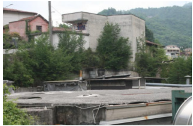
Esterni: vista parete sud
