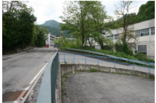
Vista da Via Mainone verso est - PORZIONE STRADA
