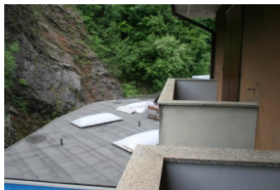
Esterni Uffici piano primo: balconi verso sud
