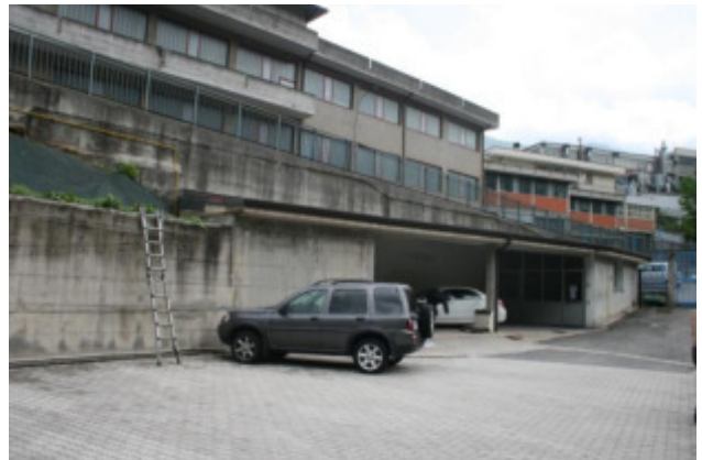
Esterni deposito: vista verso nord est
