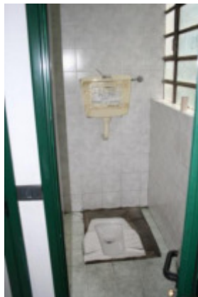
Piano primo seminterrato - interno servizi igienici
