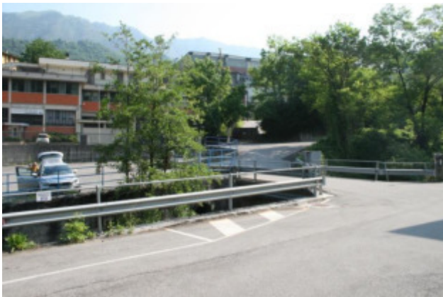
Vista verso nord est - PORZIONE STRADA
