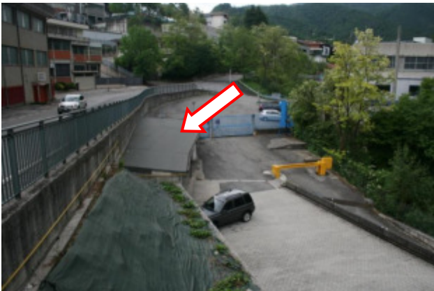
Esterni deposito: vista dall'alto verso est
