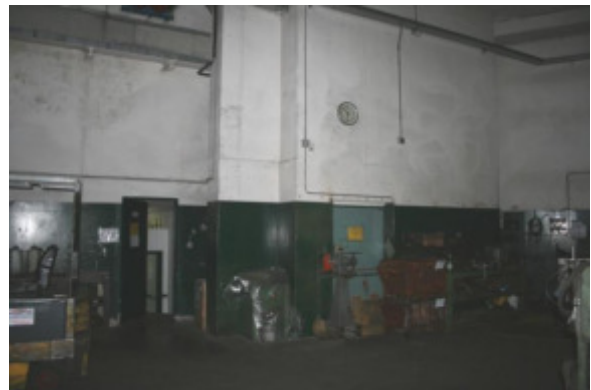
Laboratorio primo interrato vista verso sud (a sx porta verso wc nel blocco DEPOSITO - a dx porta verso vano scala)
