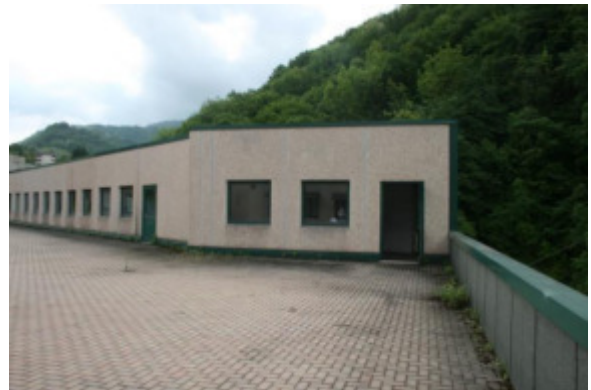
Terrazzo vista verso sud
