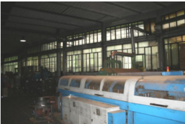
Piano primo seminterrato - laboratorio vista interna verso sud
