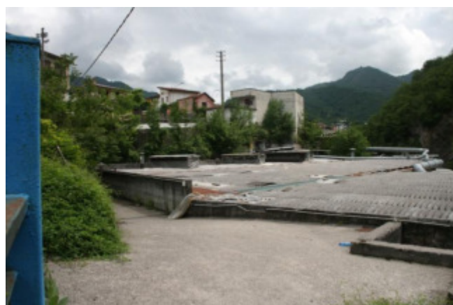
Copertura LABORATORIO Vista da civ. 52a
