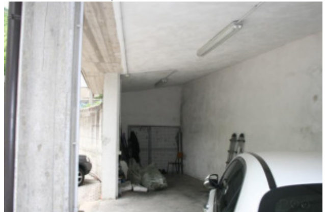
Deposito: lato ovest - uso autorimessa
