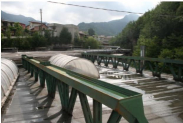
Esterni - pensilina comune
