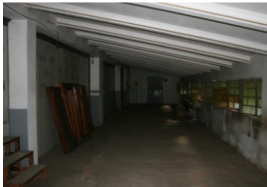
Piano terra - interno deposito vista verso sud ovest
