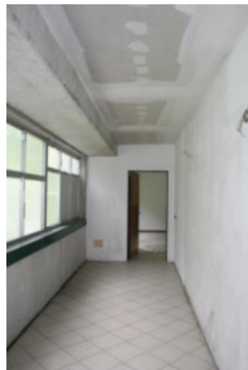
Appartamento piano terra: corridoio collegamento con terrazzo esterno - vista verso appartamento
