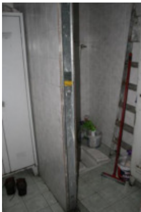
Piano primo seminterrato - interno servizi igienici
