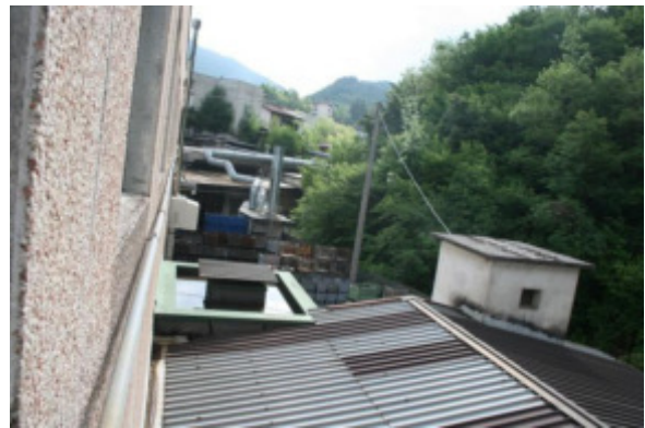
Esterni_ vista copertura verso nord est
