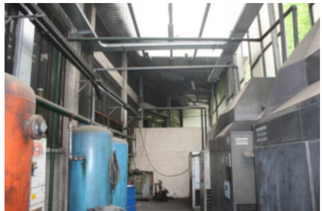
Piano primo seminterrato_ tettoia vista verso est
