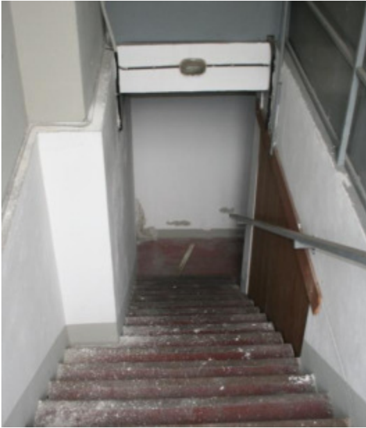
Piano terra: scala verso piano interrato
