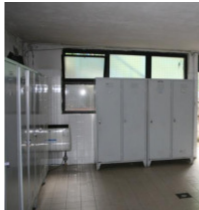
Piano ammezzato - spogliatoio vista verso sud est (con accesso da corte esterna)
