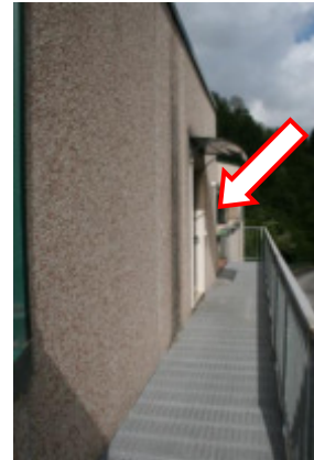
Esterni: ingresso appartamento
