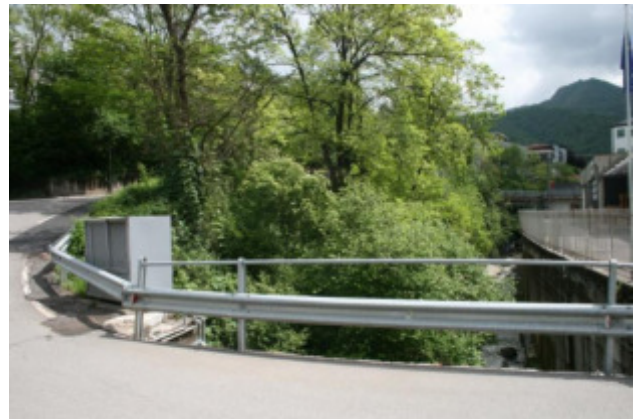
Vista dal ponte verso est - PORZIONE TERRAPIENO TORRENTE GOBBIA
