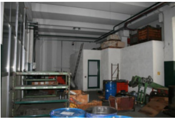
Laboratorio secondo seminterrato - blocco wc e spogliatoi
