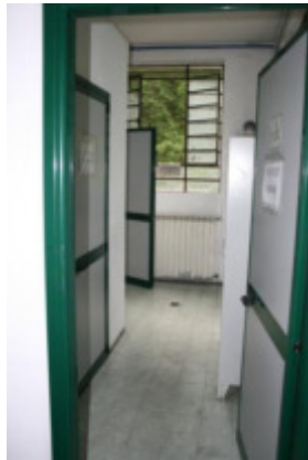
Piano primo seminterrato - interno servizi igienici
