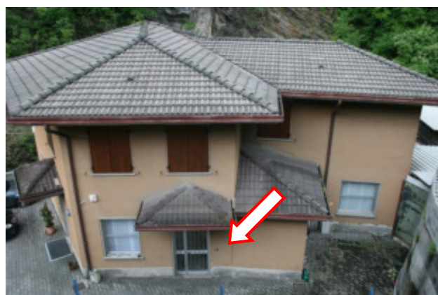
Esterni Uffici piano primo: ingresso da piano terra
