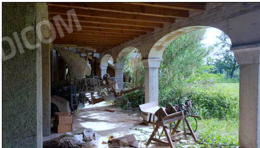
PORTICO AL PIANO TERRA ABITAZIONE
