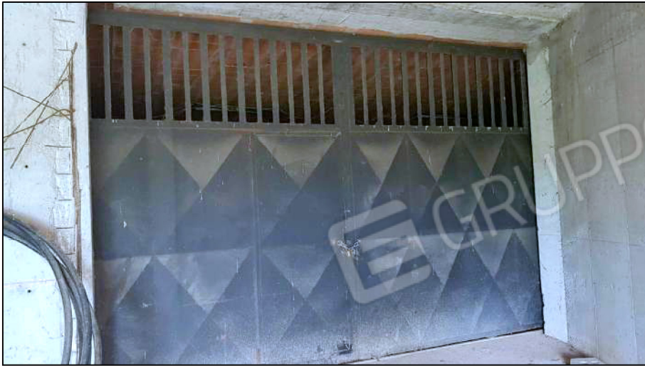
ACCESSO CARRAIO PIANO INTERRATO
