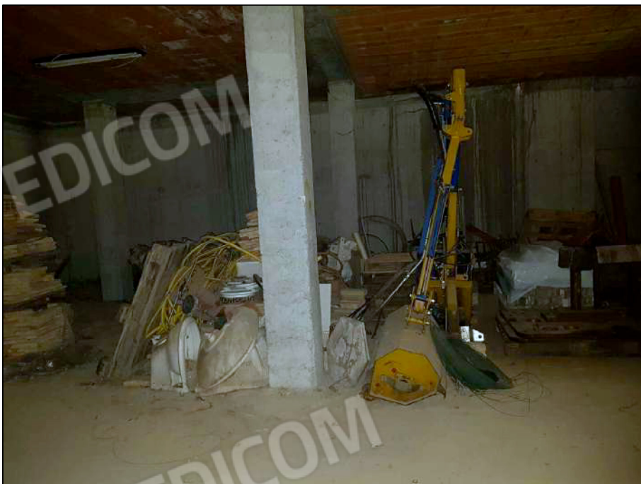
INTERNO PIANO INTERRATO
