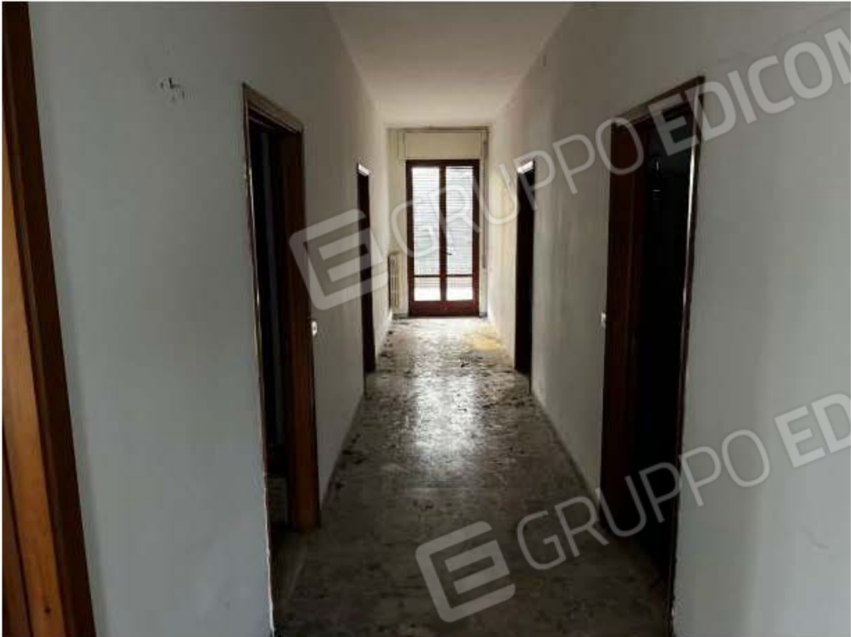
CORRIDOIO PIANO PRIMO
