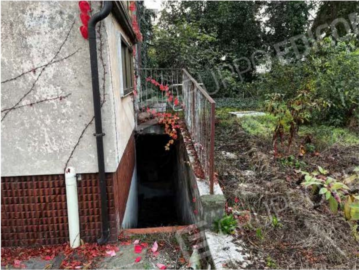
SCALA DI ACCESSO AL PIANO INTERRATO POSTA SU ALTRA PROPRIETA'
