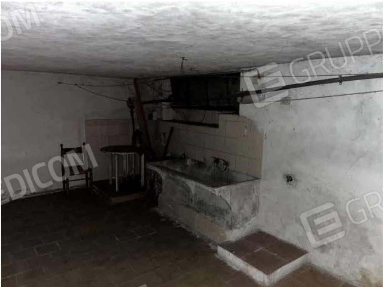
INTERRATO – LOCALE DI SGOMBERO
