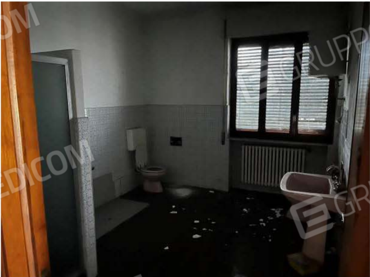
BAGNO AL PIANO PRIMO
