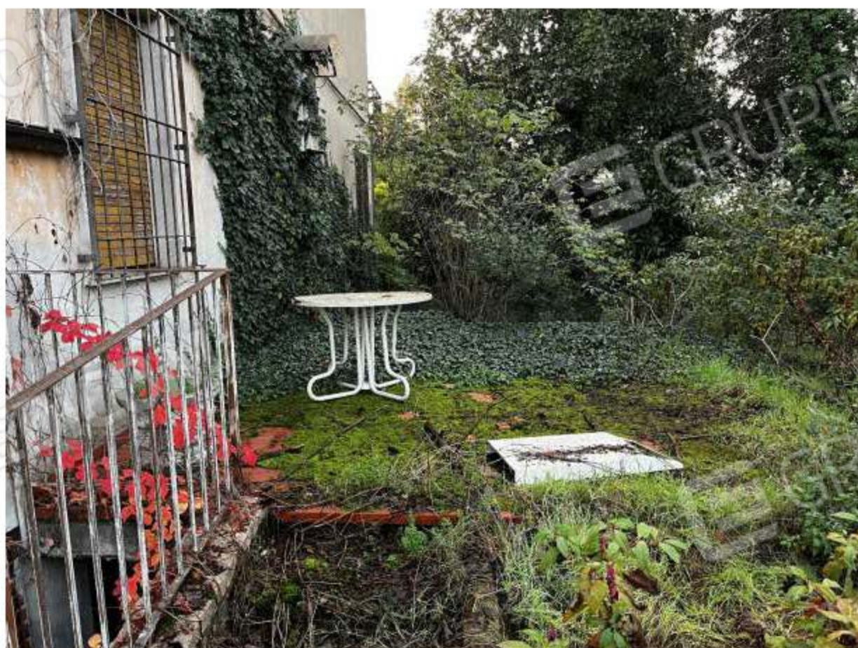
PAVIMENTO ESTERNO COMPLETAMENTE COPERTO DAL VERDE
