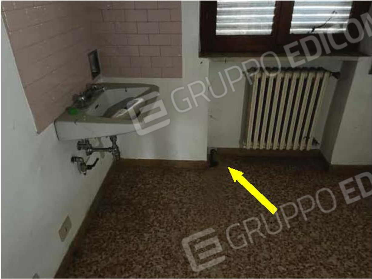
LOCALE LAVANDERIA – PARTICOLARE SCARICO ESTERNO
