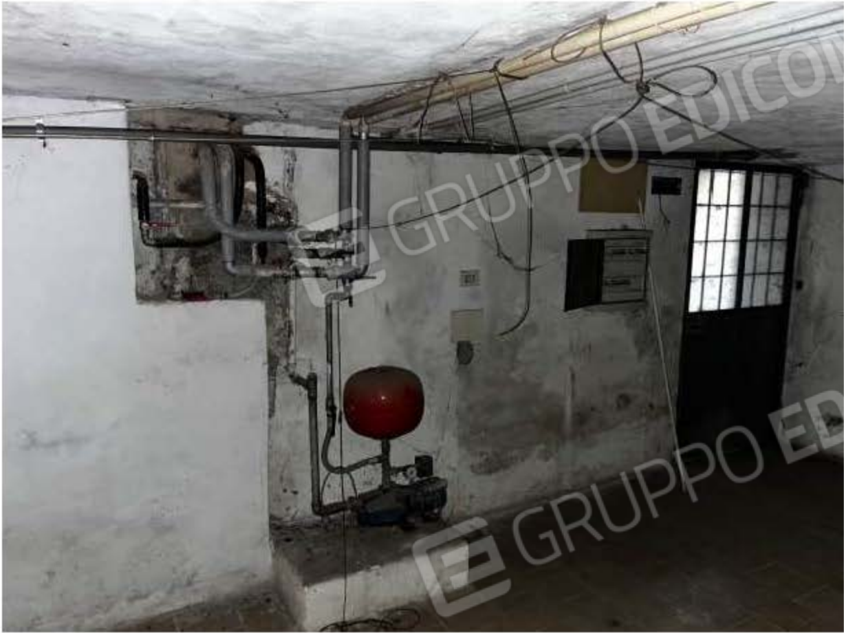
INTERRATO – LOCALE DI SGOMBERO
