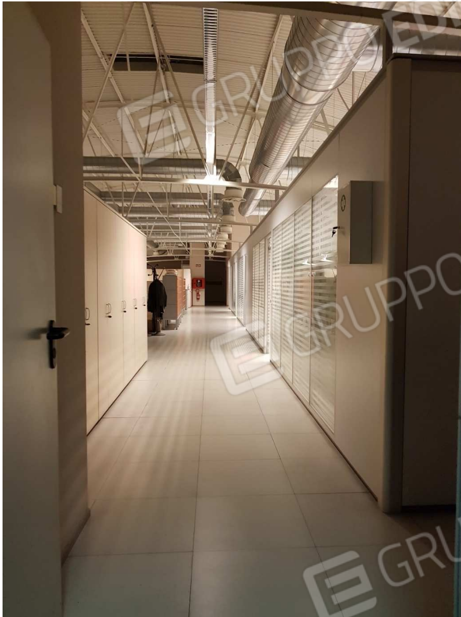
Zona uffici al piano primo oggetto di ristrutturazione nel 2006
