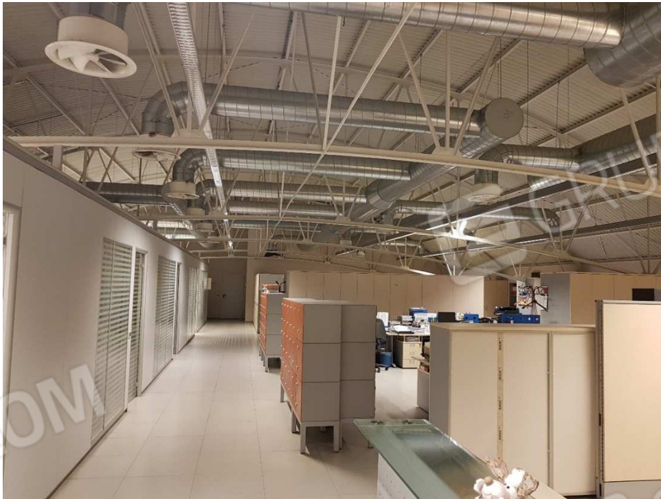
Uffici al piano primo oggetto di ristrutturazione nel 2006
