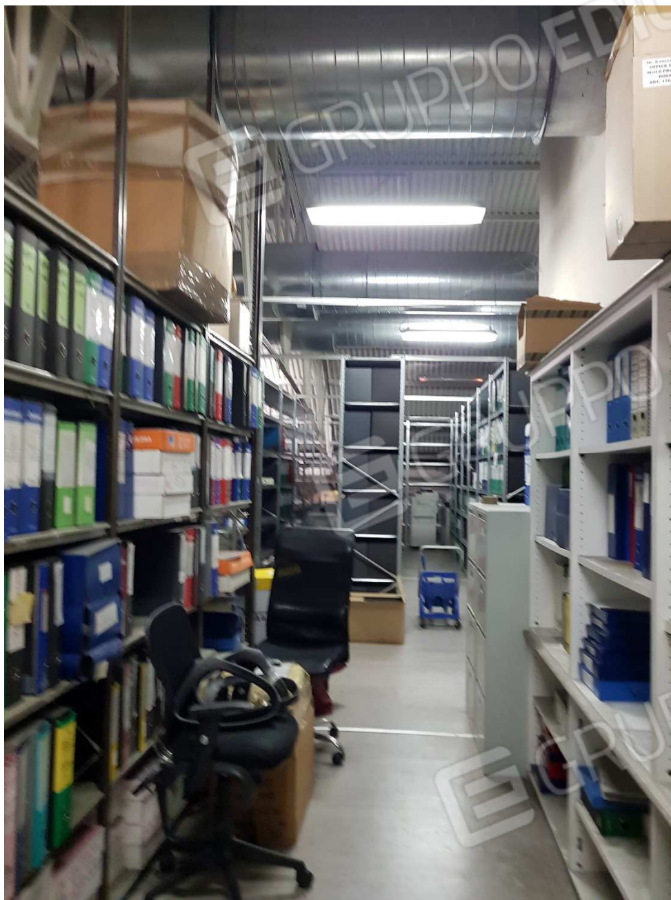
Archivio zona uffici al piano primo oggetto di ristrutturazione nel 2006
