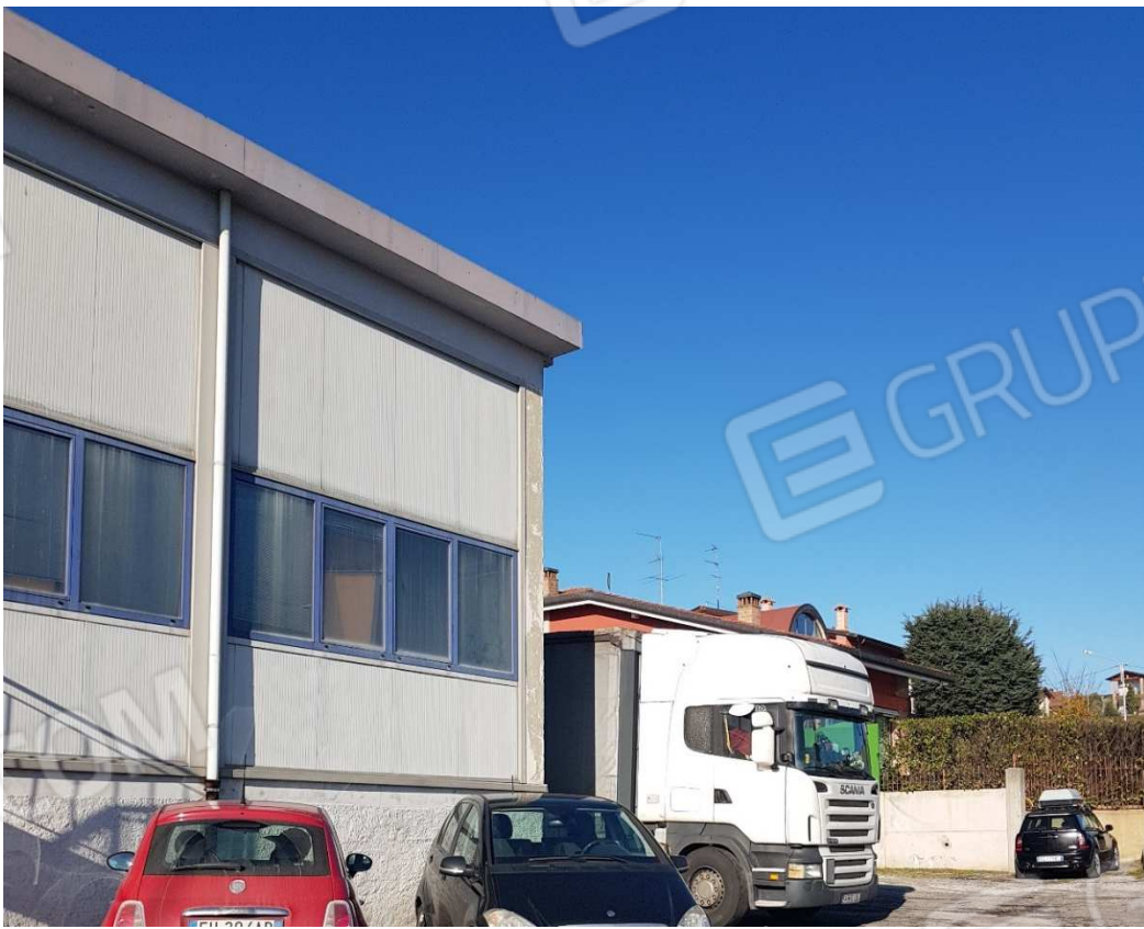
Esterni lato Sud
