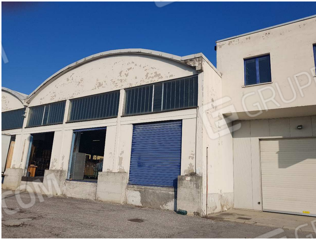
Esterni lato Sud
