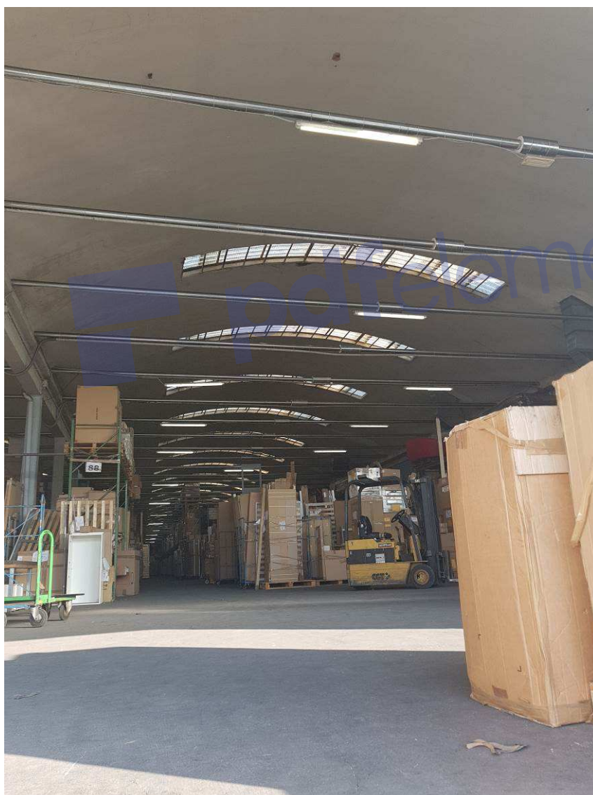
Interno del magazzino
