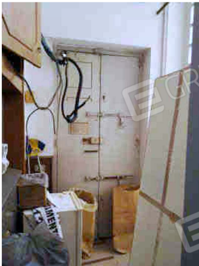
Fotografia 31 – Lotto 7 di 8 – Sub. 25; piano Terra; uscita verso Contrada della Mansione.
