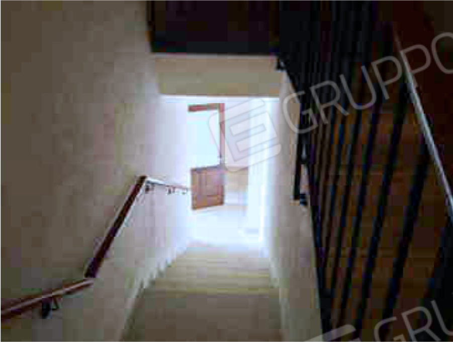
Fotografia 7 – Parti comuni sub.18 – Centrale Termica Teleriscaldamento
