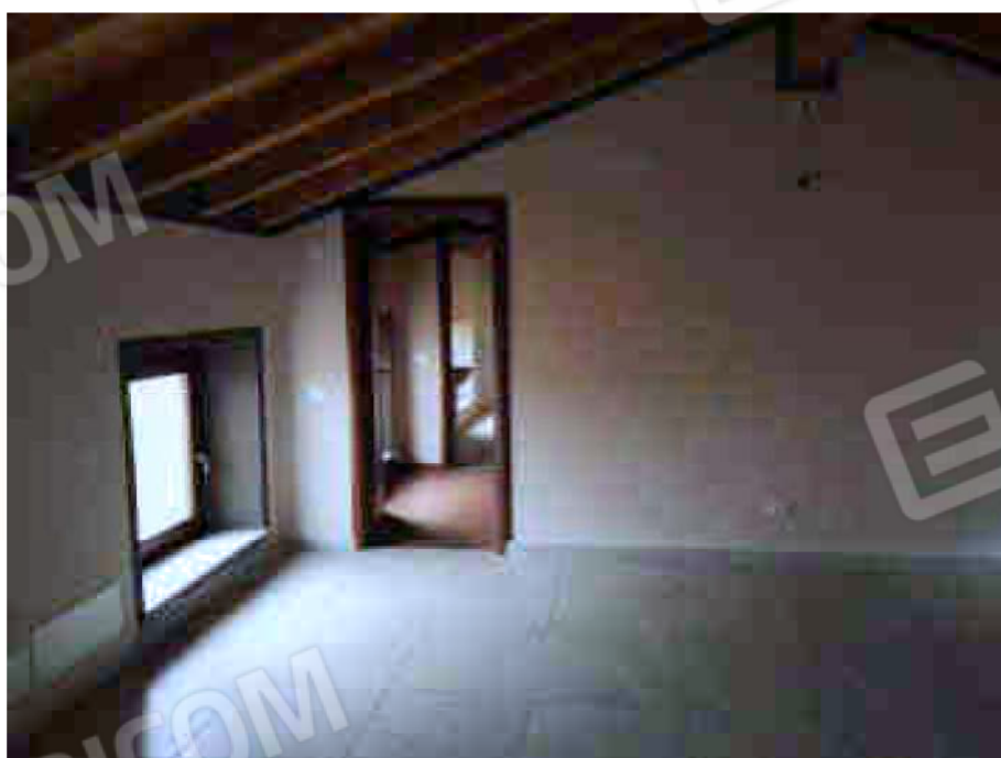
Fotografia 21 – Lotto 6 di 8 -Unità al piano Sottotetto sub. 28.
