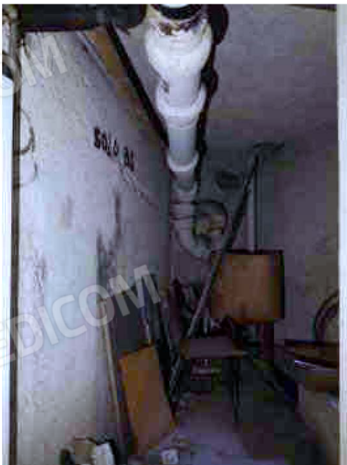
Fotografia 34 – Lotto 7 di 8 – Sub. 25; piano Interrato.
