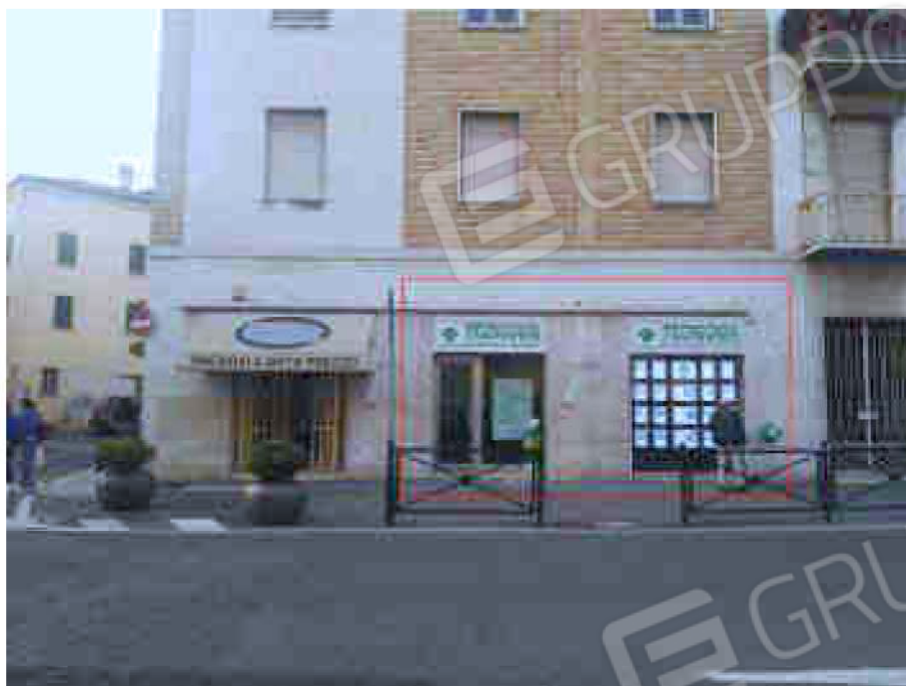
Fotografia 27 – Lotto 7 di 8 –Sub. 25; vista dalla strada vetrine.
