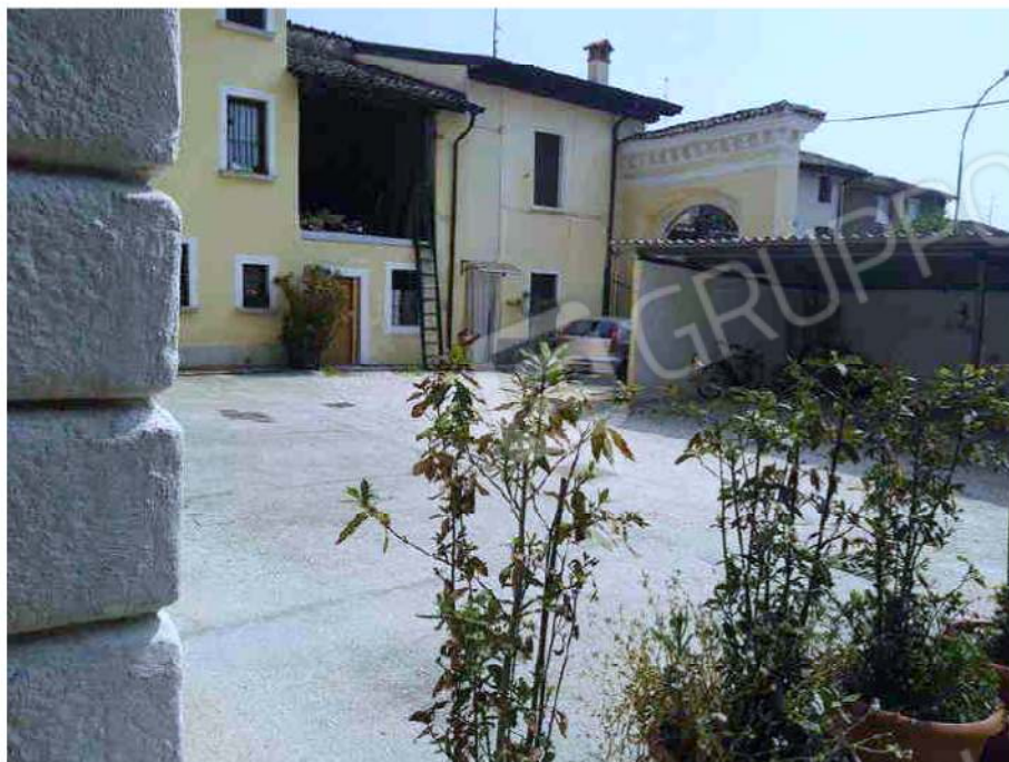
Fotografia 5 – Vista Corte Interna
