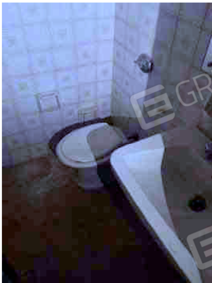
Fotografia 37 – Lotto 7 di 8 – Sub. 25; piano Int.
