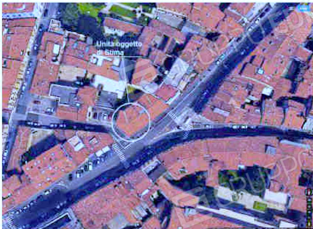
Fotografia 25 – Vista Aerea con evidenziazione fabbricato sede unità oggetto i Stima in Brescia
