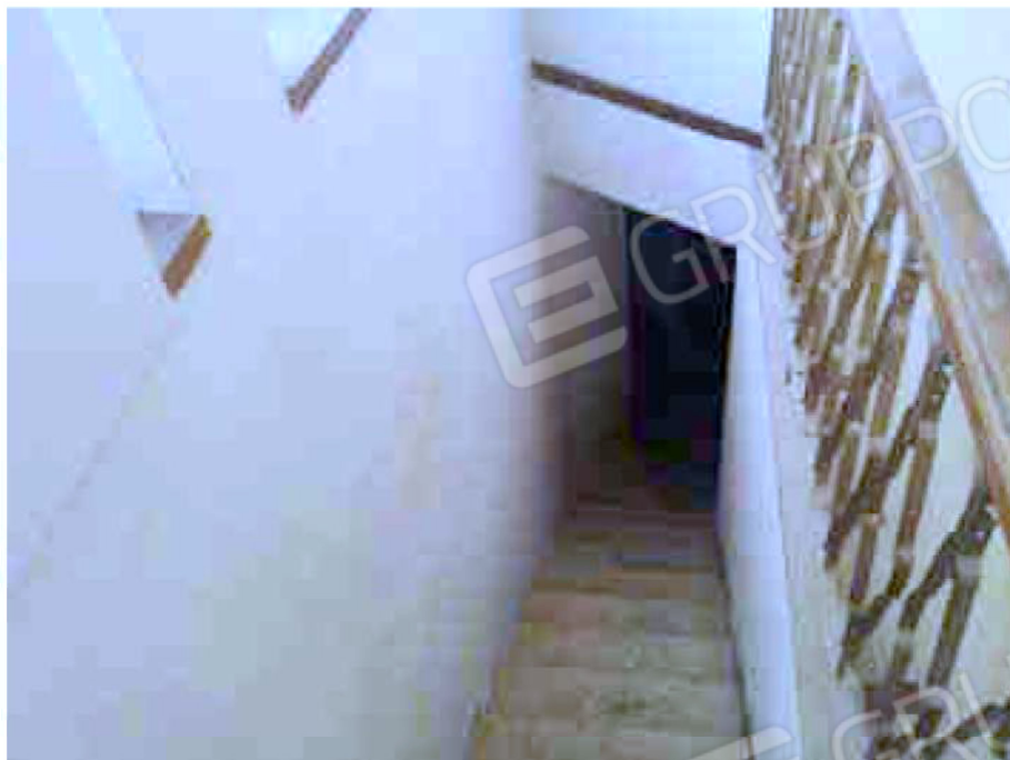
Fotografia 33 – Lotto 7 di 8 – Sub. 25; piano Terra; scale per il piano Interrato.
