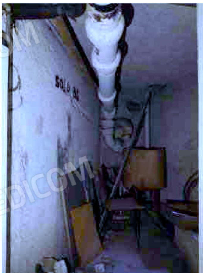
Fotografia 34 – Lotto 7 di 8 – Sub. 25; piano Interrato.
