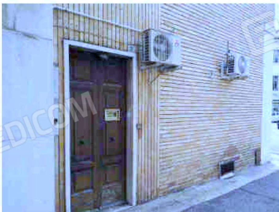
Fotografia 32 – Lotto 7 di 8 – Sub. 25; piano Terra; accesso da Contrada della Mansione.
