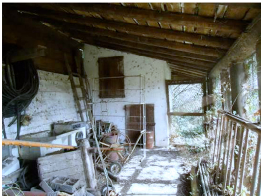
Esterno ripostiglio sub. 6
