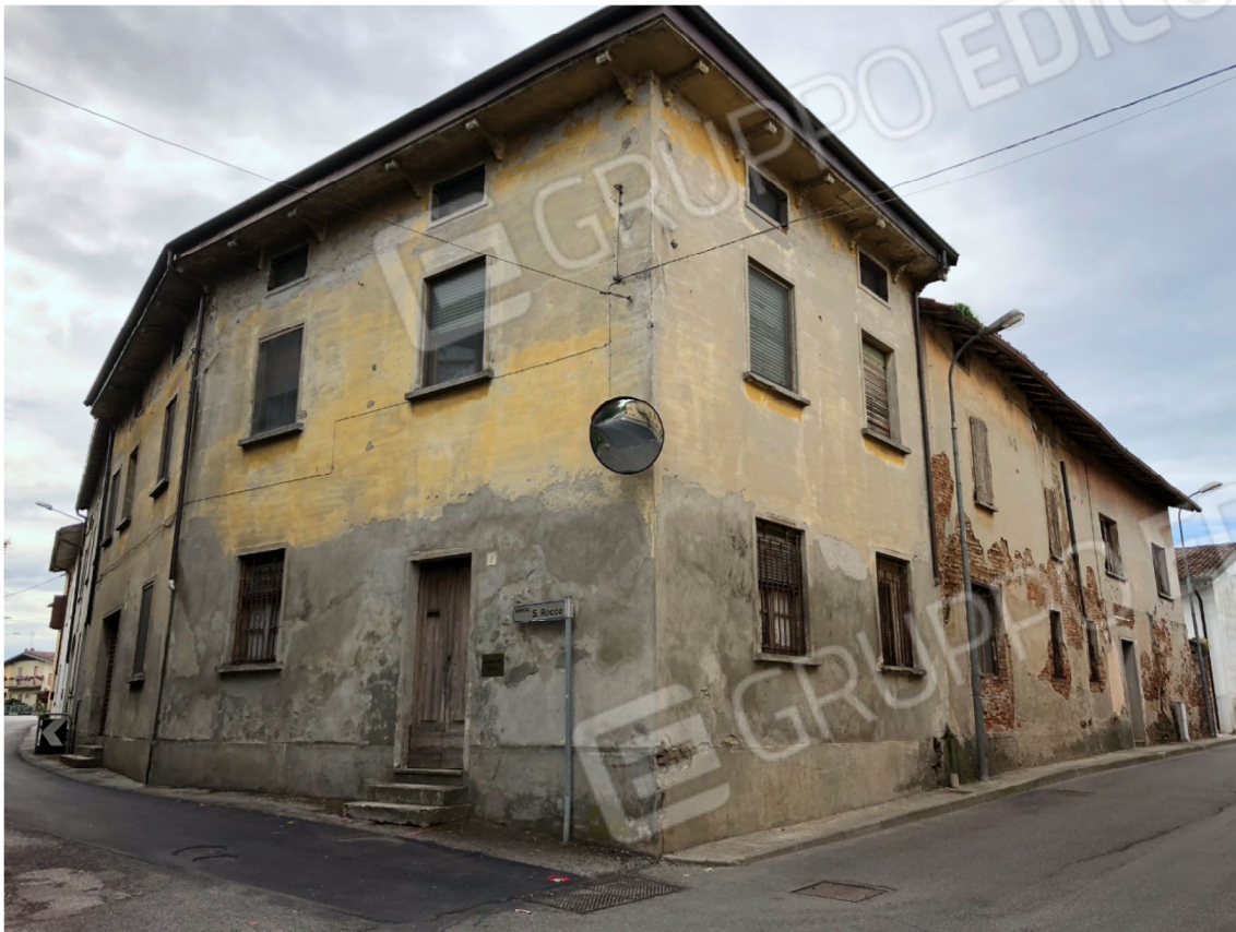
- Vista Lato Nord-Ovest
