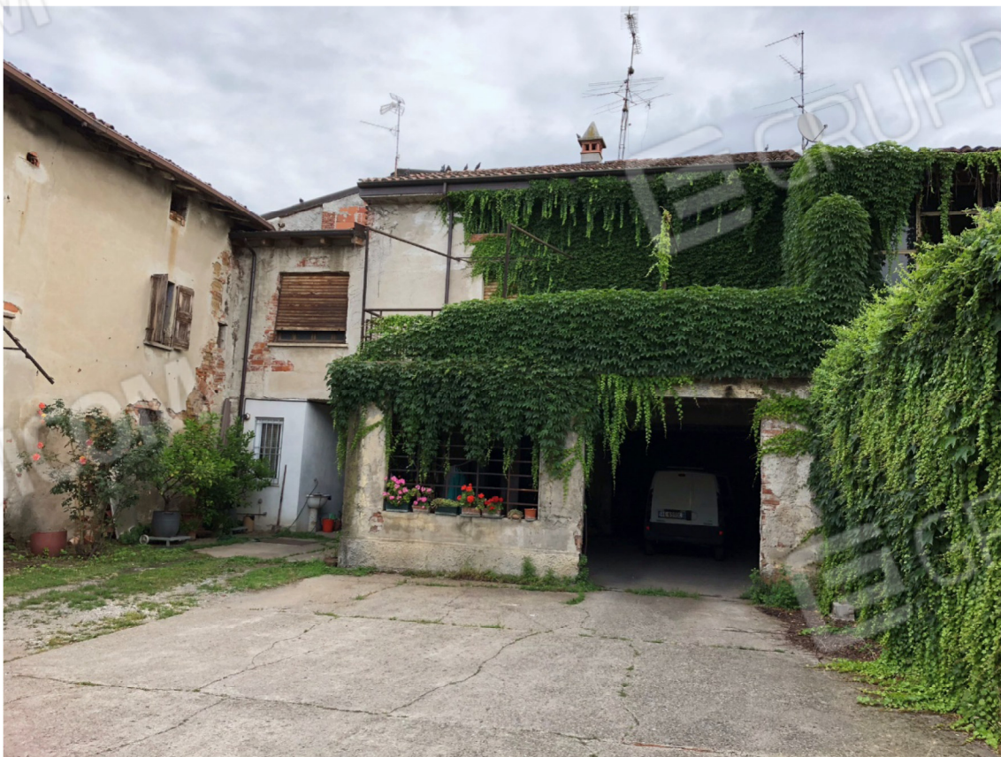
- Vista Lato Sud
