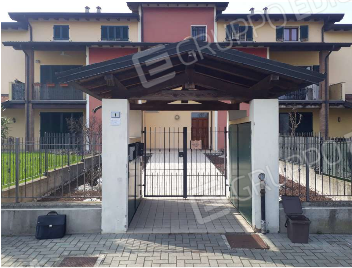
1) Fotografia riprendente l'ingresso pedonale al Condominio in via Dott. Cernigliaro n° 1.
