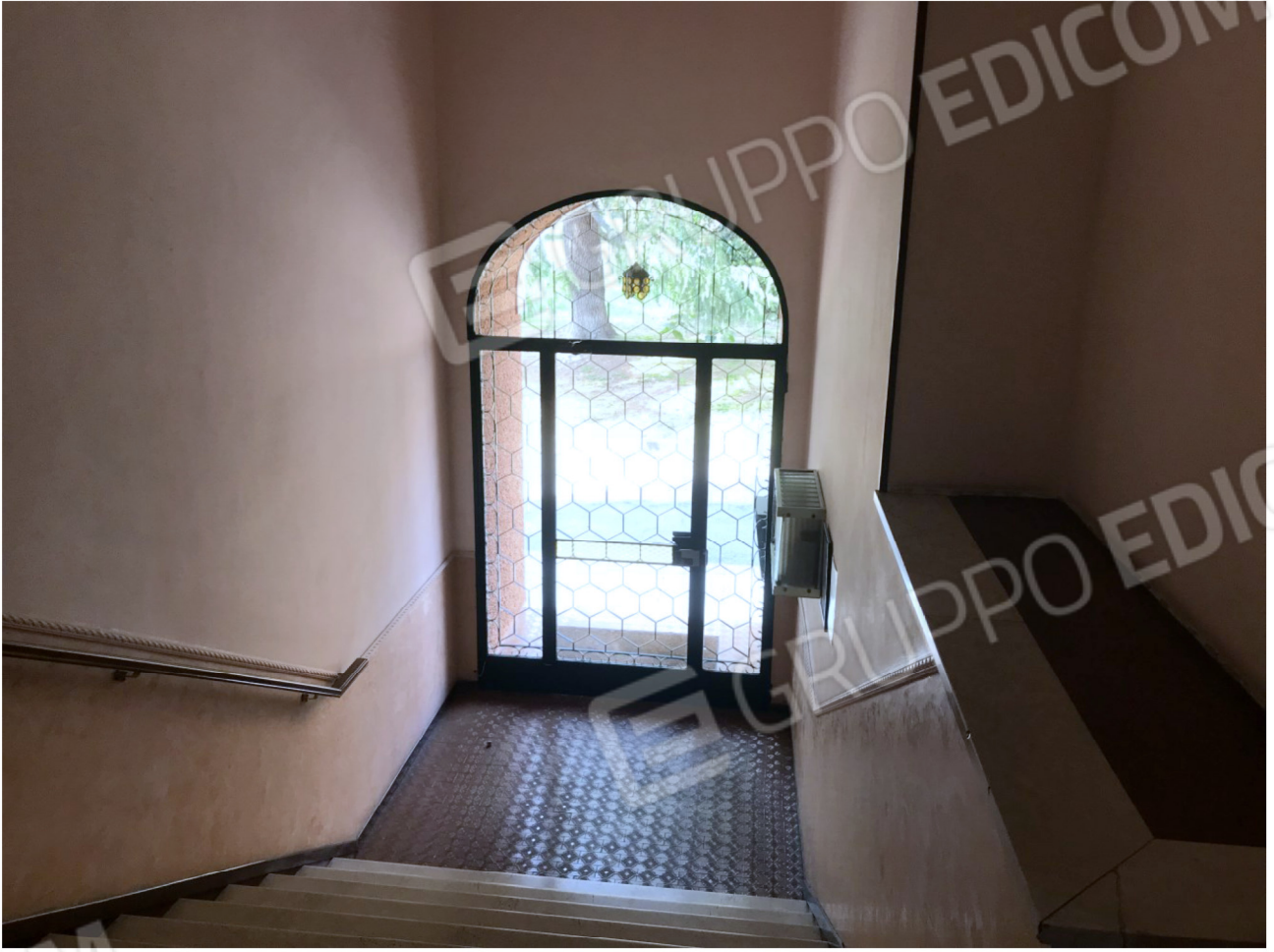
Ingresso vano scale
