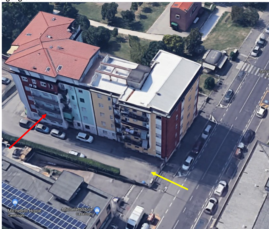
Indicato in freccia rosso l'appartamento staggito al piano primo (scala B) del "Condominio Bosco" e in freccia gialla l'ingresso pedonale e carraio al condominio.
