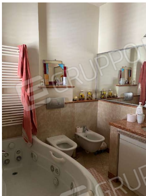
Bagno – Piano primo
