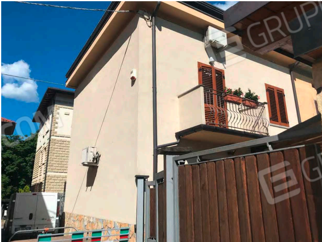
Foto 2: Vista esterna: retro
